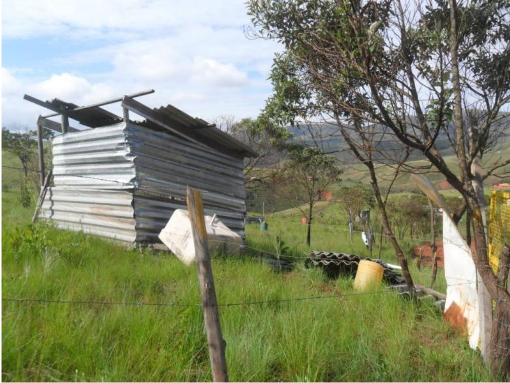
FIGURA 14- VISTA PARCIAL DE EDIFICAÇÃO PRECÁRIA EM ÁREA INVADIDA OBSERVADO NA PORÇÃO NOROESTE DA BACIA DO RIO ITABIRITO. FONTE: MYR PROJETOS, 2013.
