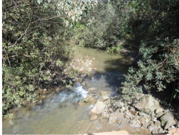
FIGURA 21. RIBEIRÃO SARDINHA SOB PONTE NA MG030, A MONTANTE DO DISTRITO DE ENGENHEIRO CORREIA. FONTE: MYR PROJETOS, 2013
