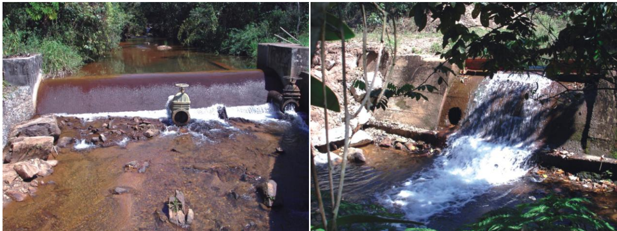
FIGURA 114. PONTOS DE CAPTAÇÃO NO MUNICÍPIO DE ITABIRITO, (A) CÓRREGO DO BAÇÃO; (B) CÓRREGO SECO E (C) BARRAGINHA.
