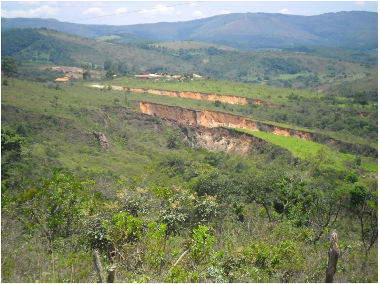
FIGURA 66 - VISTA PANORÂMICA DE PROCESSOS EROSIVOS EM ELEVADO ESTÁGIO - PORÇÃO LESTE DA BACIA DO RIO ITABIRITO. FONTE: MYR PROJETOS, 2013.
