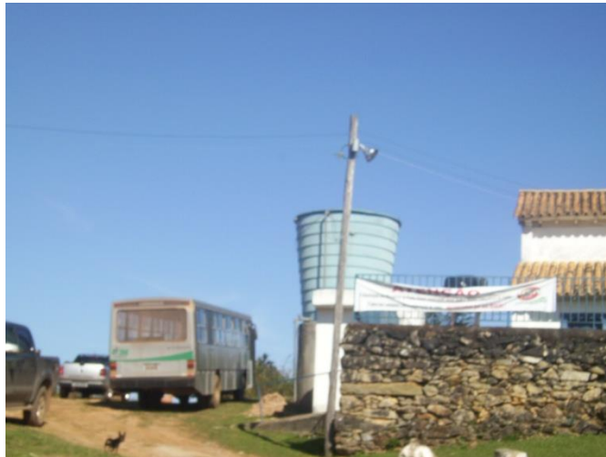
Figura 4.7 – Reservatório de abastecimento de água – Distrito de Penedia Fonte: Cobrape, 12/06/13
