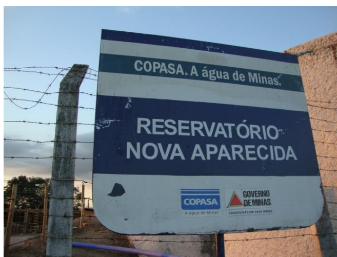
Figura 4.6 – Reservatório Apoiado Nova Aparecida da COPASA, para atendimento ao Distrito de mesmo nome. Fonte: COBRAPE, 21/05/13.
