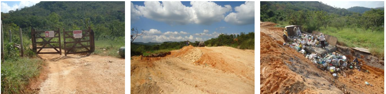
Figura 4.10: Área do lixão de Taquaraçu de Minas. Fonte: COBRAPE, 21/05/13.
