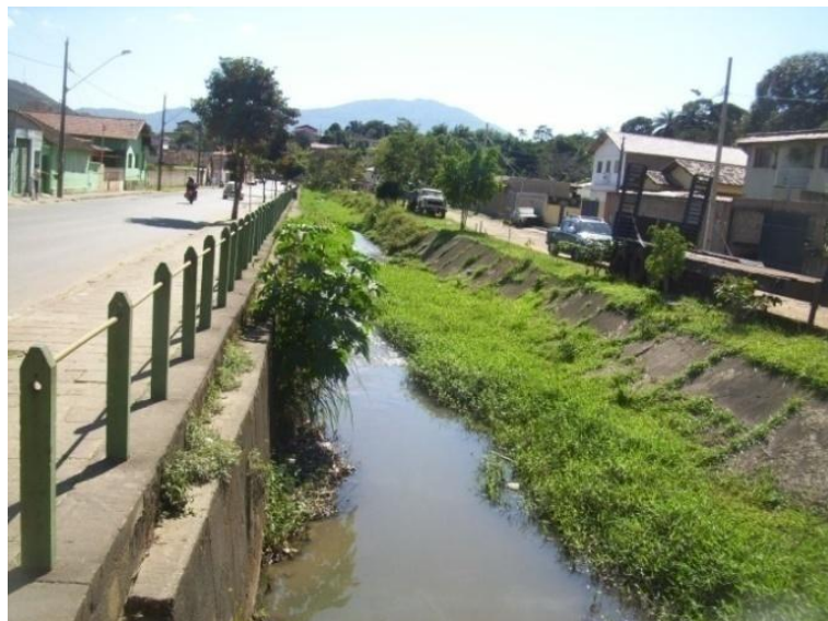
Figura 7.21 - Córrego Caeté no centro da cidade, em canalização aberta
