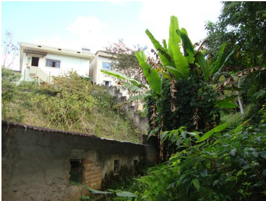
Área de ocupação irregular e risco de deslizamento no Bairro Vila Rato
