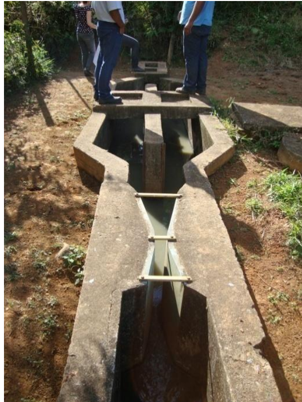
Figura 7.76 - Sistema Tratamento preliminar
