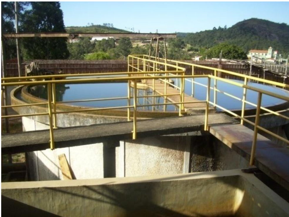
Figura 7.62 - Vista do decantador
