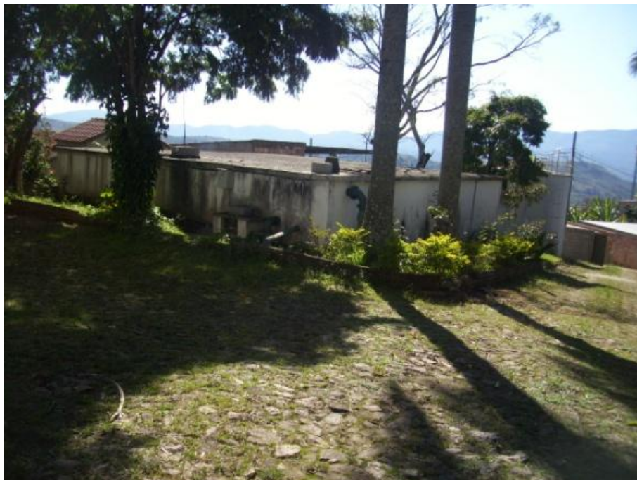
Figura 7.65 - Reservatório de distribuição
