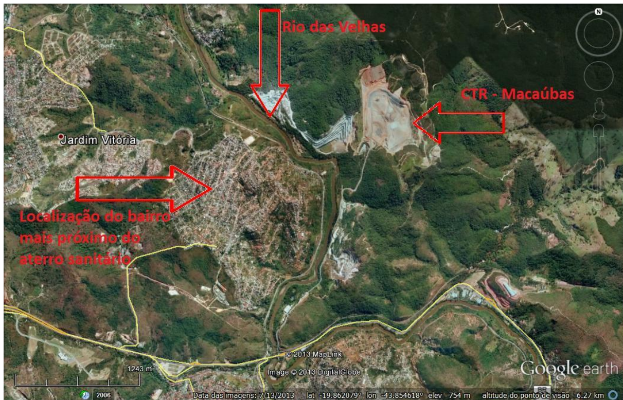
Figura 7.107 - Vista aérea do acesso ao CTR Macaúbas e ocupação das proximidades
