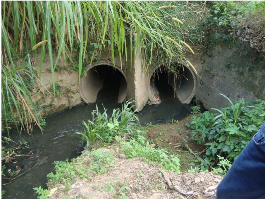
Bueiros sob a Avenida João Pinheiro (montante)
