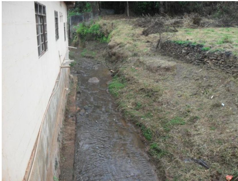
Figura 7.87 - Lançamentos de esgoto in natura
