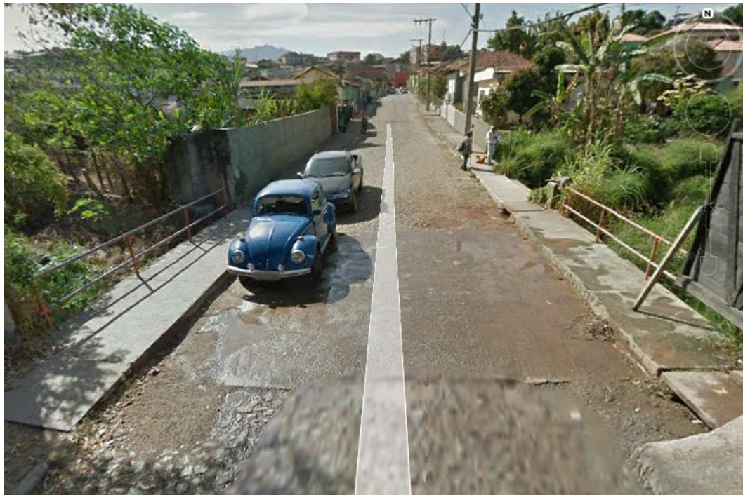
Figura 7.119 - Córrego Pedra Branca – travessia na Rua Pedra Verde
