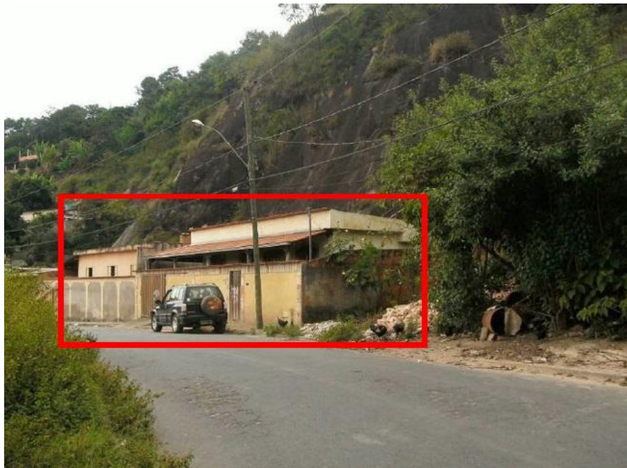
Ocupações em situação de risco no Bairro Bonsucesso
