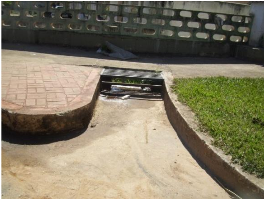
Figura 7.123 - Boca-de-lobo na Avenida João Pinheiro
