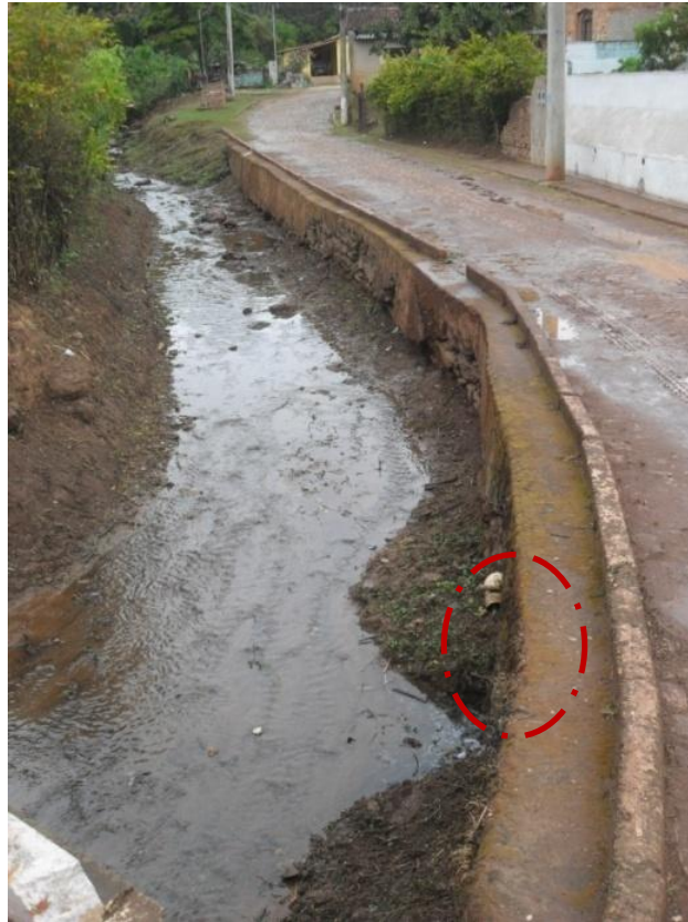
Figura 7.88 - Ponto de lançamento de esgoto
