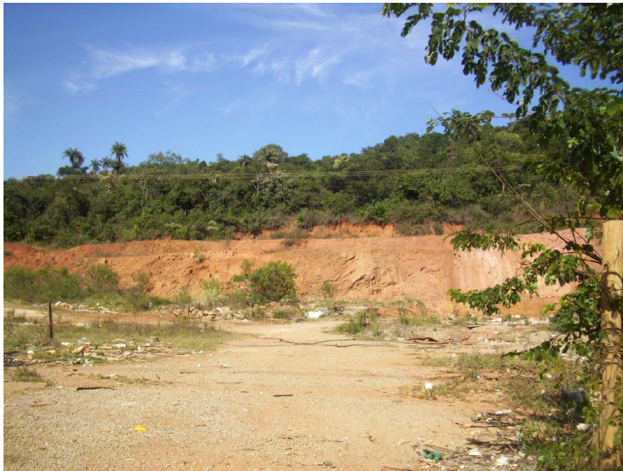
Taludes descobertos em terreno próximo ao Conjunto Habitacional Minha Casa Minha Vida
