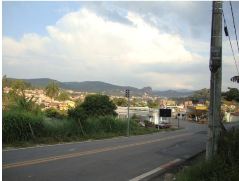
Figura 7.52 - Estrada de asfalto
