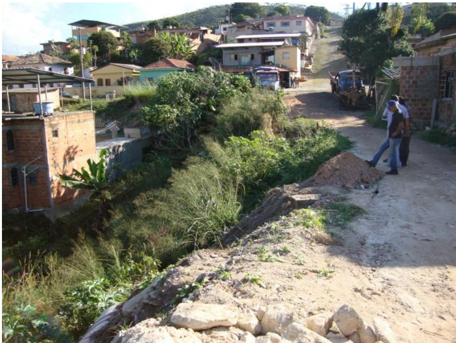
Área de risco de deslizamento junto à Rua Hortência
