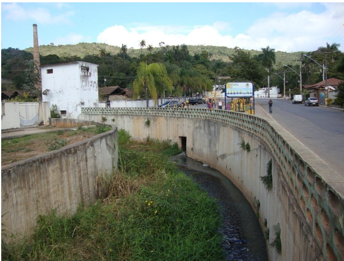
Início da canalização do Córrego Caeté nas proximidades da CPRM
