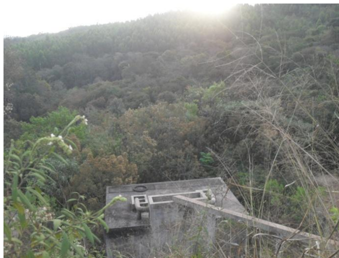
Figura 7.85 - Vista superior do reator UASB inoperante da ETE Santa Frutuosa
