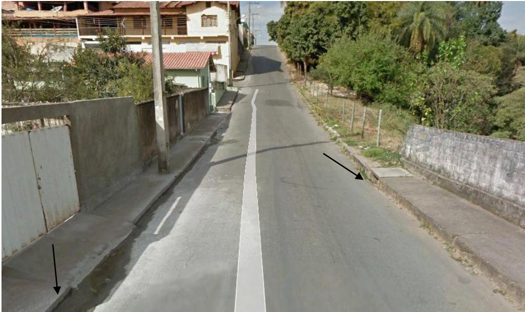
Figura 7.124 - Bocas-de-lobo da galeria da Rua Violeta
