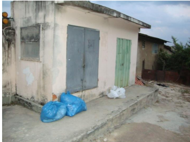
Figura 7.108 - Resíduos dos serviços de saúde armazenados indevidamente na Santa Casa de Caeté
