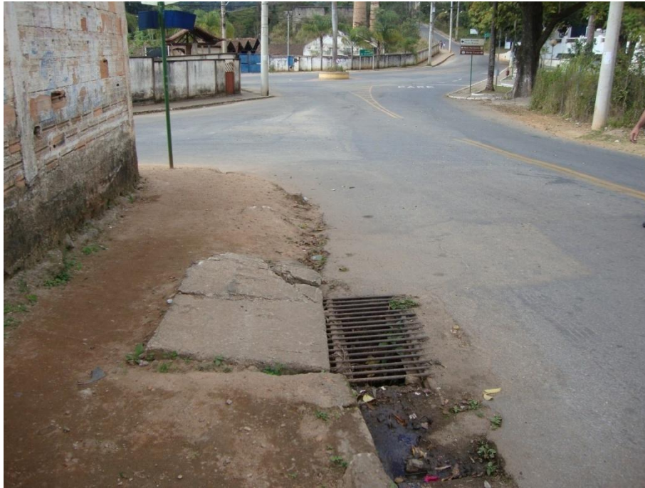
Figura 7.122 - Boca-de-lobo da galeria da Rua José Cerqueira
