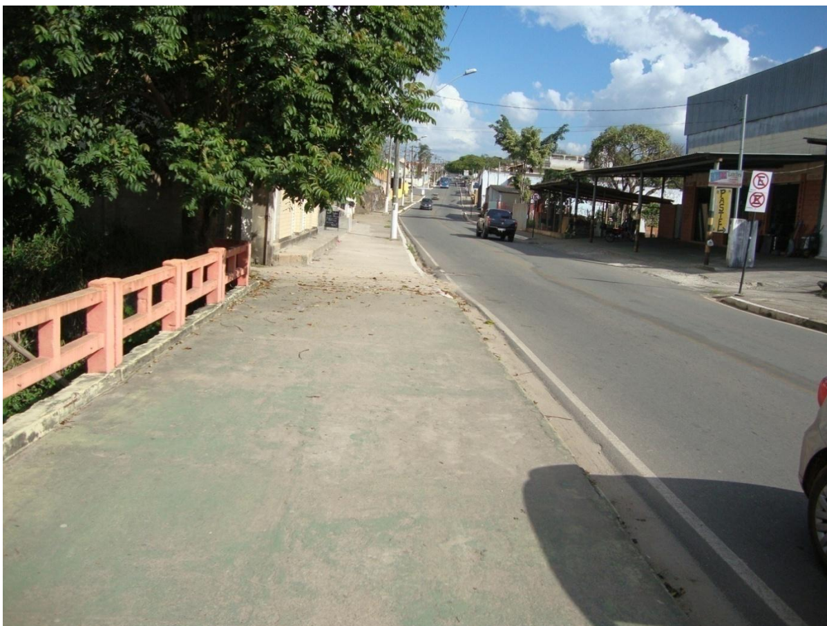
Ponte sobre o Córrego Caeté
