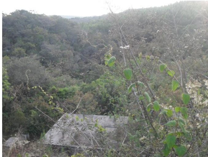
Figura 7.84 - Panorama de abandono das unidades inacabadas da ETE Santa Frutuosa
