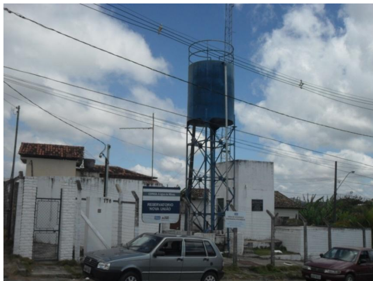
Figura 7.61 – Reservatórios da área central de Nova União
