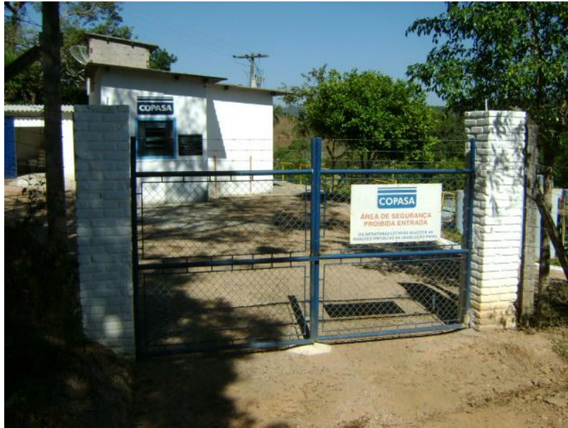
Figura 7.58 - Acesso à ETA Nova União
