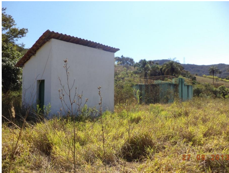
Figura 7.82 - Vista geral da ETE Nova Esperança
