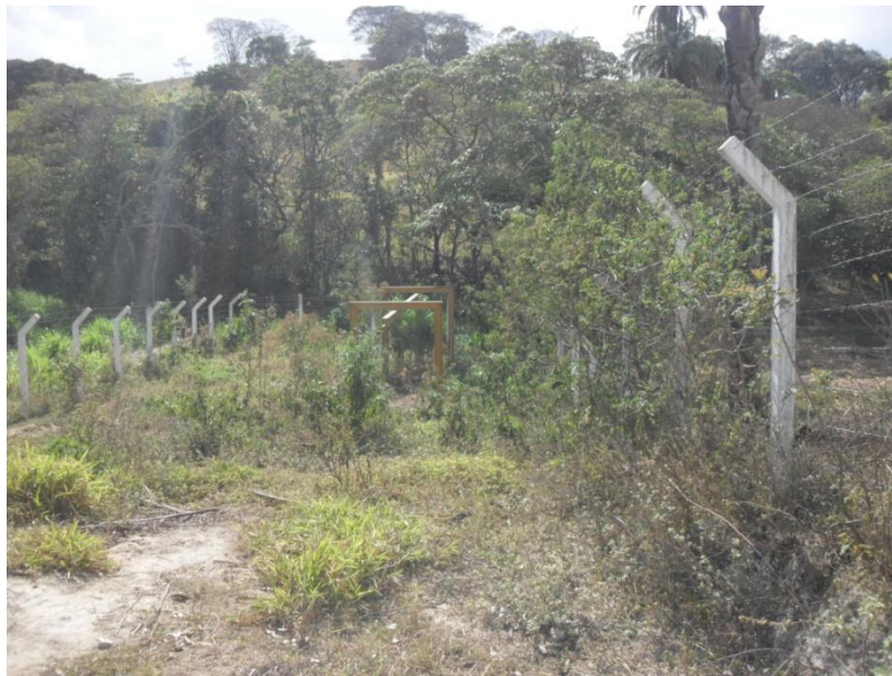
Figura 7.79 - Elevatória 1 para a ETE Nova Esperança
