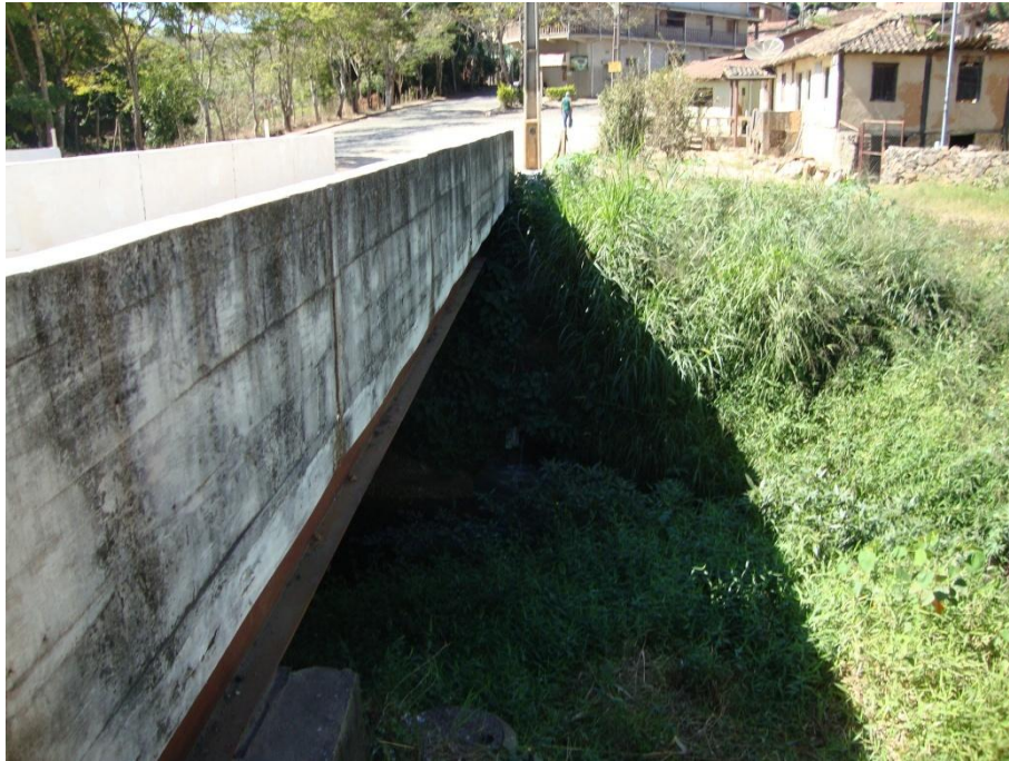
Ponte sobre o Ribeirão Jove
