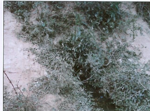
Figura 4.2 – Lançamento atrás do Campo de Futebol da Rua João Batista dos Santos
