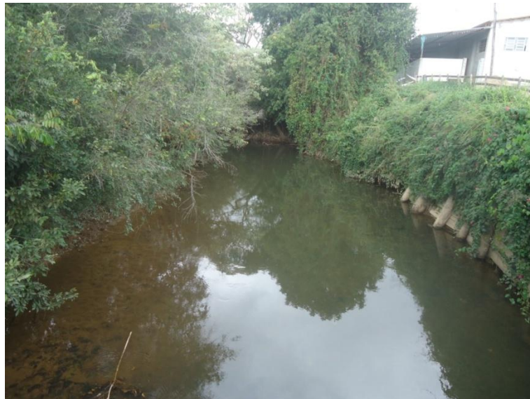
Ponto de inundação junto às margens do Rio Vermelho
