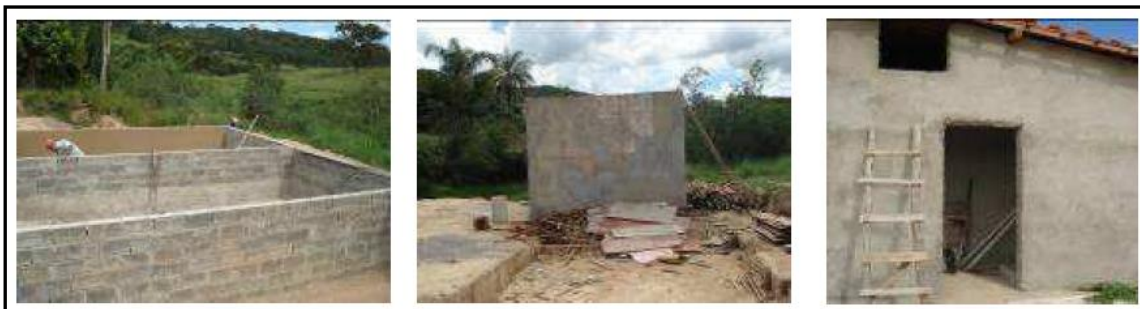
Figura 7.86 - Obras da ETE Nova Esperança
