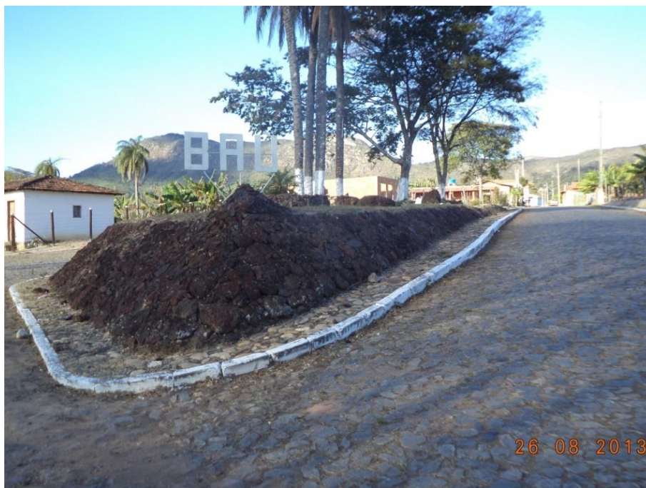
Figura 7.41 - Piso poliédrico em Baú
