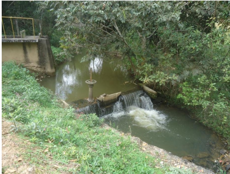
Figura 7.51 - Captação superficial no córrego dos Lopes
