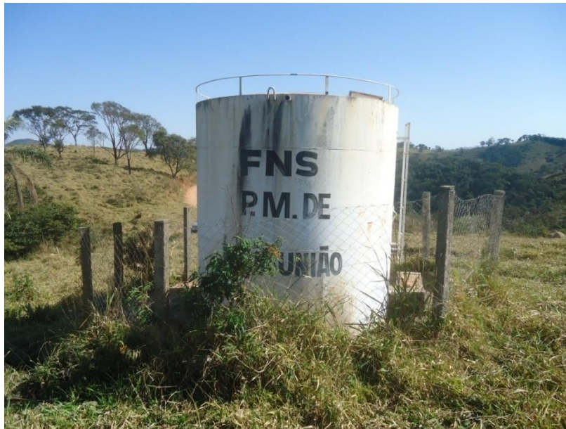
Figura 7.73 – Reservatório de Santo Antônio
