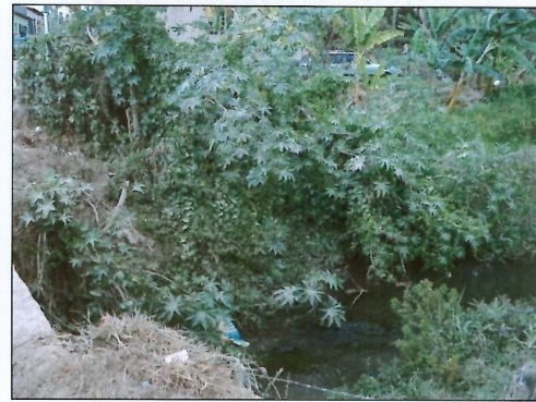
Figura 4.6 – Lançamento na Travessia da Rua José Valentim
