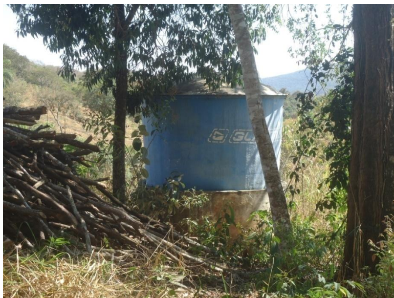
Figura 7.75 – Reservatório do Lopes
