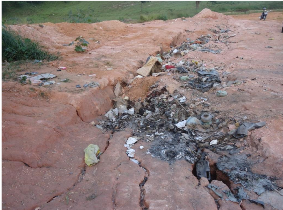
Figura 7.115 - Incorreto aterramento de vala
