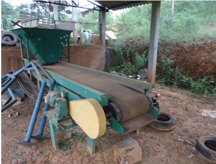
Figura 7.103 - Silo dosador e esteira de triagem
