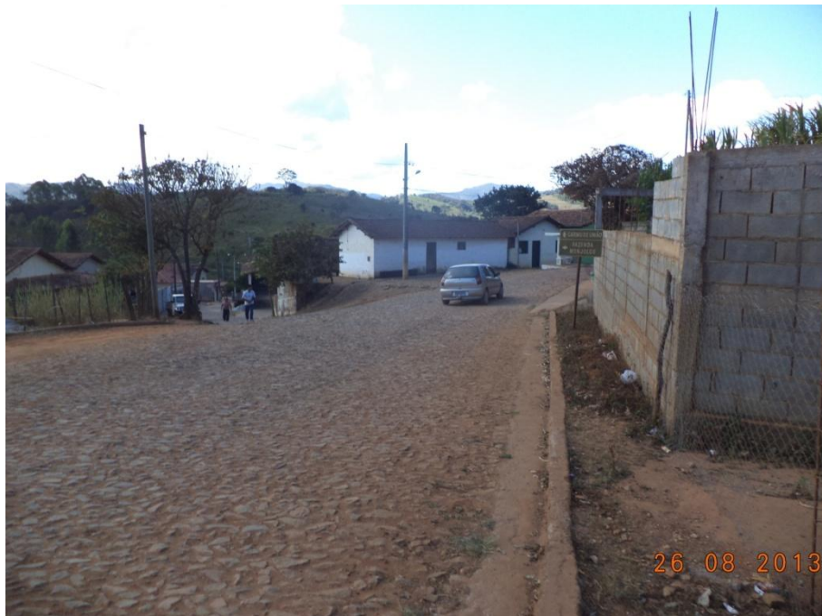
Figura 7.126 - Drenagem superficial em Carmo (sarjeta)
