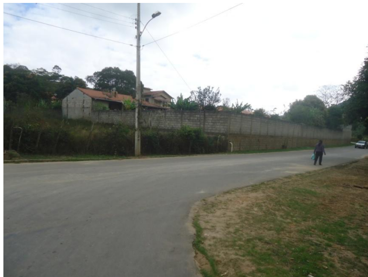
Via e edificação afetadas por problemas de inundação do Rio Vermelho
