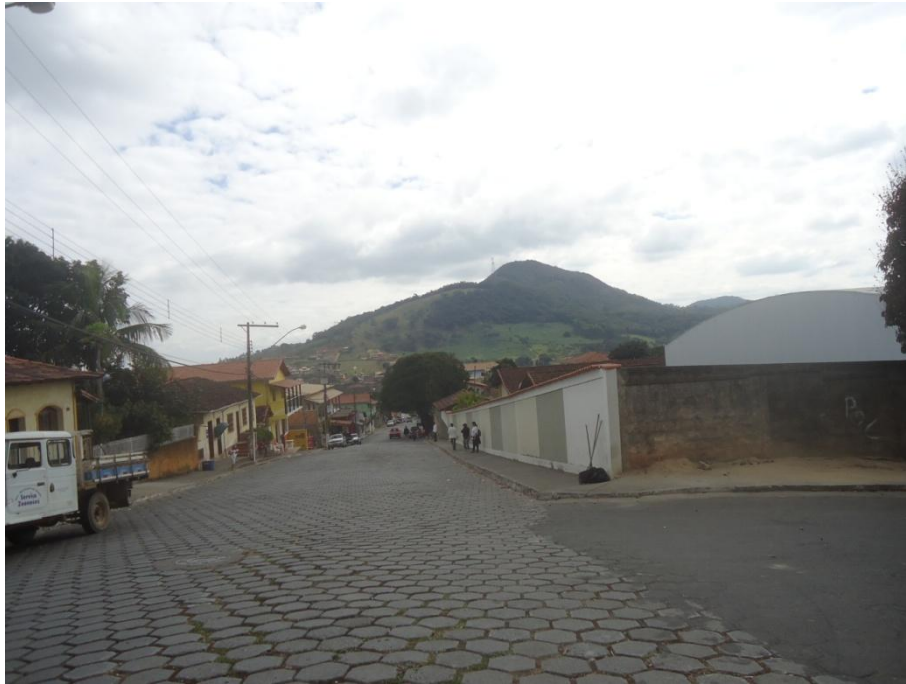
Figura 7.40 - Piso sextavado e asfáltico na sede urbana de Nova União
