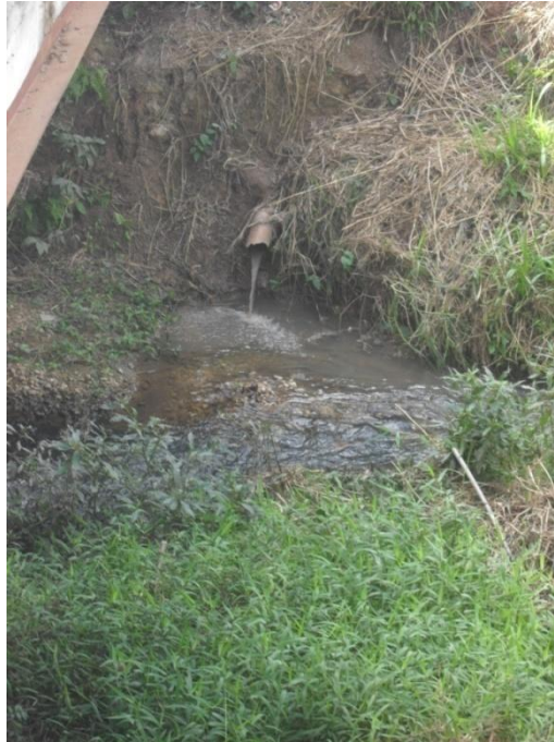
Figura 7.88 - Lançamento de esgoto in natura no córrego do Jove
