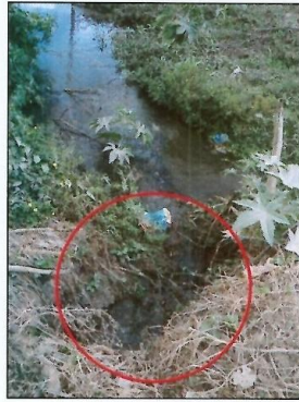
Figura 4.5 – Lançamento na Travessia da Rua José Valentim
