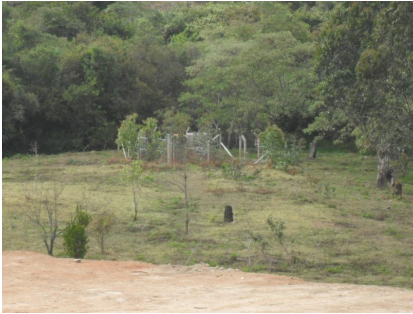
Figura 7.80 - Elevatória 2 para a ETE Nova Esperança
