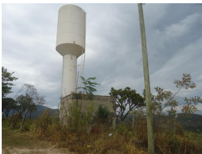
Figura 7-88 – Reservatório elevado Muniz
