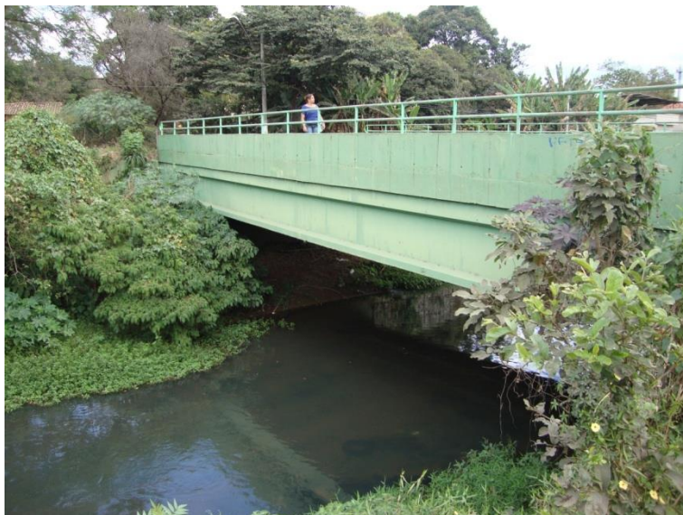
Ribeirão Sabará – Montante da Ponte da Av. Longitudinal Fonte: COBRAPE (2013).
