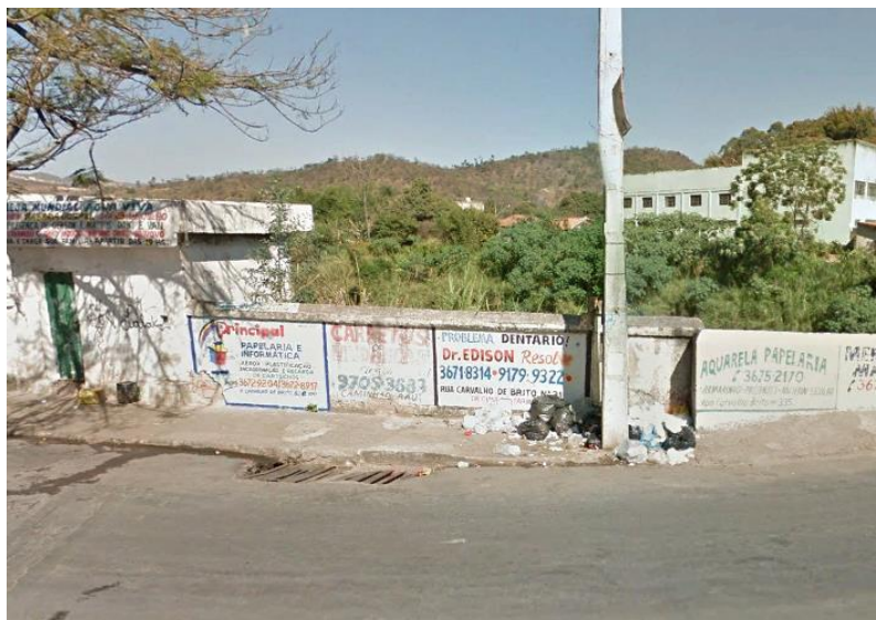
Figura 7-194 – Grelha de captação da galeria da Rua Carvalho Pinto
