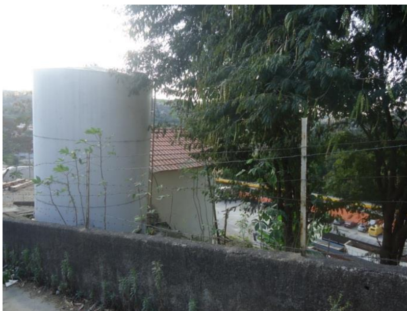
Figura 7-68 – Reservatório Jardim Borges: Regional Borges (COPASA)
