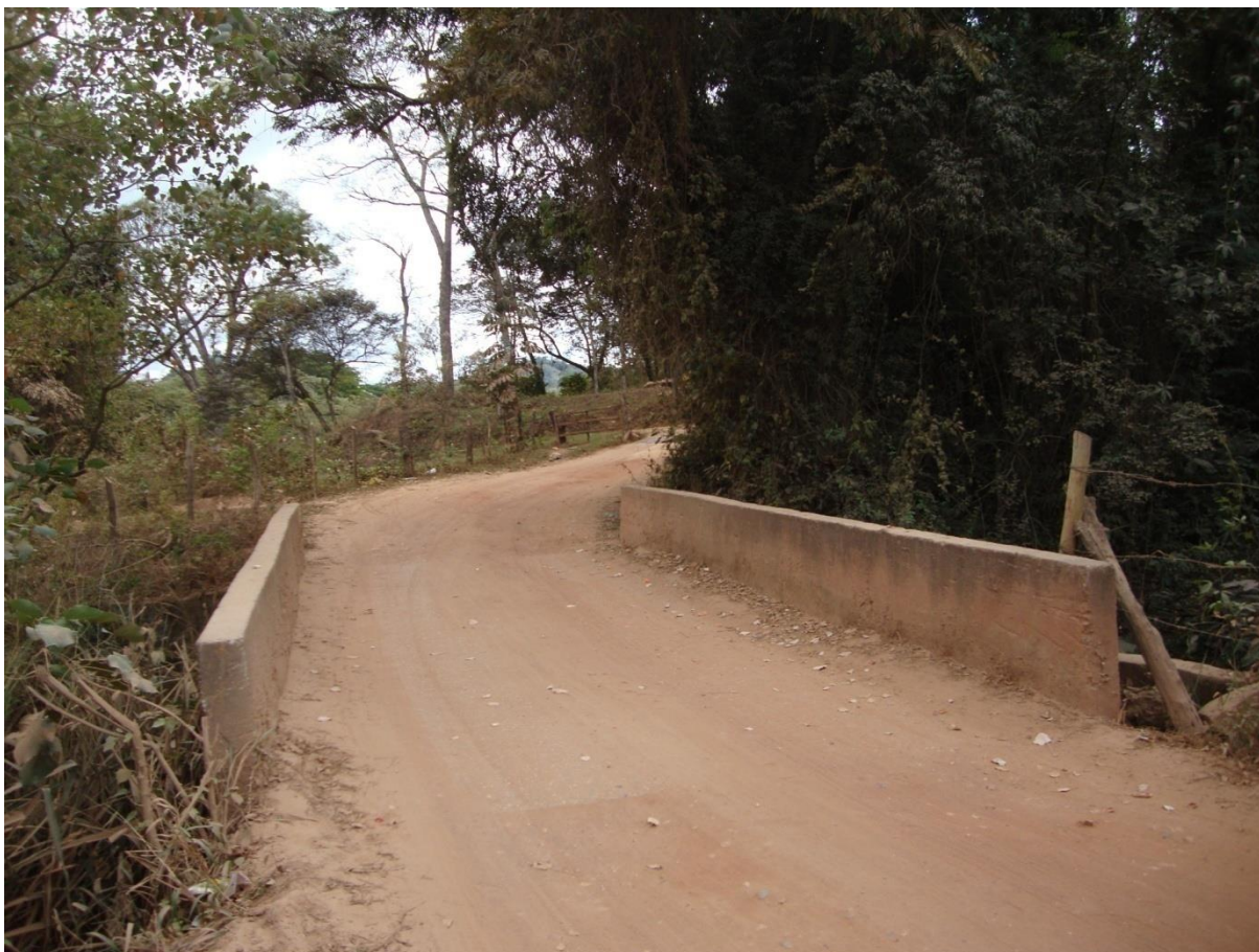
Rua Sem Nome – Ponte sob o Ribeirão Vermelho
