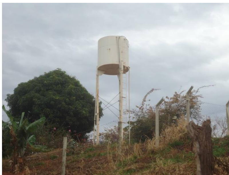
Figura 7-86 – Reservatório elevado Jambreiro
