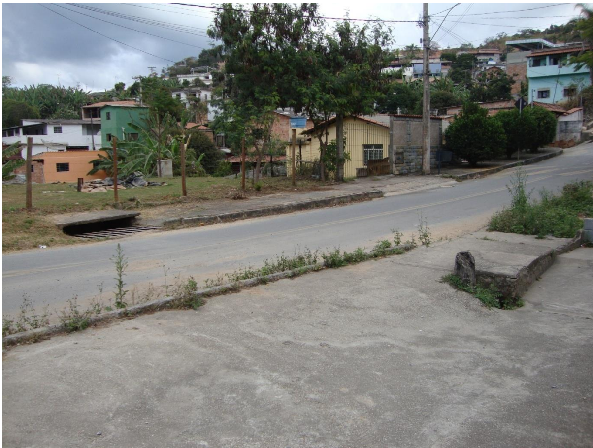
Rua Antônio Soares – Ponto onde há bueiro de travessia e inundação
