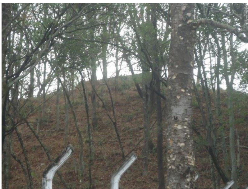
Figura 7-82 - Reservatório Apoiado COPASA: 120m 3
