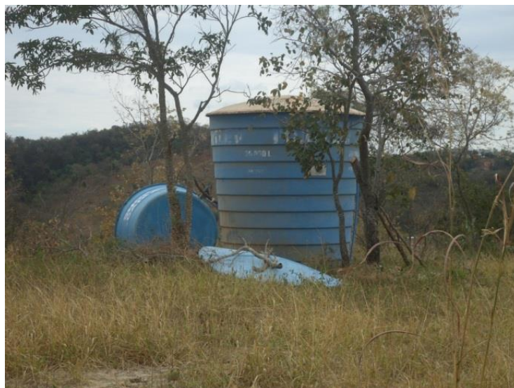
Figura 7-91 – Reservatório Várzea dos Crioulos
