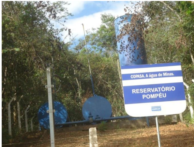
Figura 7-74 – Reservatório apoiado (COPASA): Pompéu
