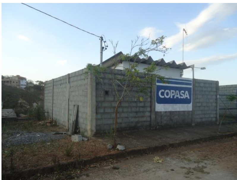
Figura 7-63 – Booster Vila Real (COPASA): Sede Municipal
