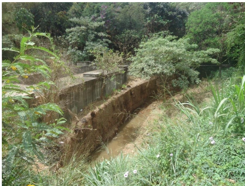
Figura 7-118 – Vista da ETE Tenda
