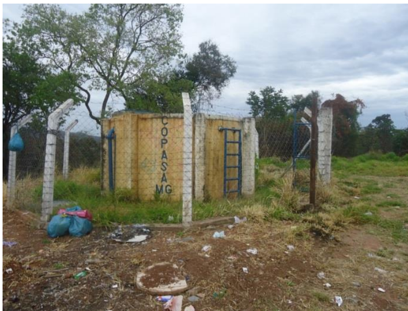
Figura 7-83 – Reservatório Apoiado COPASA: 16 m 3
