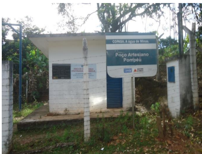
Figura 7-73 – Poço tubular profundo (COPASA): Pompéu
