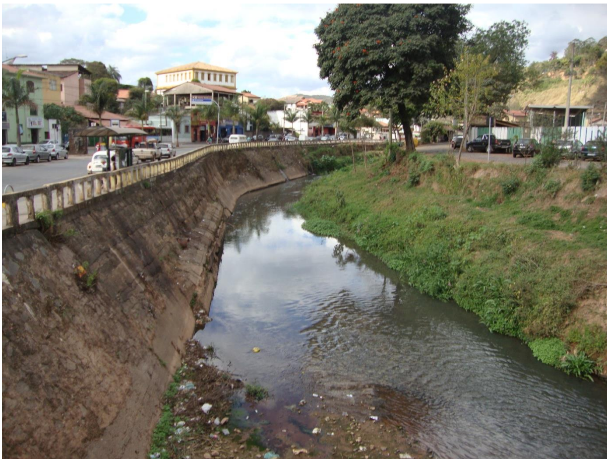
Figura 7-176 – Rio Sabará – Avenida Perimetral, Sob Ponte da Rua Mário Machado
