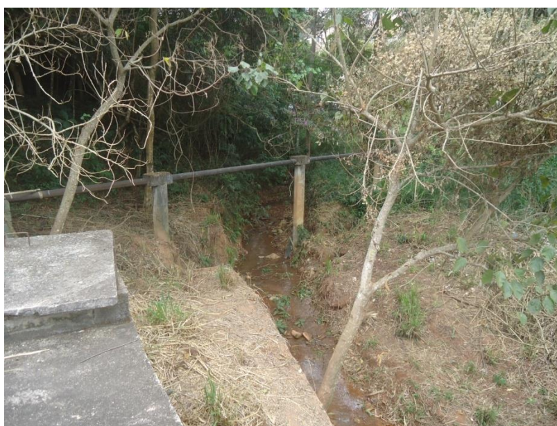
Figura 7-119 – Chegada dos esgotos à ETE Tenda
