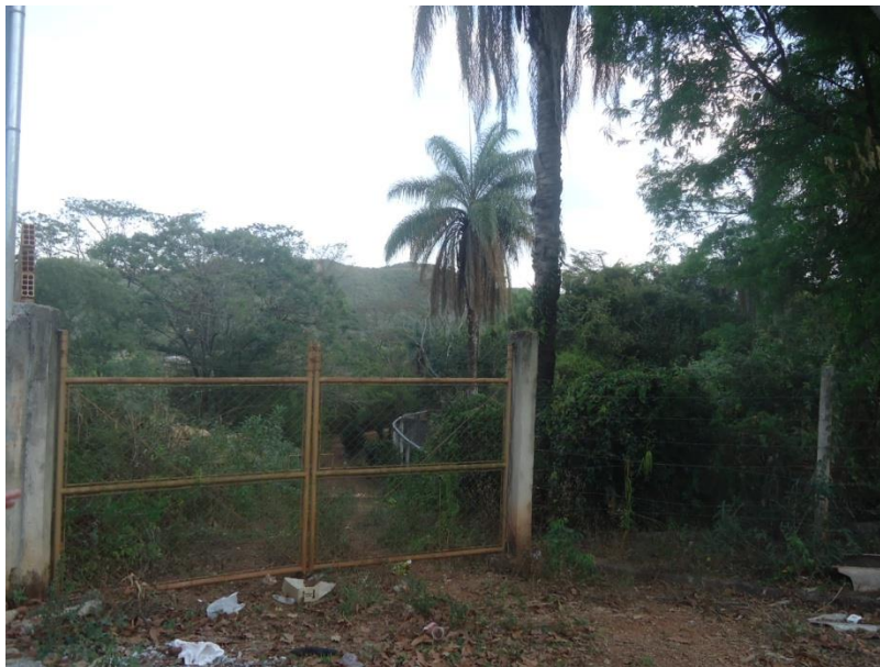
Figura 7-103 - Acesso a ETE Vila Real inoperante
