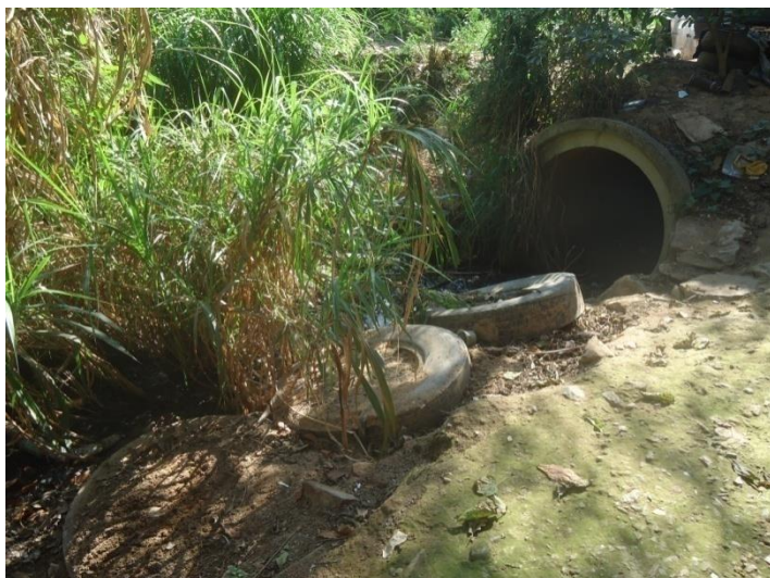
Figura 7-110 - Obstrução e contribuição de esgoto em galeria de água pluvial
