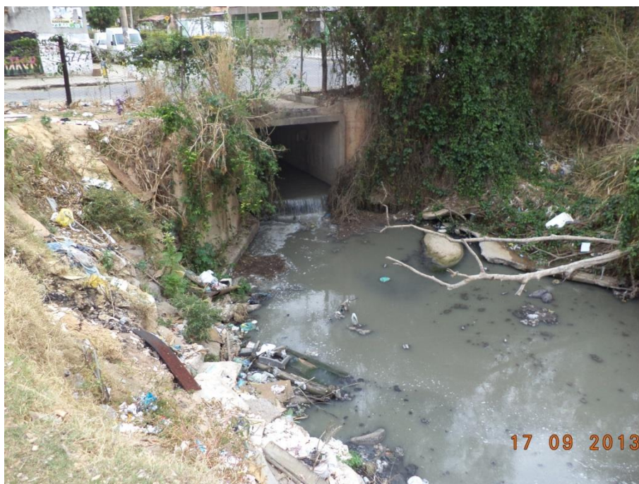
Figura 7-184 – Córrego Malheiro no desemboque da canalização da Avenida Cardoso de Menezes/Rua Guaraciaba
