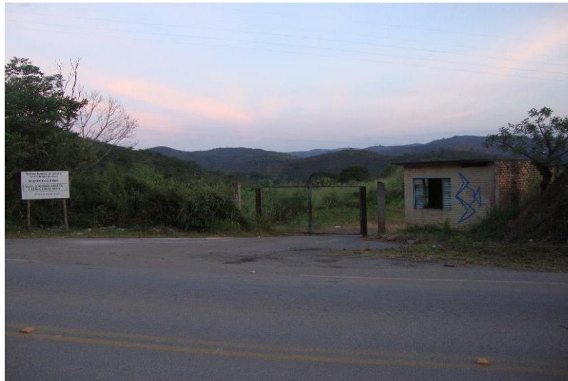
Figura 7-151 – Entrada do aterro controlado desativado
