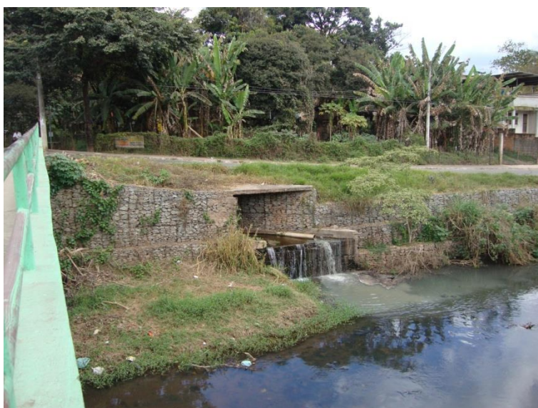
Ribeirão Sabará – Jusante da Ponte da Av. Longitudinal Fonte: COBRAPE (2013).
