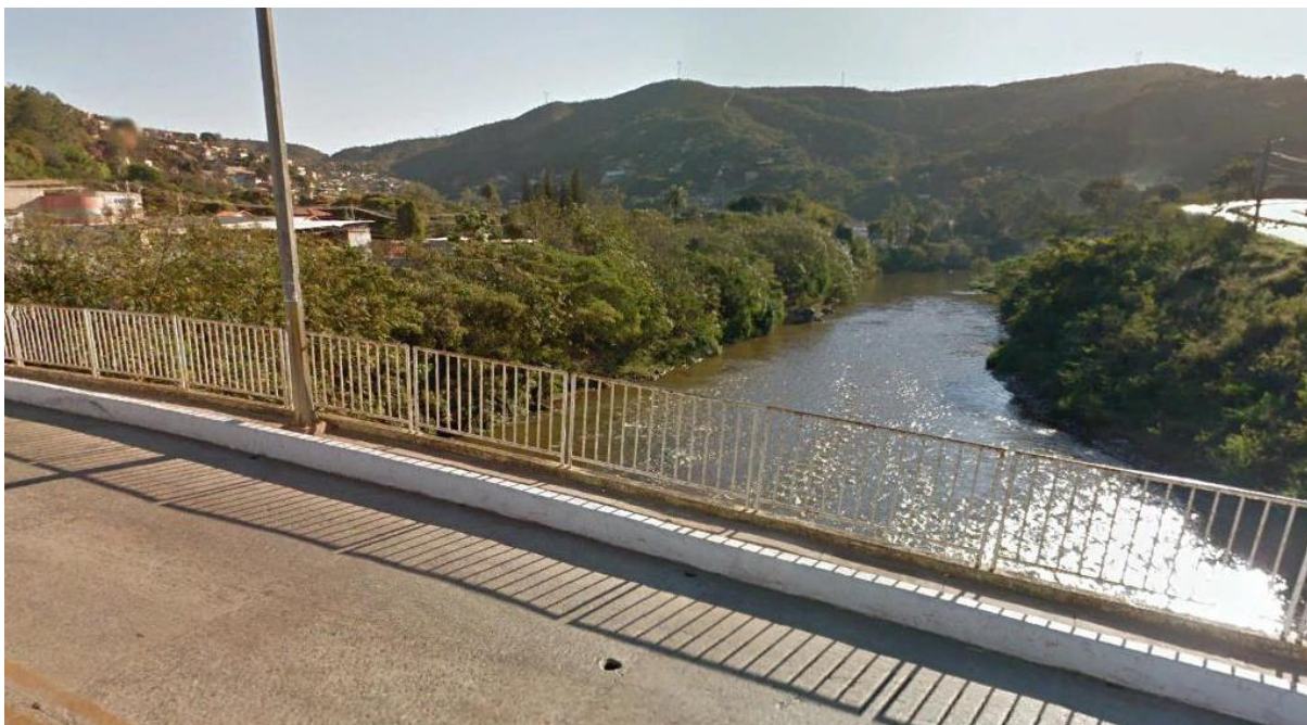
Figura 7-188 – Rio das Velhas sob Ponte da Av. Dr. Henrique de Melo
