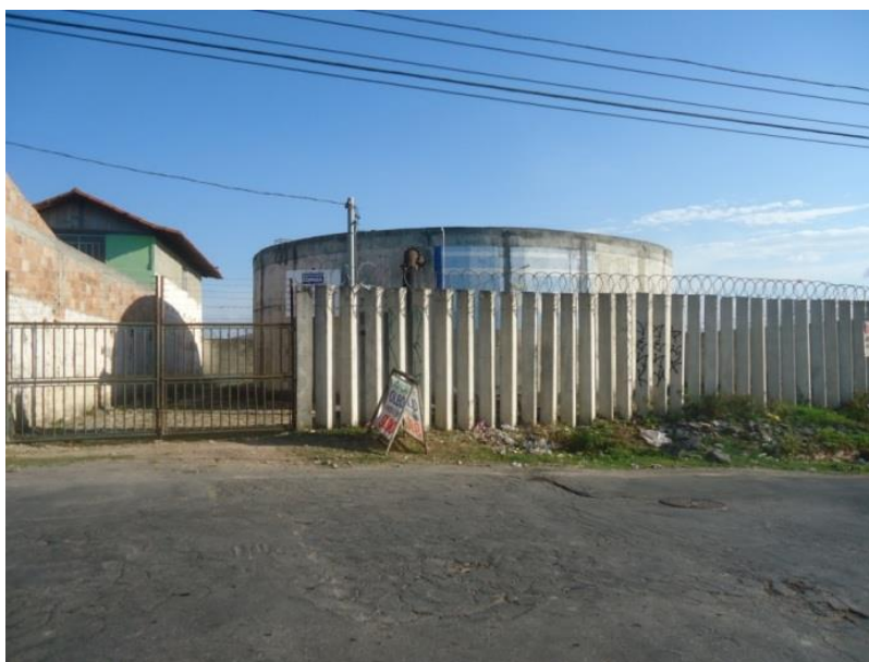
Figura 7-69 – Reservatório da regional Nossa Senhora de Fátima (COPASA)
