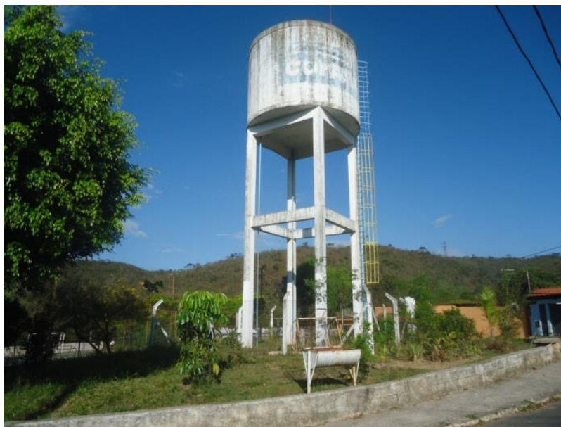
Figura 7-62 – Reservatório Esplanada (COPASA): Sede Municipal
