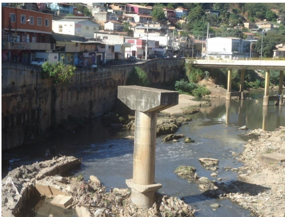
Figura 7-181 – Ribeirão Arrudas sob Ponte da Rua Guaxupé
