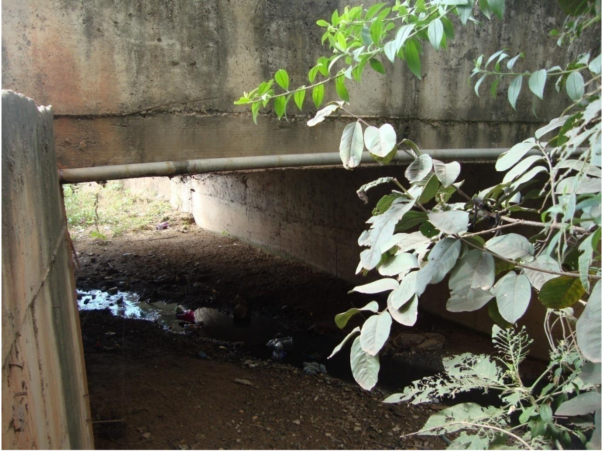
Seção do Córrego dos Lavapés sob Ponte – Rua Candido Lúcio Ferreira Pinto
