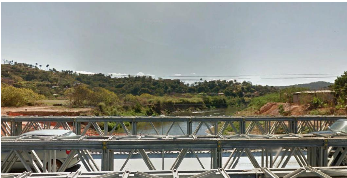
Figura 7-190 – Rio das Velhas sob Ponte da BR0-381
