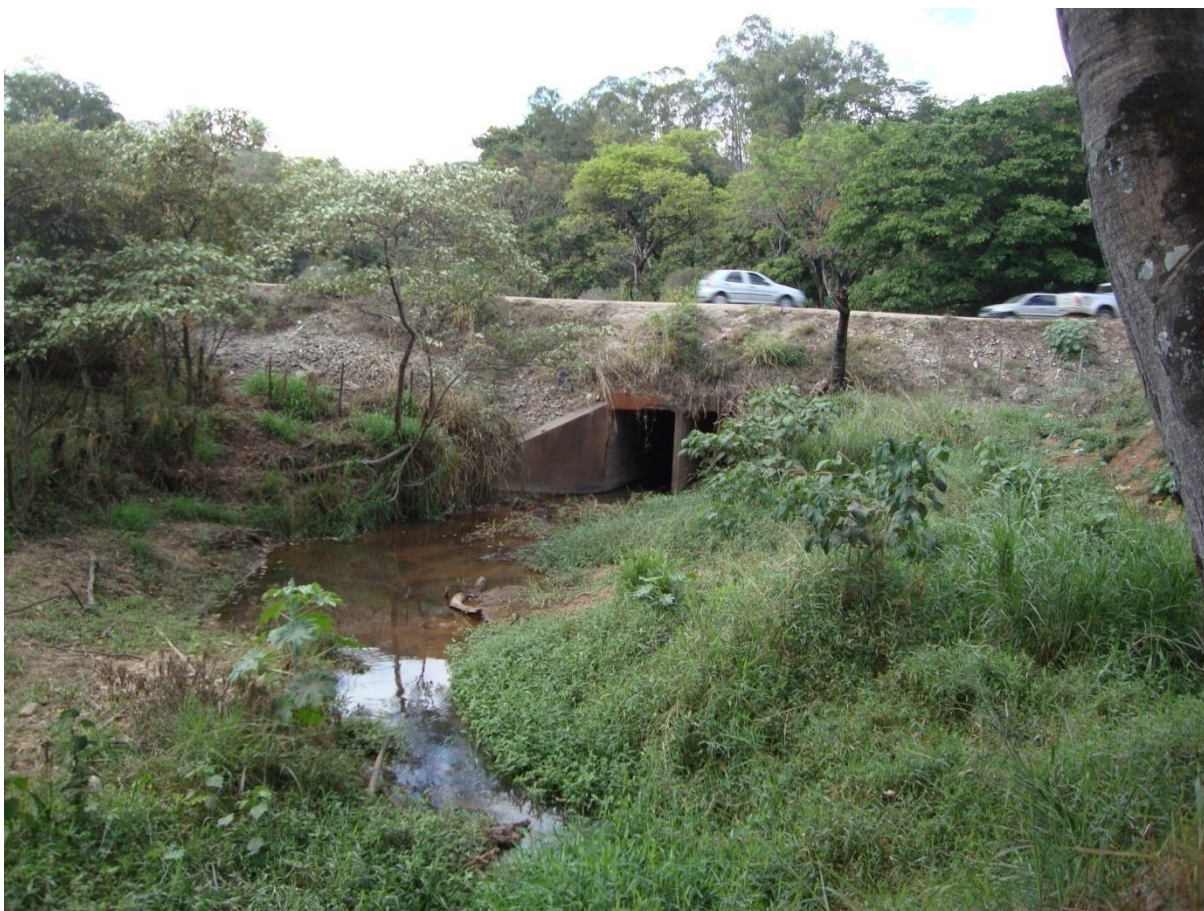
Ribeirão Vermelho – Travessia Sob Rodovia BR-381
