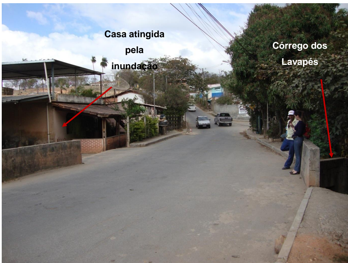
Ponte sobre o Córrego dos Lavapés – Rua Candido Lúcio Ferreira Pinto
