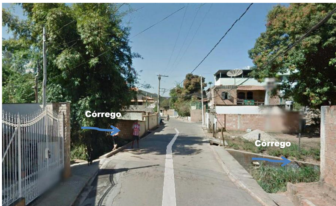
Figura 7-187 – Travessia de córrego sob Rua Santana
