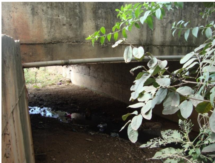
Figura 7-178 – Córrego dos Lava-Pés sob Ponte da Rua Candido Lúcio Ferreira Pinto
