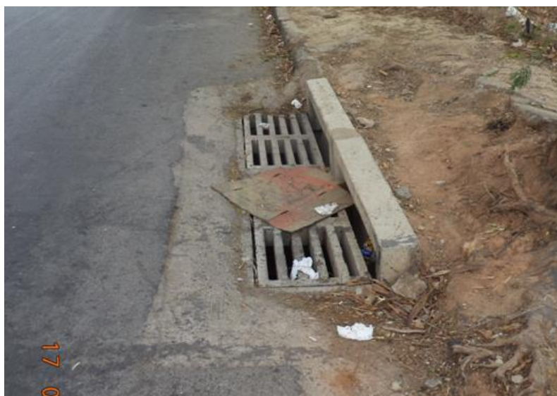
Figura 7-193 – Boca-de-lobo da galeria da Rua Mercúrio
