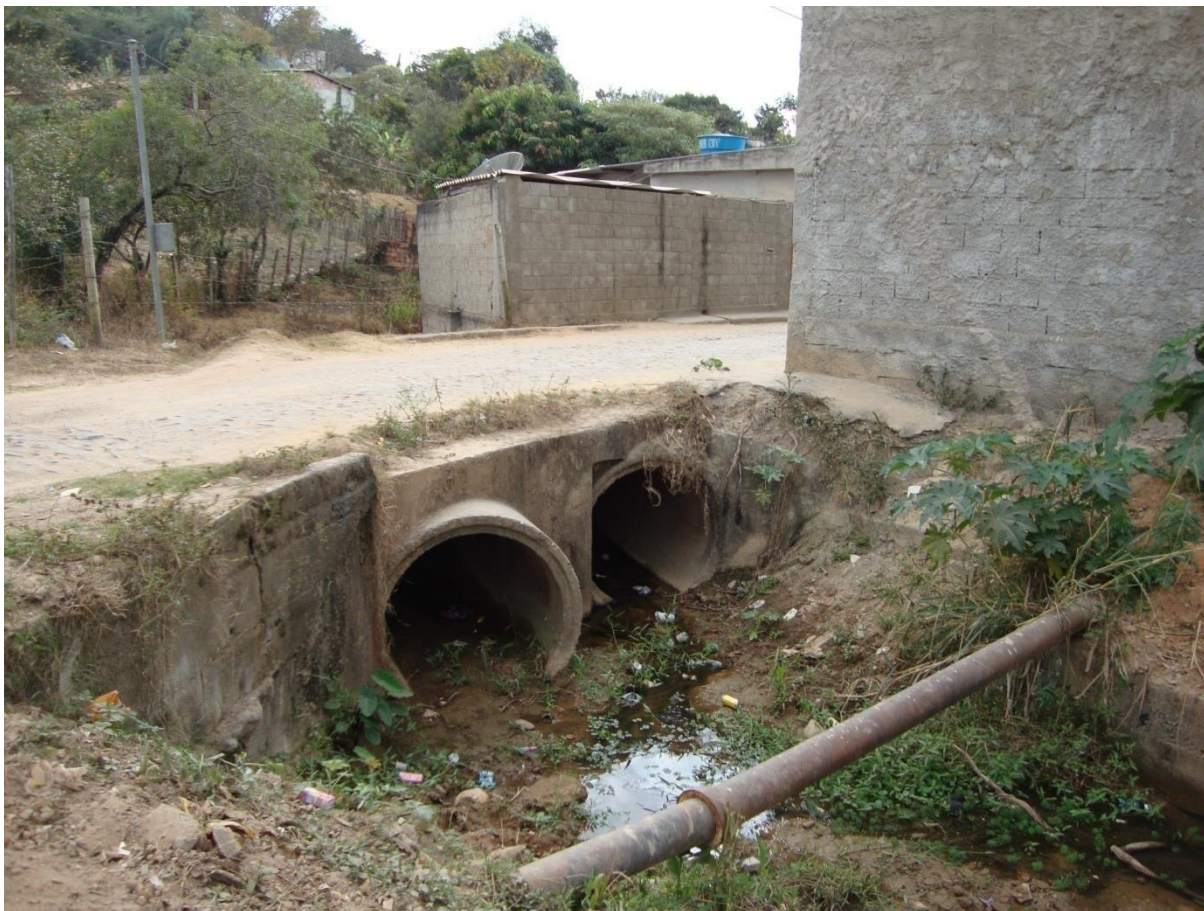
Córrego dos Lavapés – Bueiro de Travessia da Rua dos Lavapés
