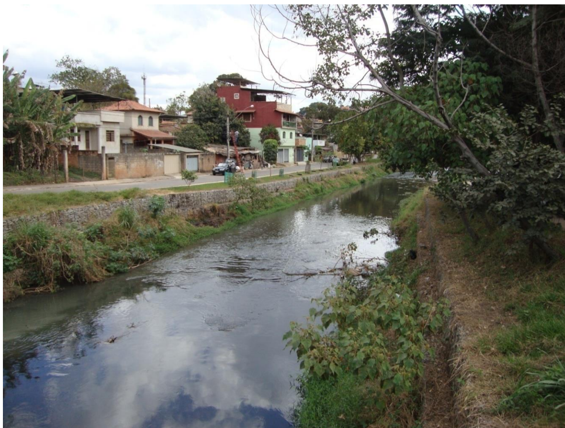
Figura 7-175 –Rio Sabará – Avenida Perimetral, Sob Ponte da Avenida Longitudinal
