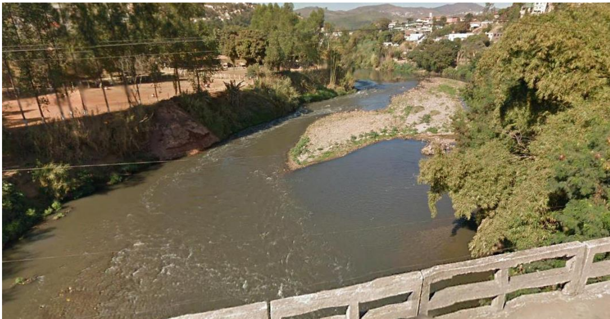
Figura 7-182 –Rio das Velhas sob Ponte da BR-262
