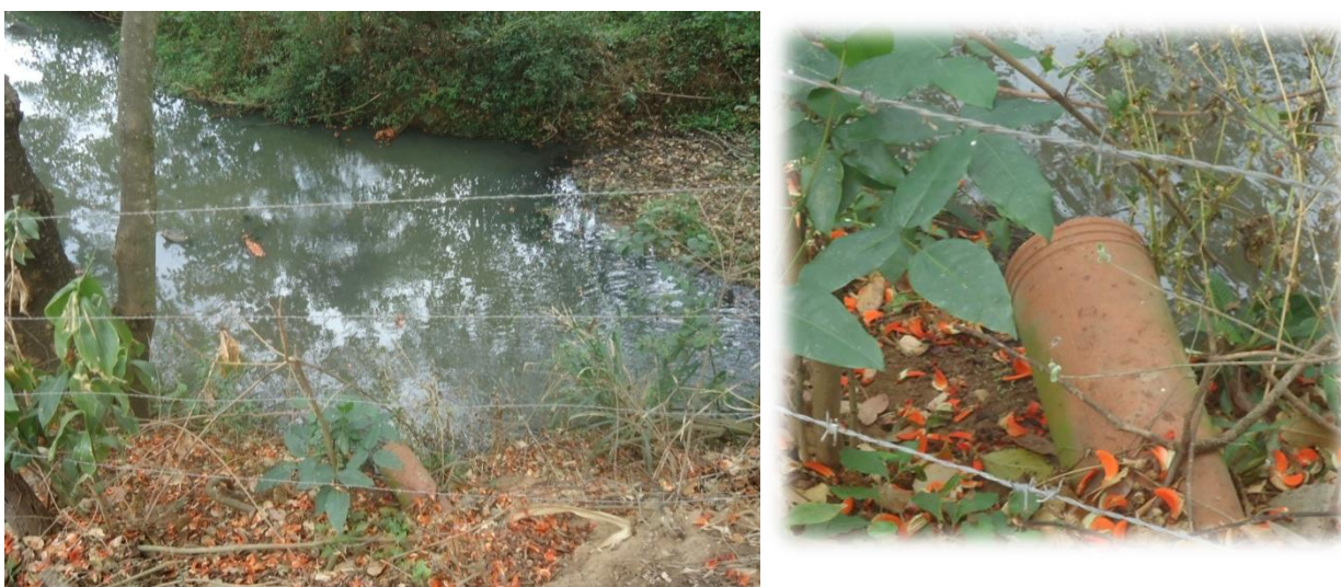
Figura 7-120 – Ponto 01 de lançamento de esgoto no ribeirão Vermelho
