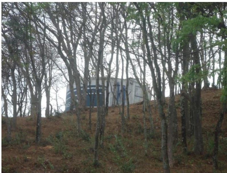
Figura 7-81 – Reservatório Apoiado COPASA: 150m 3
