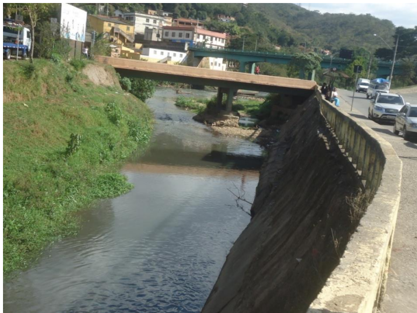
Figura 7-21 – Trecho canalizado do Ribeirão Sabará, no centro do município
