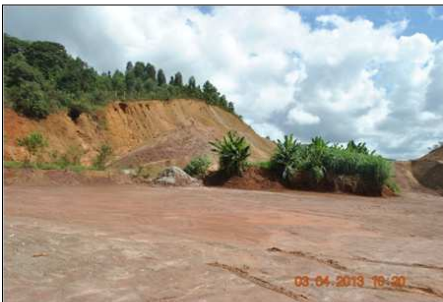
Figura 77. Área de Empréstimo Fonte: DRZ Geotecnologia e Consultoria (2013)
