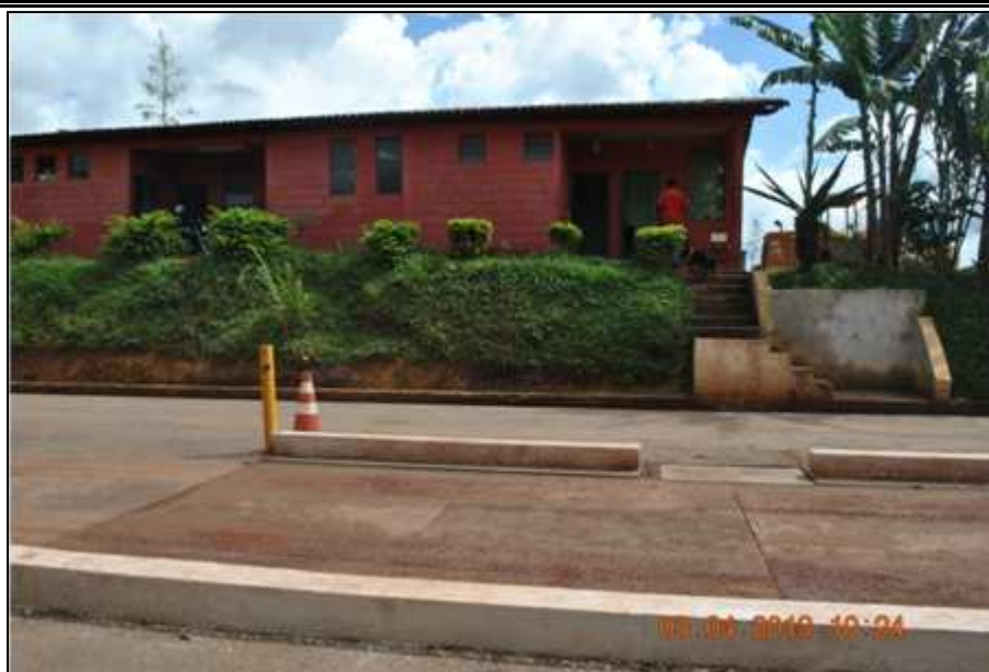
Figura 79. Balança para Controle do Peso dos Caminhões Fonte: DRZ Geotecnologia e Consultoria (2013)
