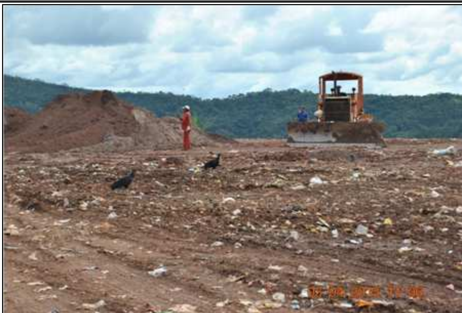
Figura 76. Compactação de Resíduos com Trator de Esteiras Fonte: DRZ Geotecnologia e Consultoria (2013)
