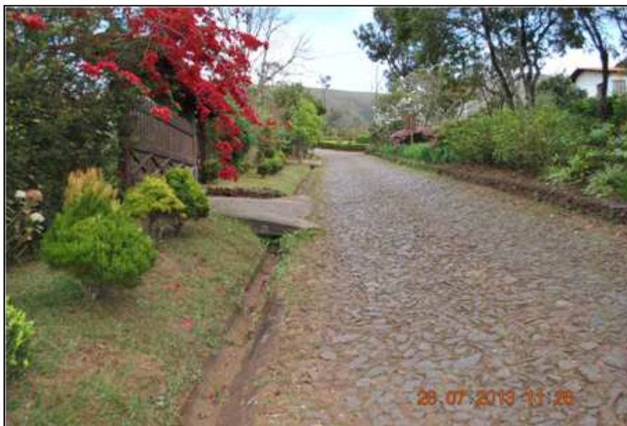
Figura 179. Dispositivos de Drenagem Superficial do Condomínio Aconche-go da Serra
