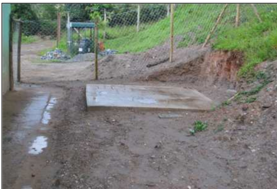
Figura 160. Fossa Séptica do Posto de Saúde do Povoado de Ribeirão do Eixo
