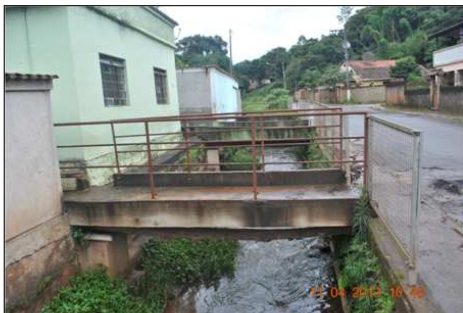
Figura 128. Ocupação Inadequada em Área de Inundação (Margem do Córrego Carioca) Fonte: DRZ Geotecnologia e Consultoria (2013)
