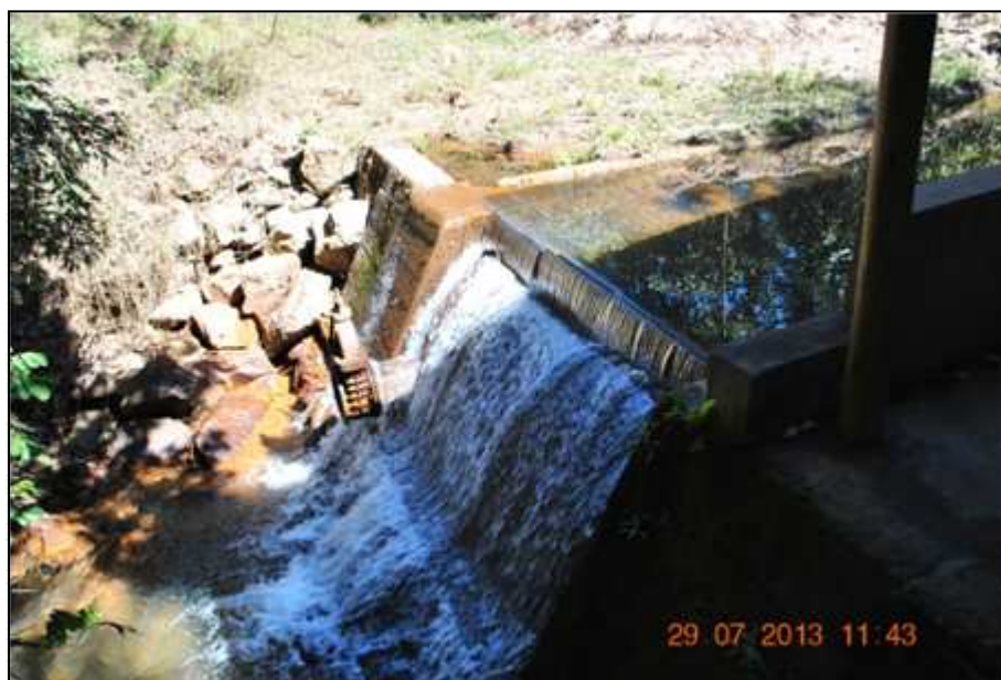
Figura 12. Barragem de Captação do Córrego Seco Fonte: DRZ Geotecnologia e Consultoria (2013)
