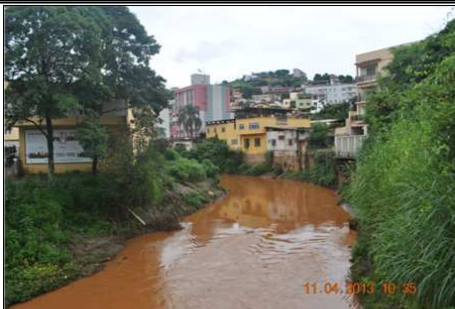
Figura 113. Ocupação Irregular em Área de Inundação
