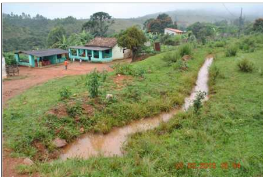
Figura 168. Vala para Abastecimento de Água na Localidade Saboeiro/Macedo Fonte: DRZ Geotecnologia e Consultoria (2013)
