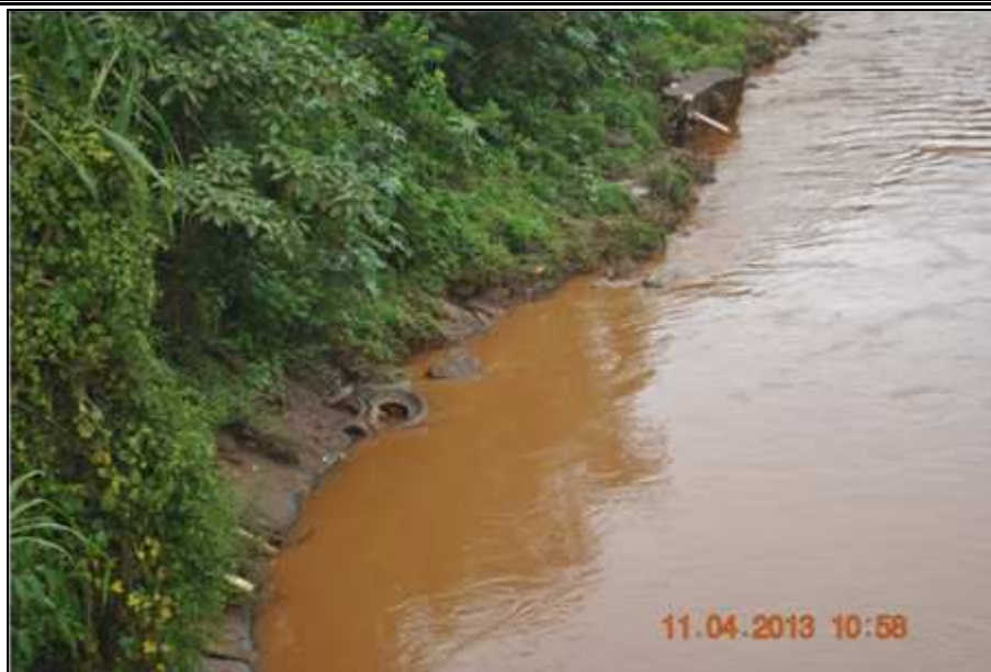
Figura 123. Resíduos Depositados nas Margens do Rio Itabirito Fonte: DRZ Geotecnologia e Consultoria (2013)
