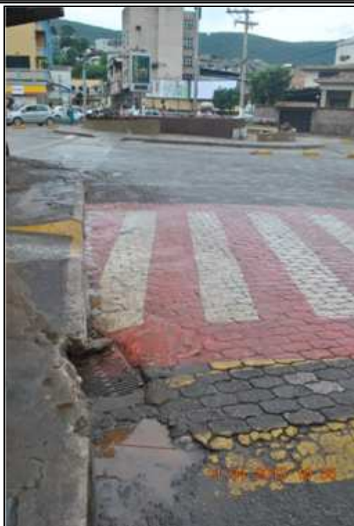
Figura 118. Microdrenagem na Área Central, Próximo ao Rio Itabirito Fonte: DRZ Geotecnologia e Consultoria (2013)
