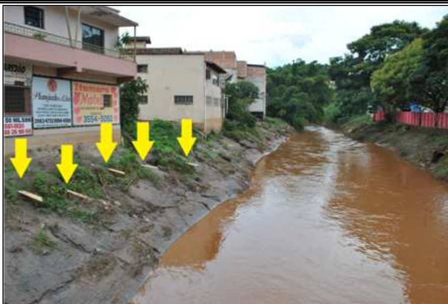
Figura 29. Lançamento Irregular de Esgoto no Rio Itabirito (Destaque para as Canalizações)
