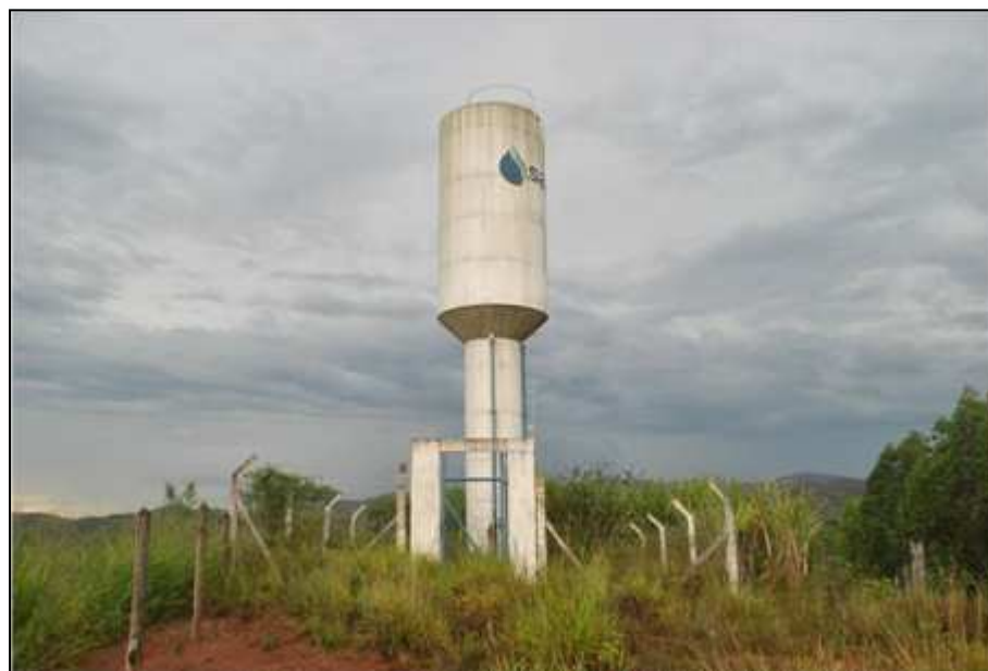
Figura 162. Reservatório Elevado na Localidade Ribeirão do Eixo Fonte: DRZ Geotecnologia e Consultoria (2013)
