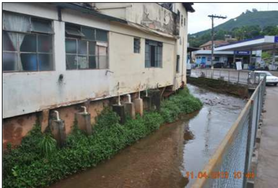
Figura 112. Canalização do Córrego Carioca
