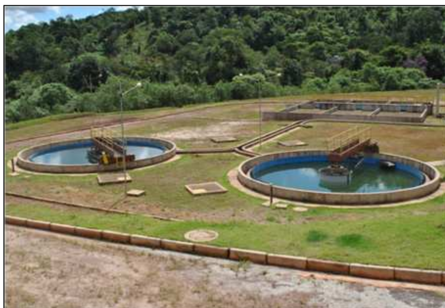
Figura 43. Decantadores da ETE (visão de cima) Fonte: DRZ Geotecnologia e Consultoria (2013)
