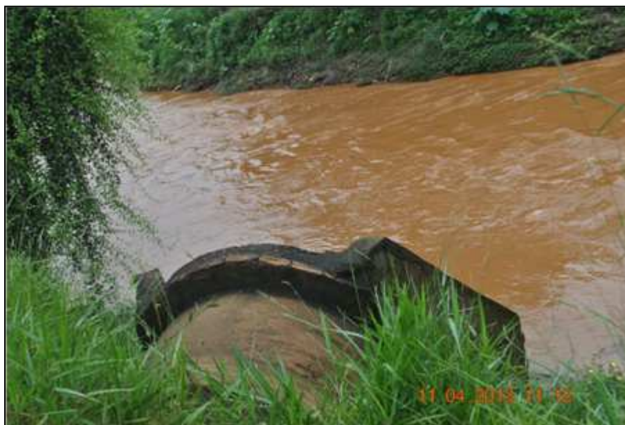
Figura 111. Lançamento Final Drenagem
