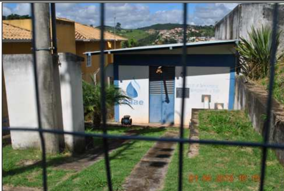
Figura 24. Estação Elevatória e Reservatório de Paraopeba Fonte: DRZ Geotecnologia e Consultoria (2013)
