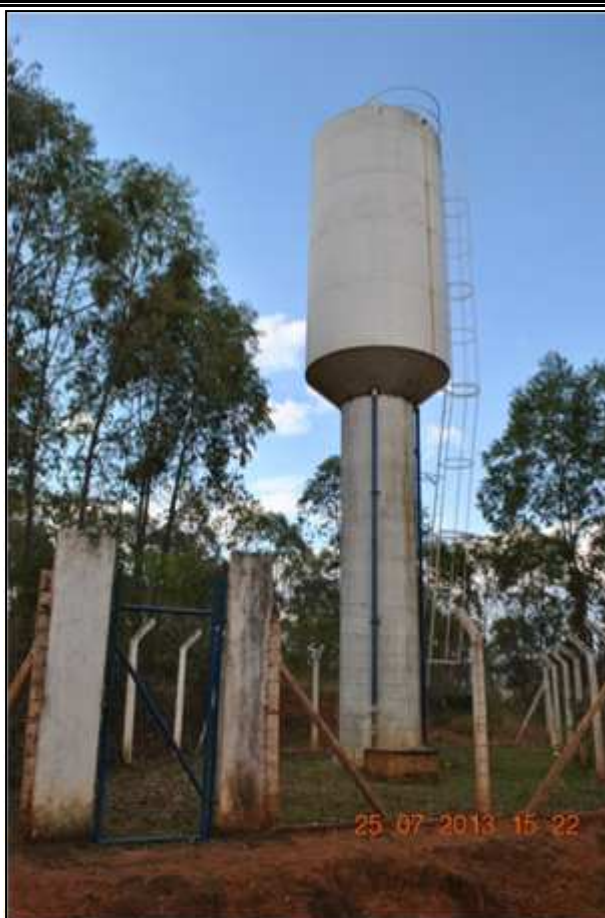
Figura 151. Reservatório do SAAE do Distrito de São Gonçalo do Monte Fonte: DRZ Geotecnologia e Consultoria (2013)
