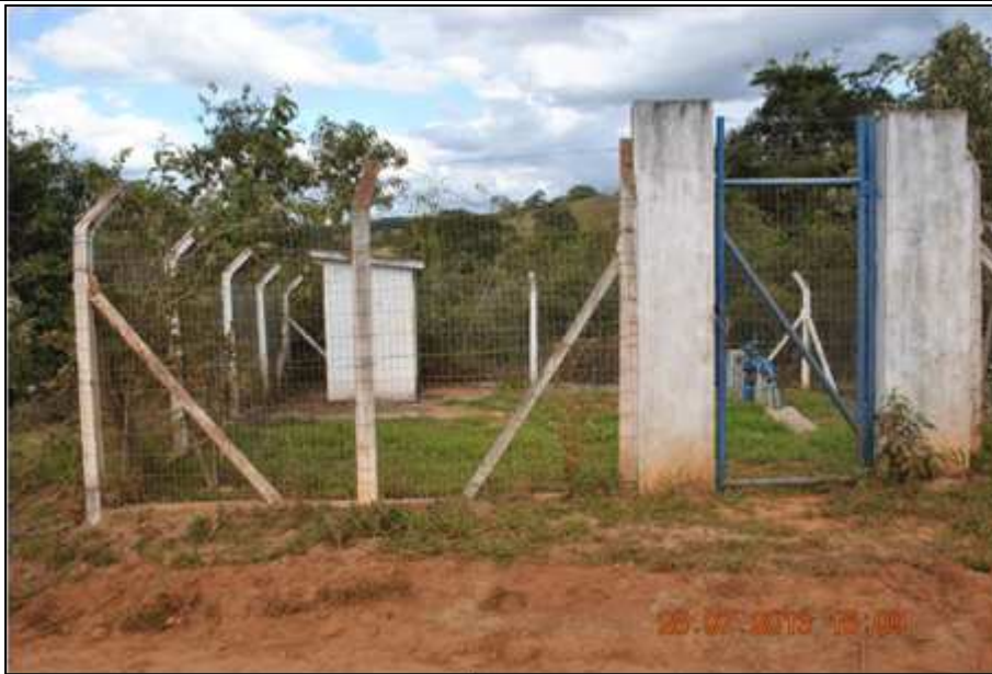
Figura 149. Poço de Abastecimento de Água do SAAE do Distrito de São Gonçalo do Monte
