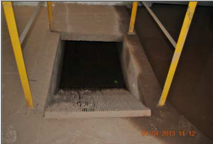
Figura 32. Gradeamento na Entrada da EEE Fonte: DRZ Geotecnologia e Consultoria (2013)
