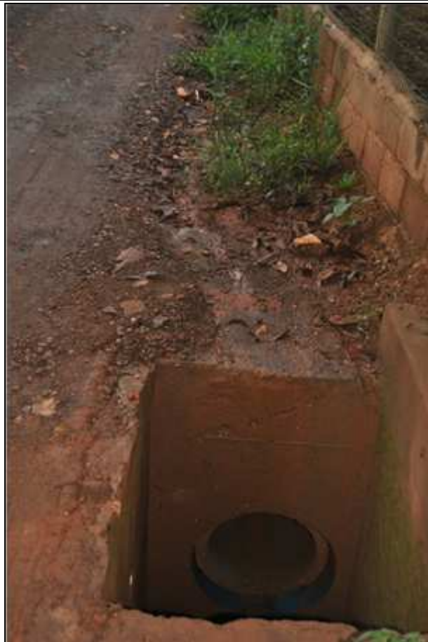
Figura 161. Microdrenagem na Localidade Ribeirão do Eixo Fonte: DRZ Geotecnologia e Consultoria (2013)
