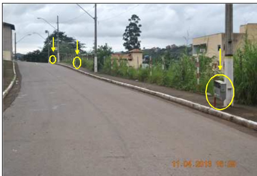
Figura 99. Lixeiras Públicas Distribuídas na Calçada
