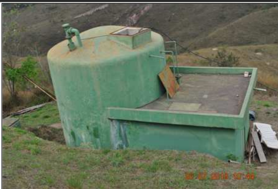
Figura 172. Reservatório de Água do Condomínio Villa Bella Fonte: DRZ Geotecnologia e Consultoria (2013)
