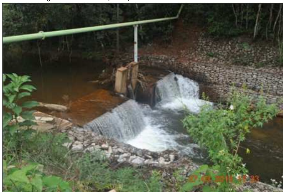
Figura 130. Captação no Córrego Tijuco Fonte: DRZ Geotecnologia e Consultoria (2013)
