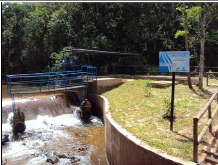
Figura 13. Captação na Barragem do Córrego Bação Fonte: DRZ Geotecnologia e Consultoria (2013)
