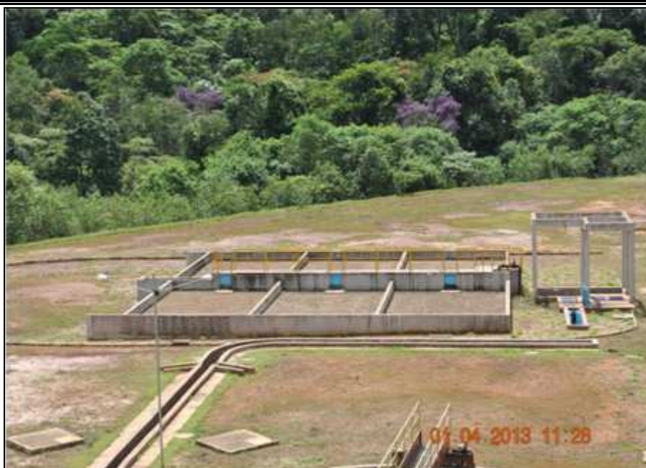
Figura 46. Leitos de Secagem de Lodo da ETE (Vista de Cima) Fonte: DRZ Geotecnologia e Consultoria (2013)
