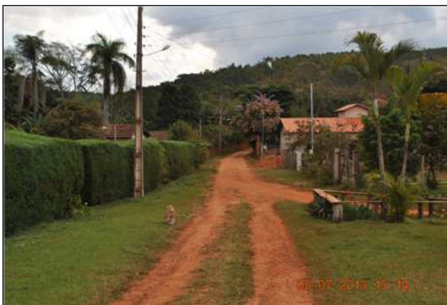
Figura 153. Carência de Dispositivos de Drenagem no Distrito de São Gonçalo do Monte
