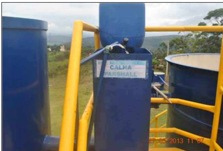
Figura 131. Calha Parshall Fonte: DRZ Geotecnologia e Consultoria (2013)
