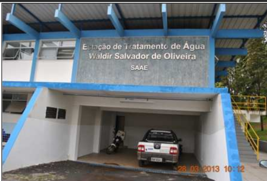
Figura 10. Foto da Fachada da Estação de Tratamento de Água – ETA Itabirito Fonte: DRZ Geotecnologia e Consultoria (2013)
