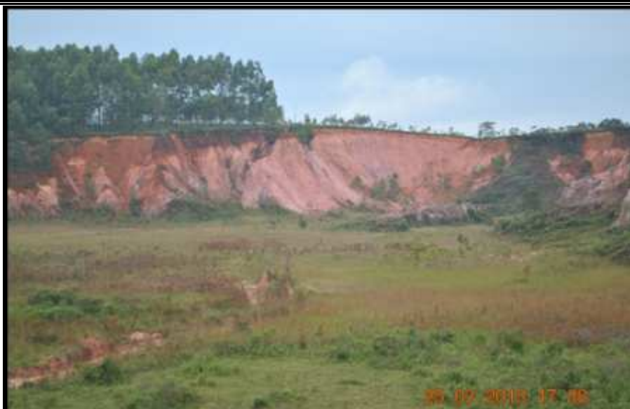
Figura 105. Voçoroca no Município de Itabirito
