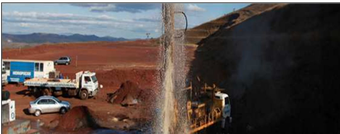
Figura 5. Poço Profundo Perfurado nas Proximidades da Empresa Coca-Cola Femsa em Itabirito
