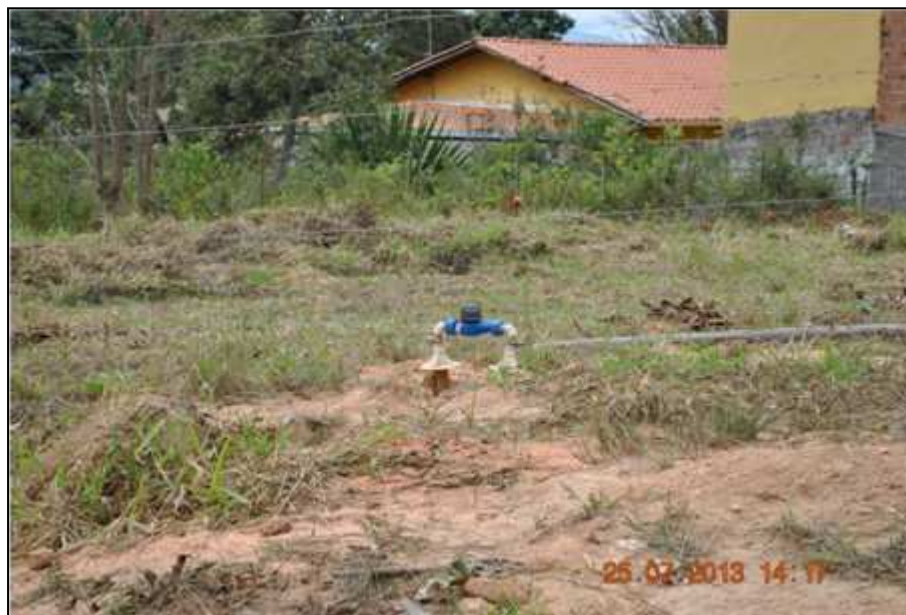
Figura 141. Hidrômetro no Distrito de São Gonçalo do Bação
