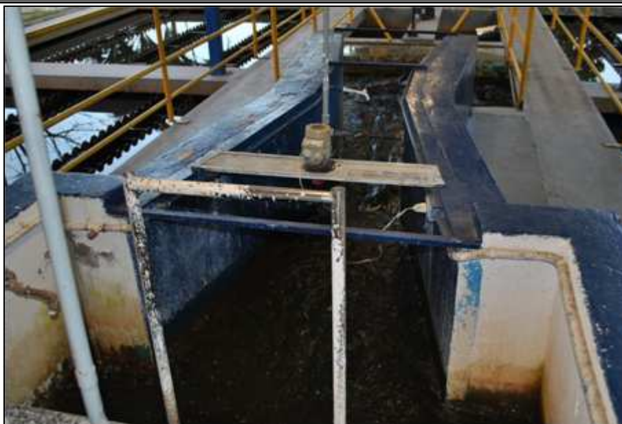
Figura 16. Calha Parshall
