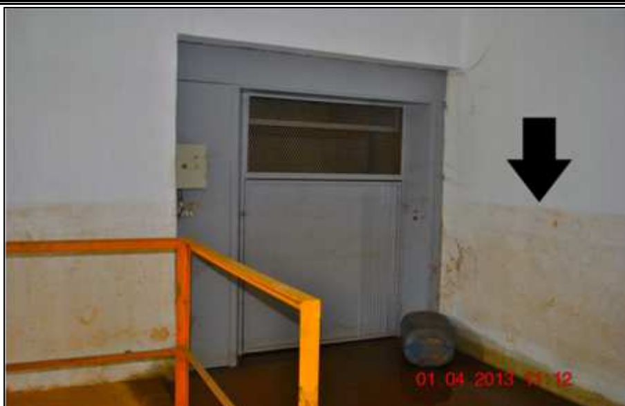
Figura 36. Entrada do Elevador da ETE (Em Destaque Marca da Última Enchente) Fonte: DRZ Geotecnologia e Consultoria (2013)
