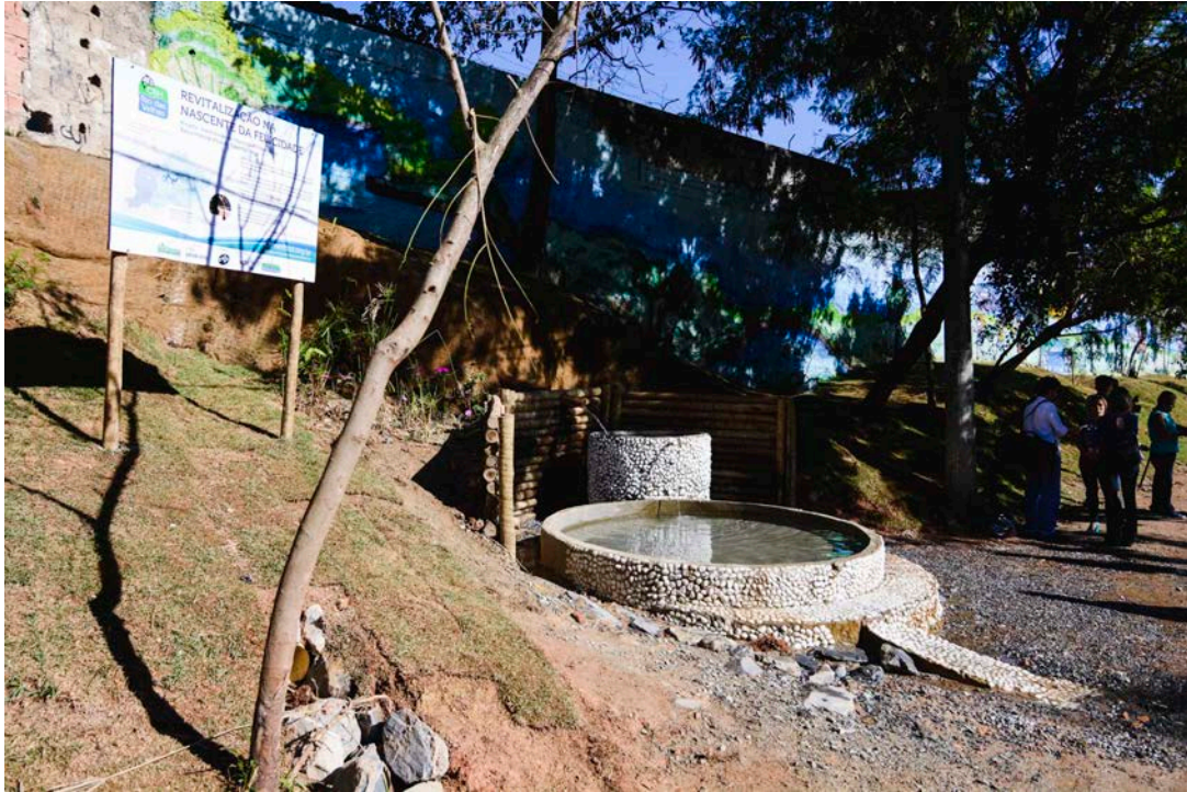
Figura 24 – Vista da Nascente principal ON 127 com limpeza, poço revitalizado, plantio de grama, escoamento de água e grafitti ao fundo - Fonte: Gos 2017
