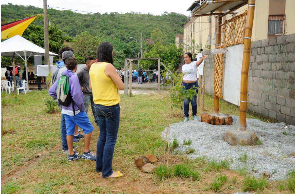
Figura 66 – Pórtico de Bambu produzido e instalado pelos participantes da oficina na área da Nascente Fundamental / Fonte: Gos Florestal – 2016
