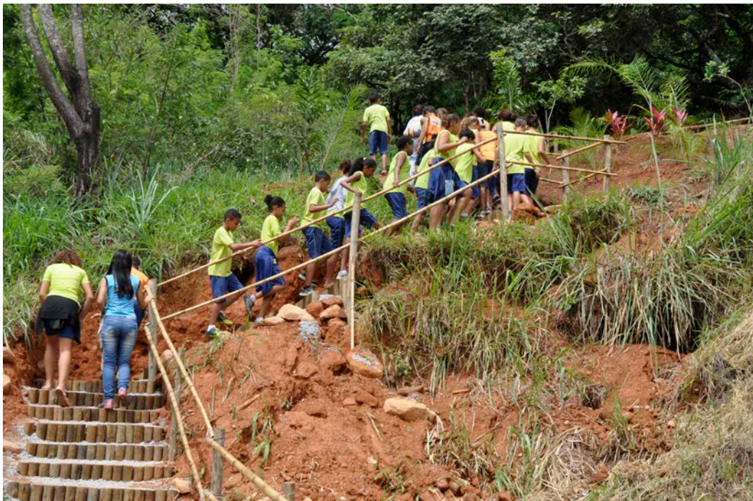
Figura 7 – Vista da escada e corrimão construídos para melhorar o acesso à nascente durante visita de alunos da escola Municipal Bolivar Tinoco / Fonte: Gos
