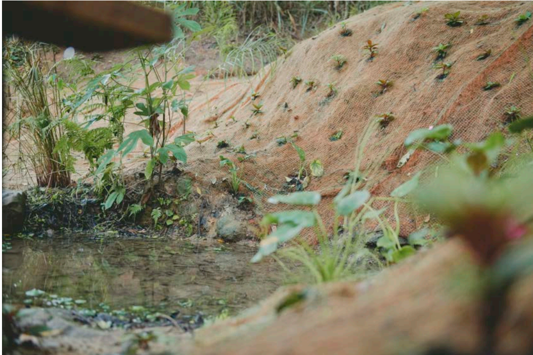
Figura 6 – Vista da Nascente recuperada com manta vegetal e plantio de mudas.
