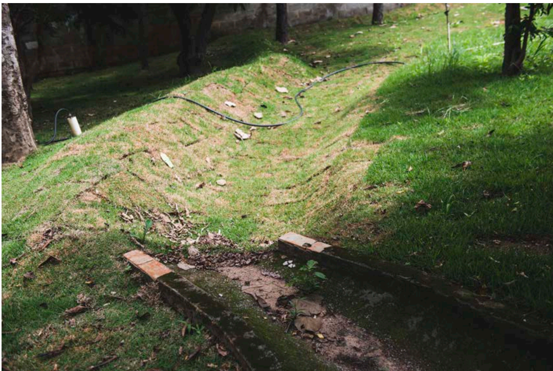
Figura 10 – Vista da Nascente ON 116 com plantio de gramado e construção de swale para contenção de erosão – Fonte: GOS Florestal 2016
