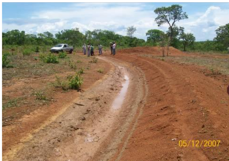
Figura 14: Exemplo de terraço executado
