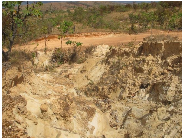
Foto 17: Detalhe de um dos pontos indicados para execução de paliçada. (Coord. UTM 596590 / 8024875)
