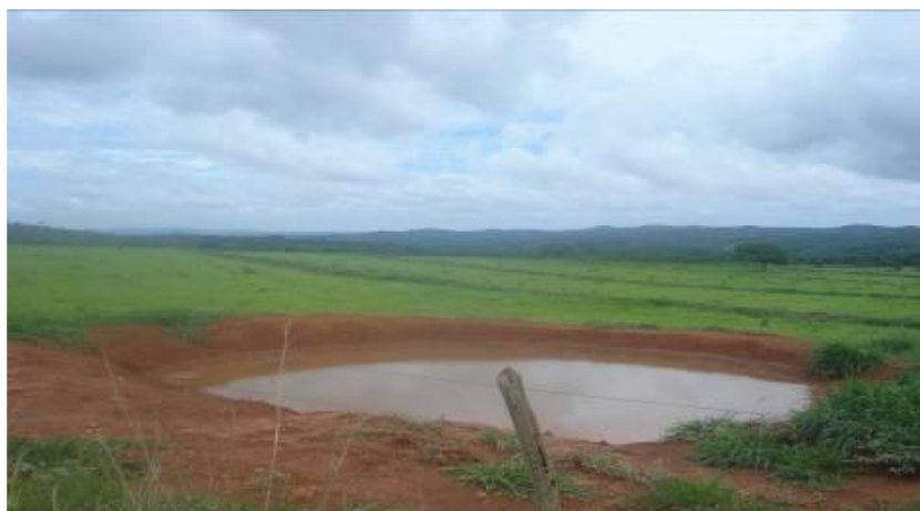
Figura 13: Exemplo de barraginha
