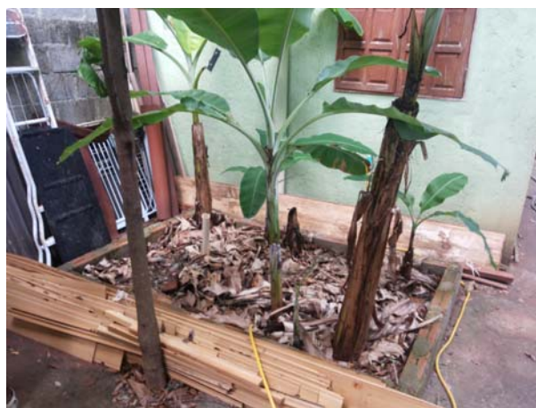
Figura 3.7 – TEvap em funcionamento com plantio de bananeiras e tubo de inspeção Local: Refúgio São Francisco, Serra do Cipó, Santana do Riacho, MG.
