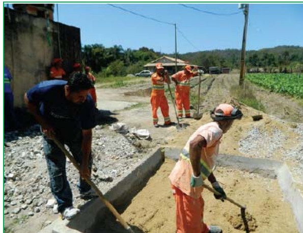
Figura 3.4 – Enchimento da trincheira com camada de areia. Fonte: Leal, 2014.
