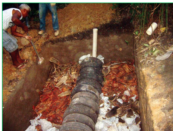
Figura 3.3 – TEvap – Tubo de entrada na câmara e enchimento da trincheira com entulho. Fonte: Leal, 2014.
