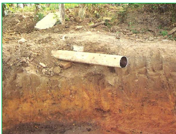
Figura 3.14 – Vala escavada e tubo de lançamento das águas cinzas. Fonte: Leal, 2016.
