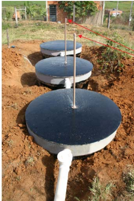
Figura 3.12 – Fossa Séptica Biodigestora instalada.
