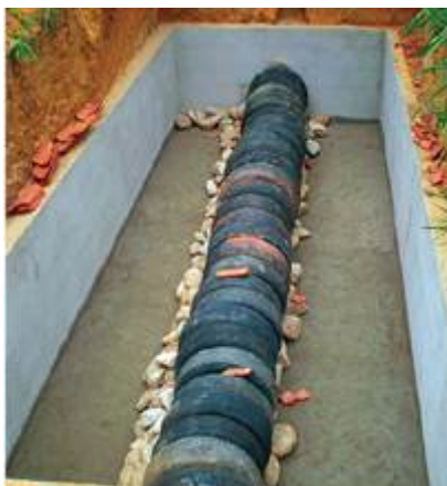
Figura 3.2 – TEvap – Trincheira impermeabilizada e câmara de digestão montada. Fonte: Leal, 2014.
