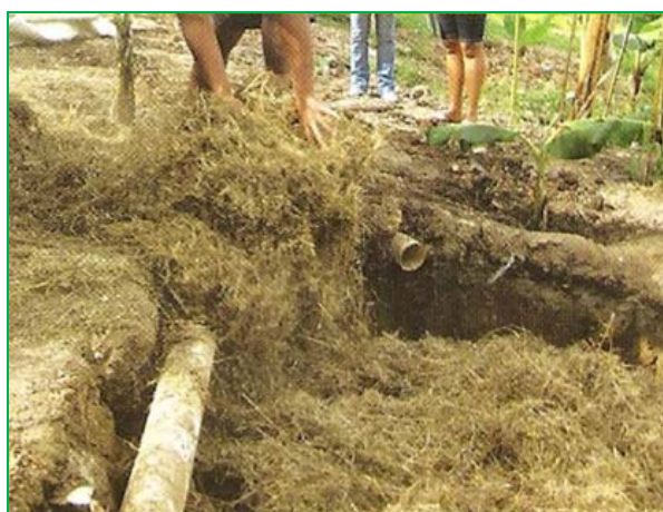
Figura 3.15 – Preenchimento da vala com palha seca. Fonte: Leal, 2016.
