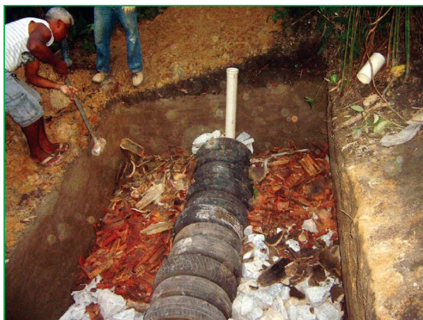
Figura 3.4 – TEvap – Tubo de entrada na câmara e enchimento da trincheira com entulho. Fonte: Leal, 2014.
