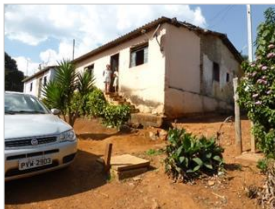
Figura 3.22 – Residências com caixa onde é feita a ligação à rede coletora.
