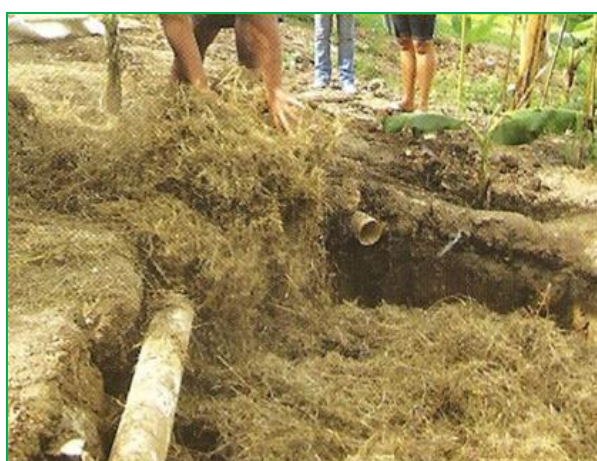
Figura 3.16 – Preenchimento da vala com palha seca.
