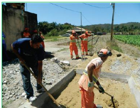
Figura 3.5 – Enchimento da trincheira com camada de areia. Fonte: Leal, 2014.
