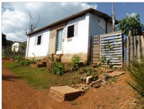
Figura 3.22 – Residências com caixa onde é feita a ligação à rede coletora.
