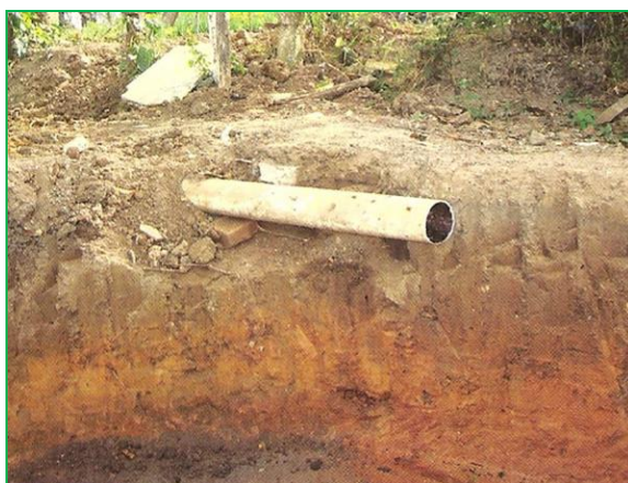
Figura 3.15 – Vala escavada e tubo de lançamento das águas cinzas.
