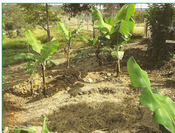
Figura 3.17 – Vala preenchida abaulada e com plantio no entorno
