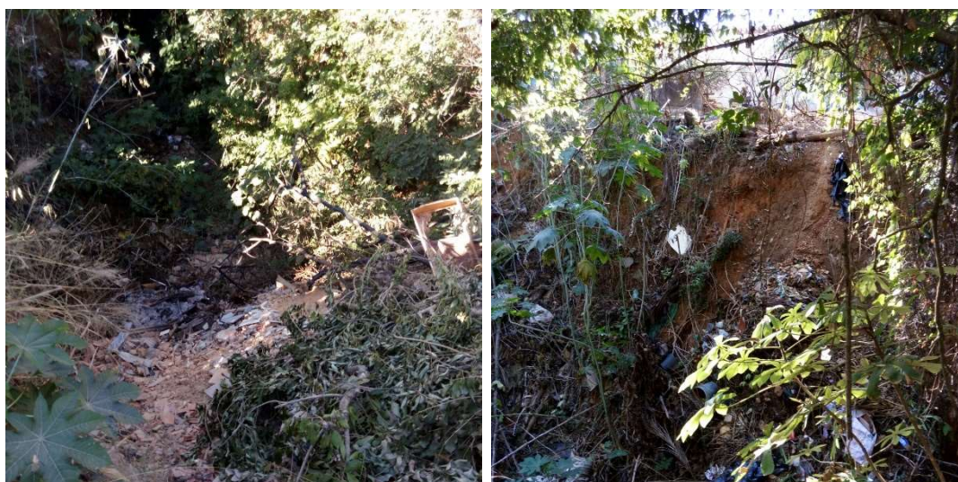
Figura 3.3 – Local do lançamento do bueiro do fundo de vale da Rua das Acácias.
