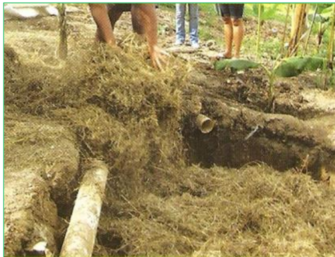
Figura 4.15 – Preenchimento da vala com palha seca. Fonte: Leal, 2016.
