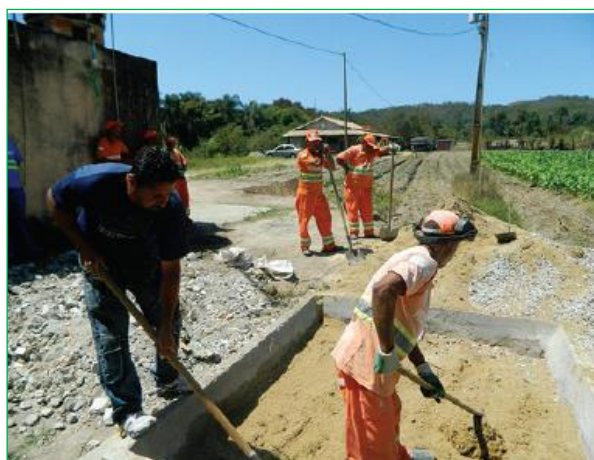
Figura 4.4 – Enchimento da trincheira com camada de areia. Fonte: Leal, 2014.
