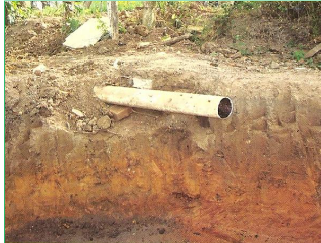
Figura 4.14 – Vala escavada e tubo de lançamento das águas cinzas. Fonte: Leal, 2016.
