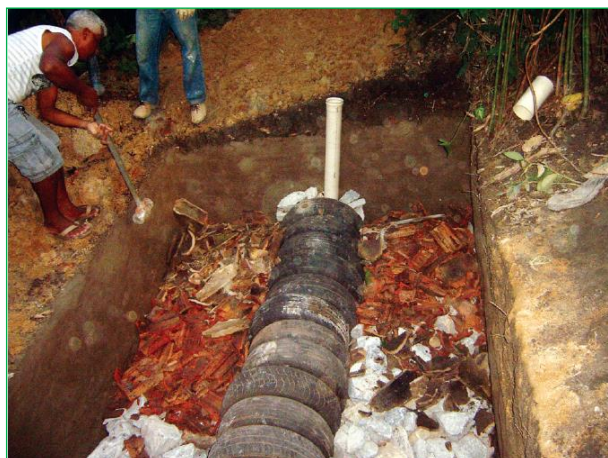
Figura 4.3 – TEvap – Tubo de entrada na câmara e enchimento da trincheira com entulho. Fonte: Leal, 2014.
