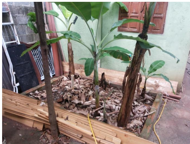
Figura 4.7 – TEvap em funcionamento com plantio de bananeiras e tubo de inspeção Local: Refúgio São Francisco, Serra do Cipó, Santana do Riacho, MG. Fonte: DHF Consultoria, 2017.
