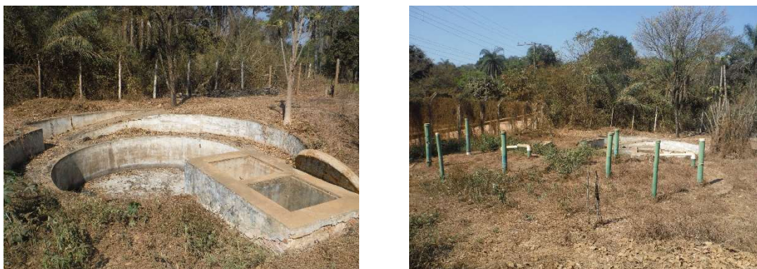
Figura 2.3 – Vista 1: Leito de Secagem e Vista 2: Visão geral.
