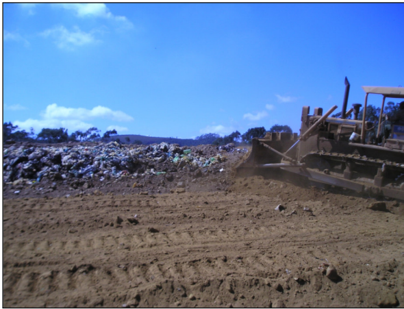
Figura 101. Compactação do lixo em camadas.
