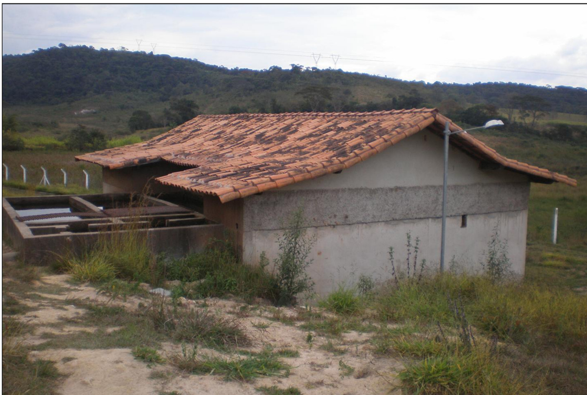
Figura 50. Elevatória de água bruta da ETA do Funil, distrito de Cachoeira do Campo.
