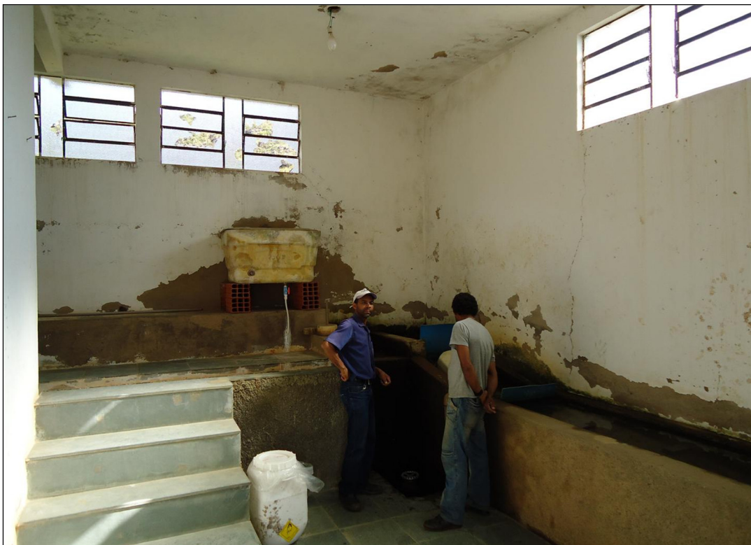
Figura 35. Interior da casa de tratamento.
