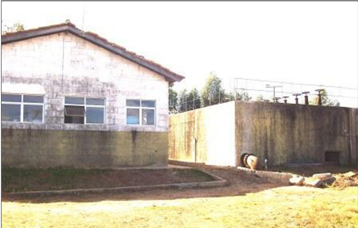
Figura 51. Vista da ETA do Funil.
