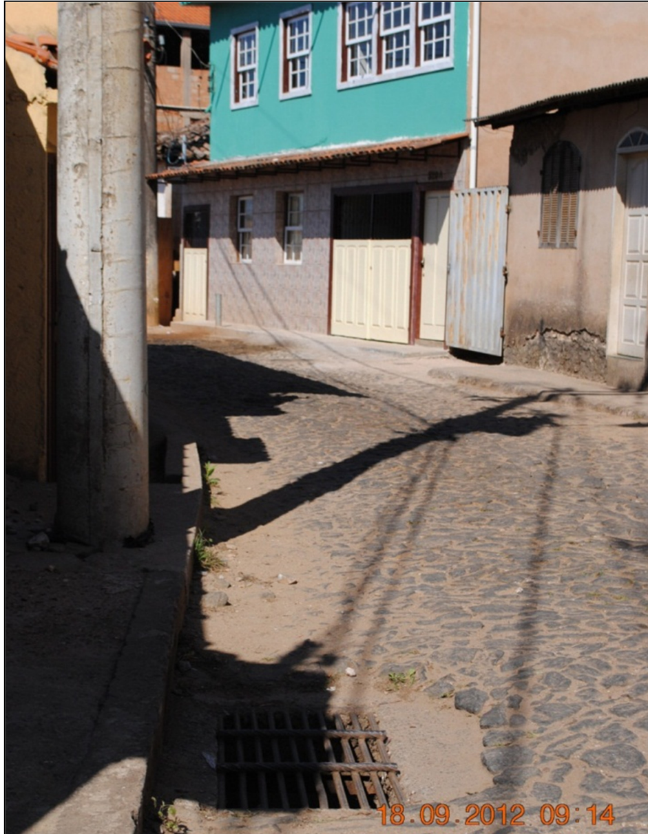
Figura 120. Ruas principais dos morros atendidas com rede de drenagem.
