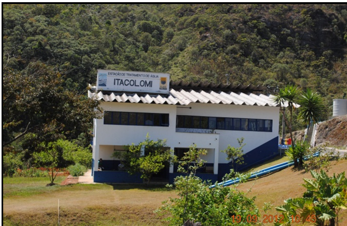
Figura 30. Captação da ETA Itacolomi no córrego Teixeira.
