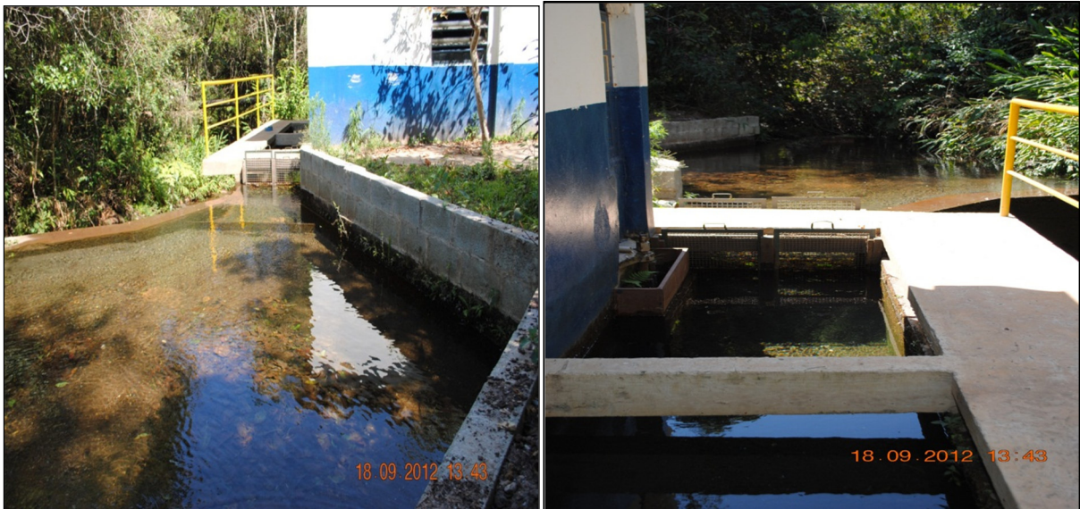
Figura 39. Captação da ETA Jardim Botânico no córrego Passa Dez.
