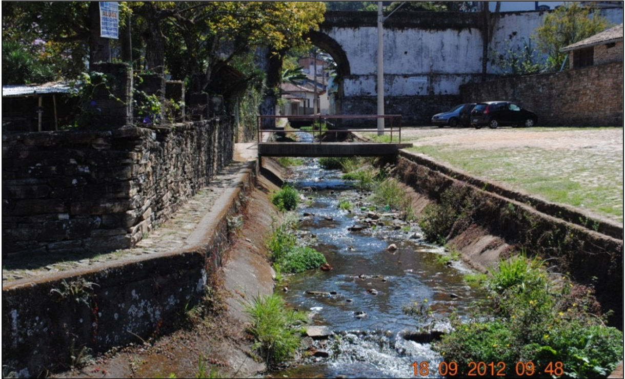
Figura 126. Canalização do córrego Sobreiro no bairro Antônio Dias.
