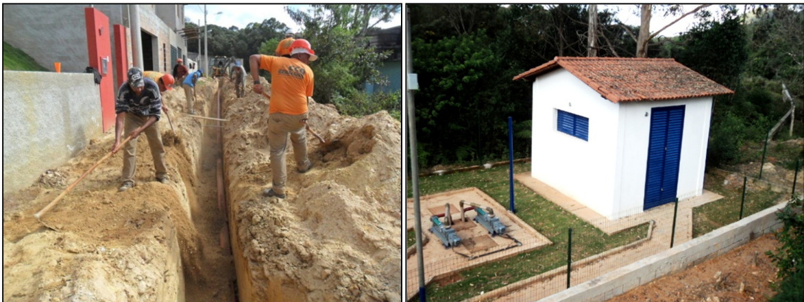
Figura 89. Estação elevatória de esgoto (EEE) do bairro São Sebastião.
