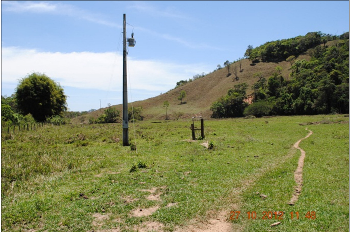
Figura 65. Captação de água no poço tubular profundo II.
