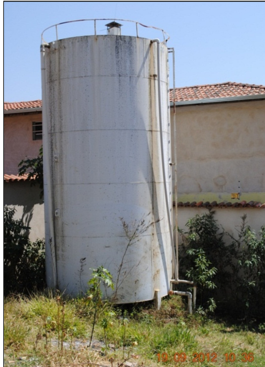
Figura 36. Reservatório Nossa Senhora do Carmo (Pocinho).
