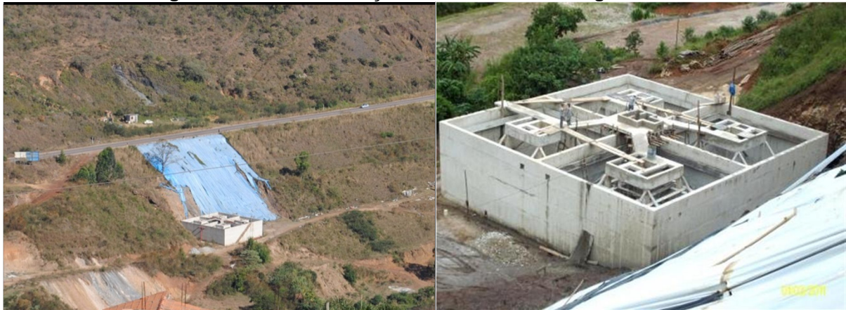
Figura 81. Obras da Estação de Tratamento de Esgoto – ETE.
