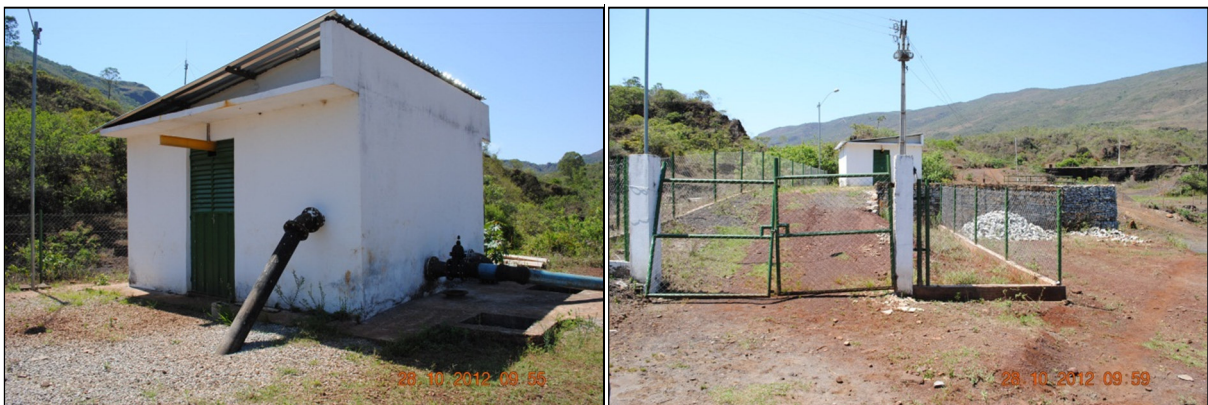
Figura 56. Elevatória de Água bruta de Antônio Pereira.
