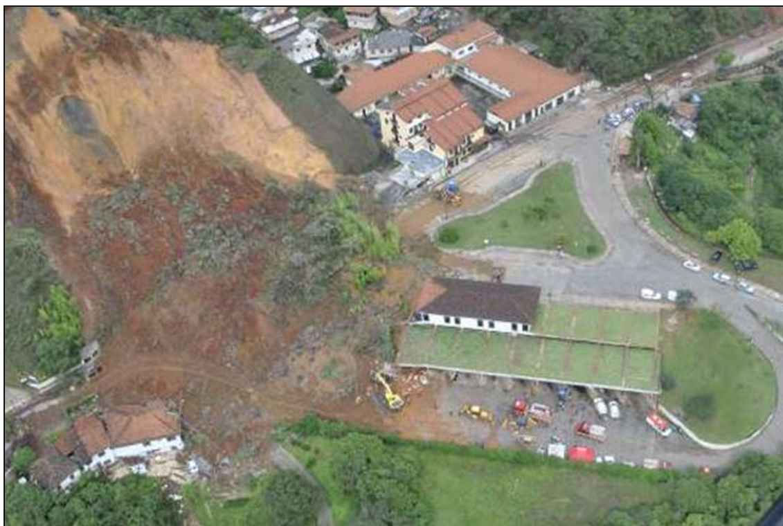
Figura 115. Av. Padre Rolim, local do deslizamento em Ouro Preto.
