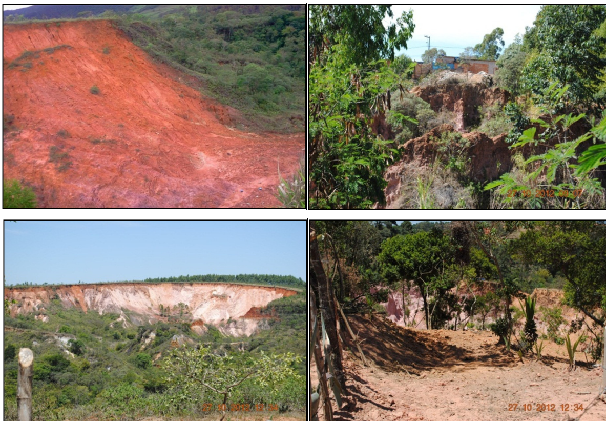
Figura 112. Voçoroca no município de Ouro Preto.
