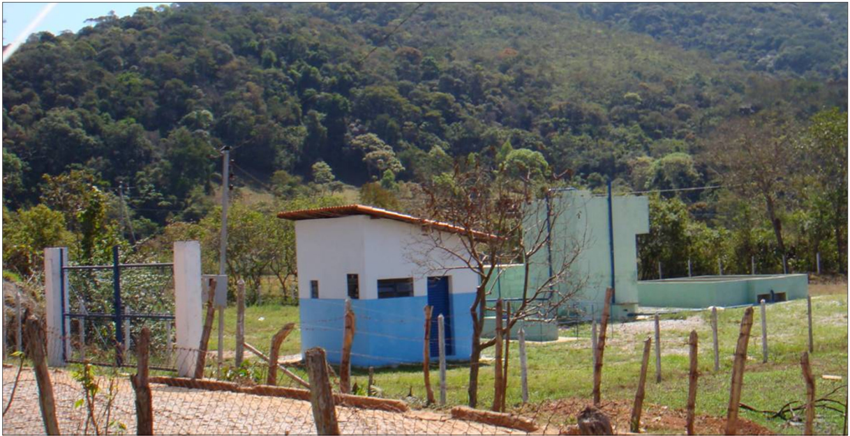
Figura 82. ETE São Bartolomeu.
