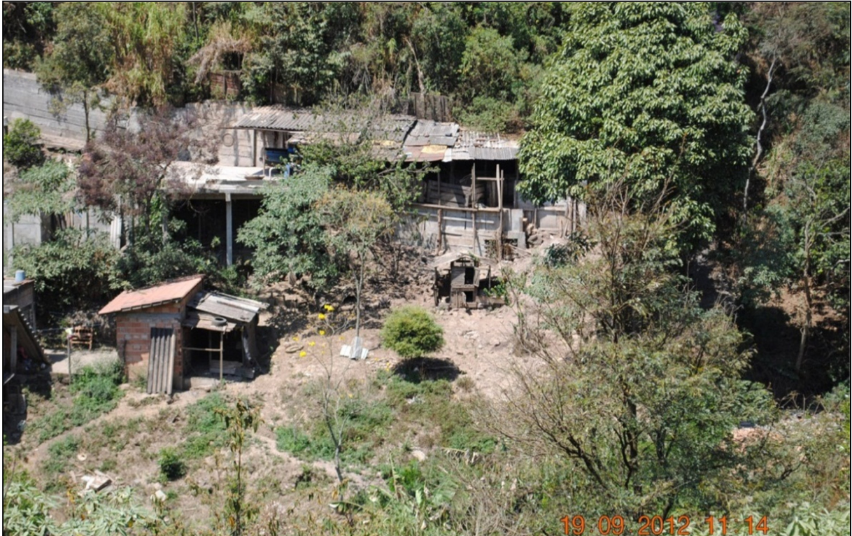
Figura 118. Exemplo de ocupação irregular próxima à área de inundação.
