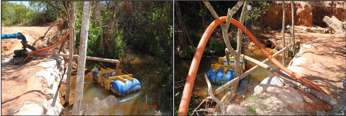
Figura 59. Captação provisória de água da ETA de Amarantina.
