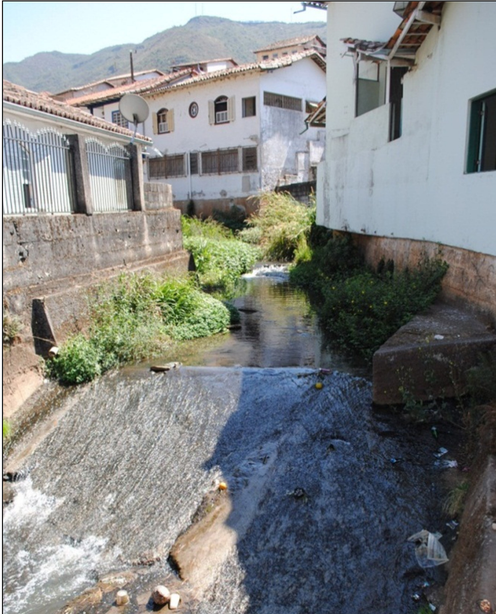
Figura 116. Canalização do Córrego Sobreiro do bairro Antônio Dias.
