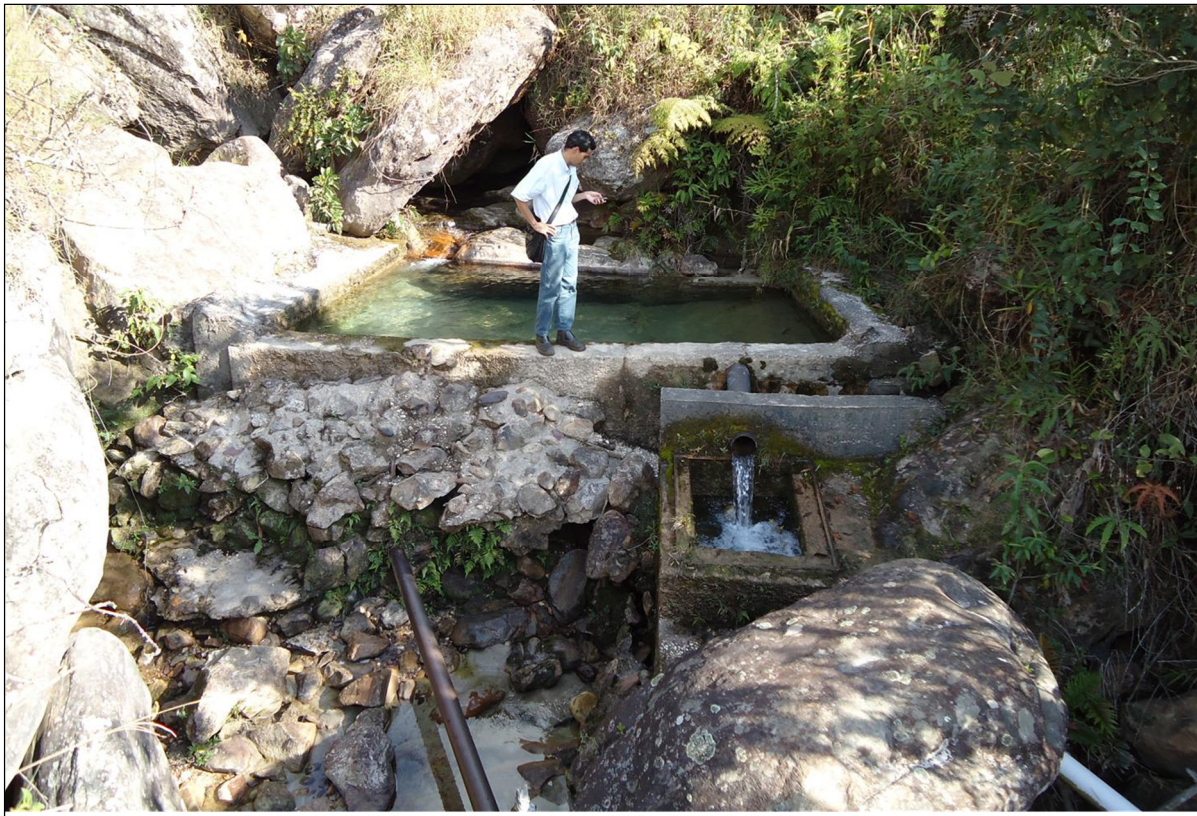
Figura 33. Captação do córrego do Pocinho.
