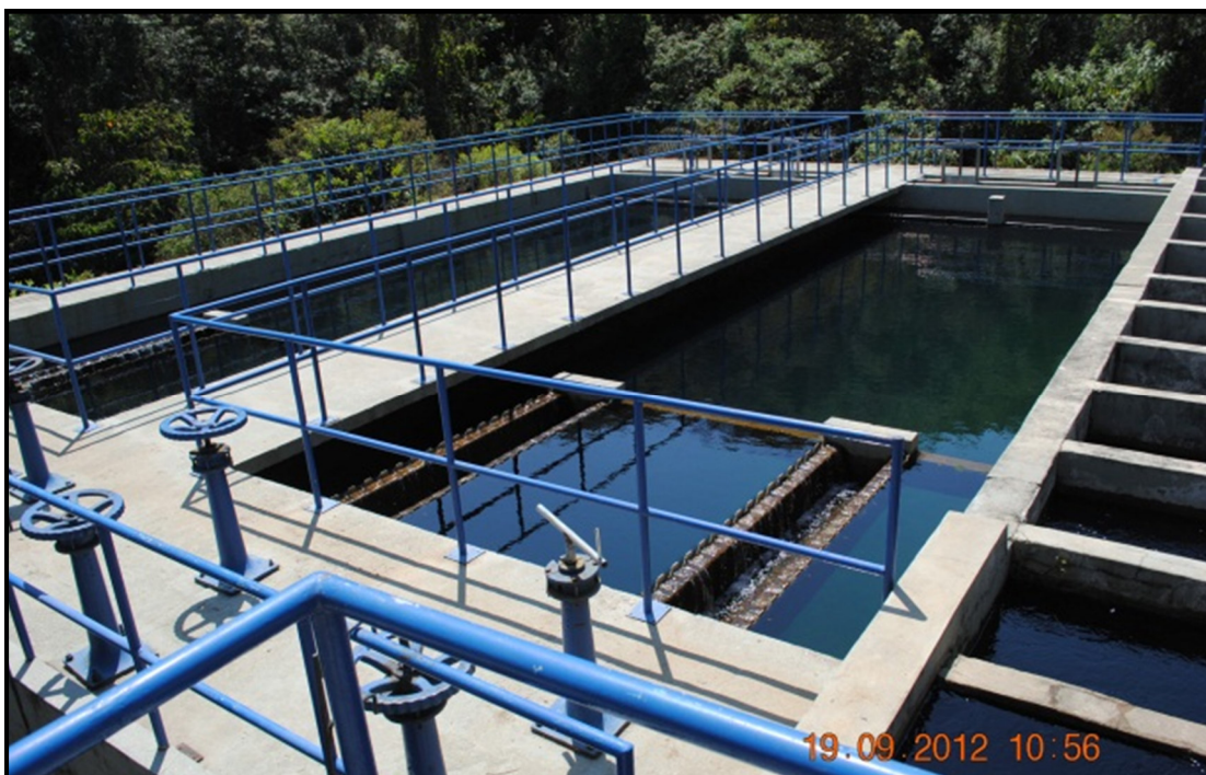
Figura 31. Vista dos decantadores da ETA Itacolomi.
