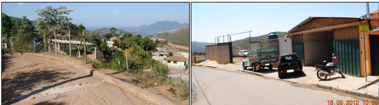
Figura 123. Inexistência de Rede de Drenagem.
