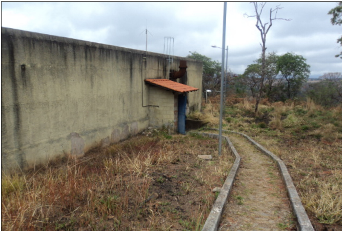
Figura 52. Vista do reservatório da ETA Funil.
