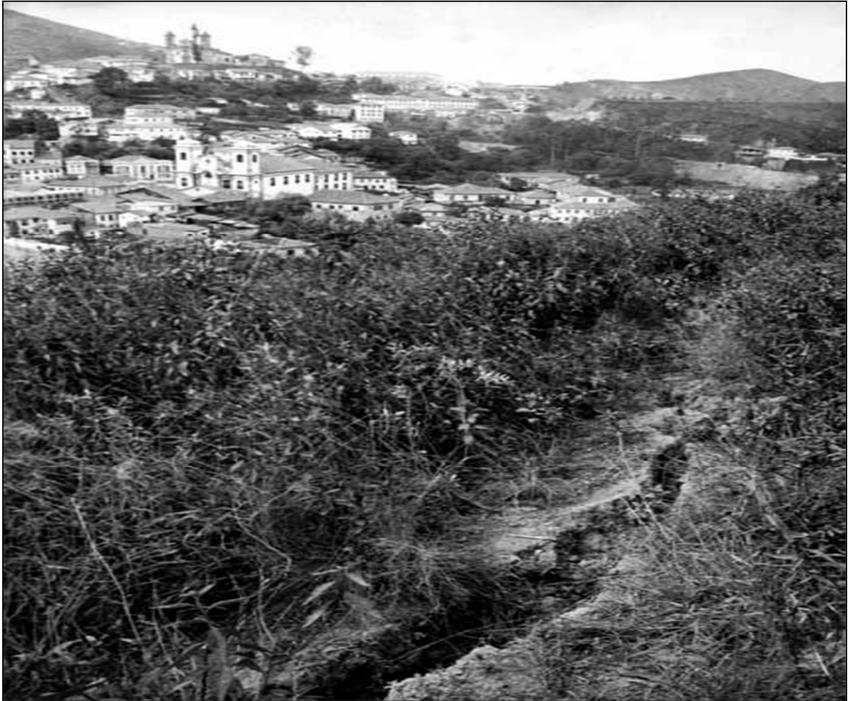
Figura 113. Fendas e deslizamentos ocorridos no ano de 1979 na Rua Dr. Orlando Ramos.
