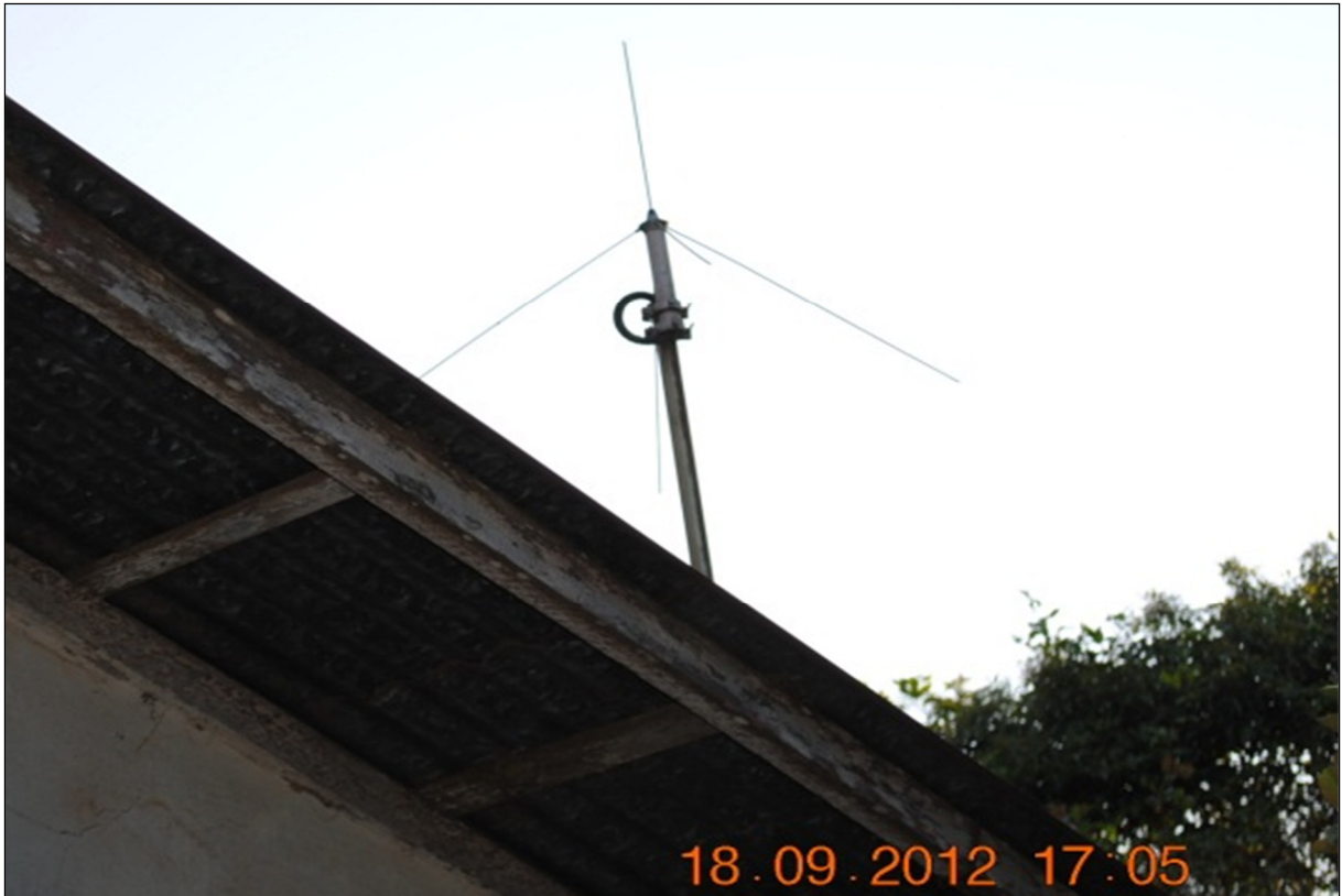
Figura 27. Telemetria do Sistema de Abastecimento de Água do SEMAE - OP - antena de transmissão.
