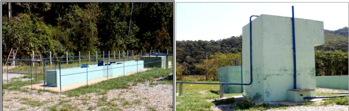
Figura 83. ETE de São Bartolomeu.
