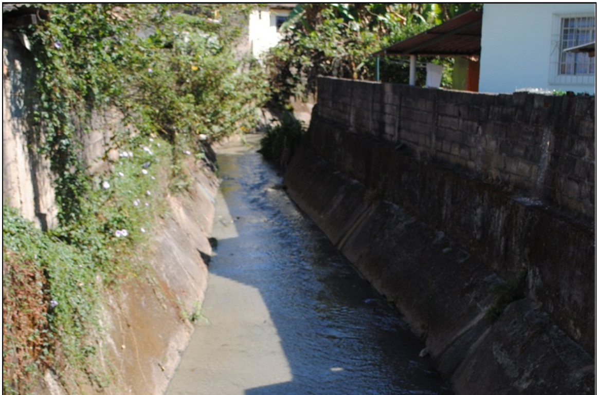
Figura 127. Canalização do córrego Sobreiro no bairro Antônio Dias.
