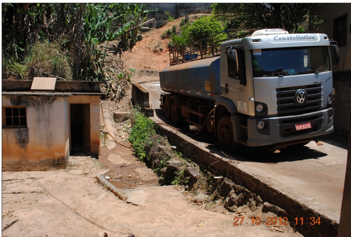
Figura 64. Abastecimento da elevatória de água tratada com caminhão pipa.
