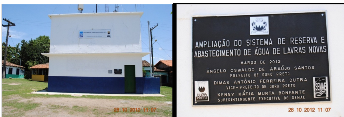
Figura 69. Reservatório da Praça de Lavras Novas.
