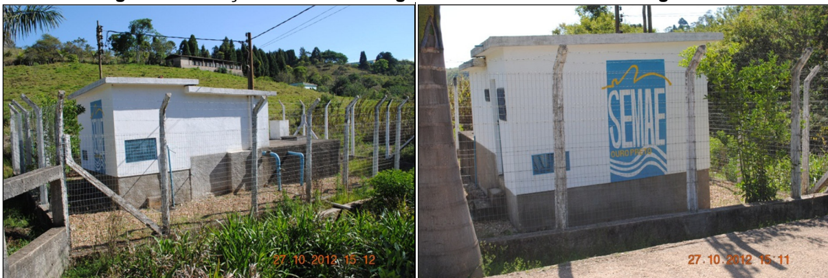
Figura 71. Estação Elevatória de água bruta do distrito de Rodrigo Silva.
