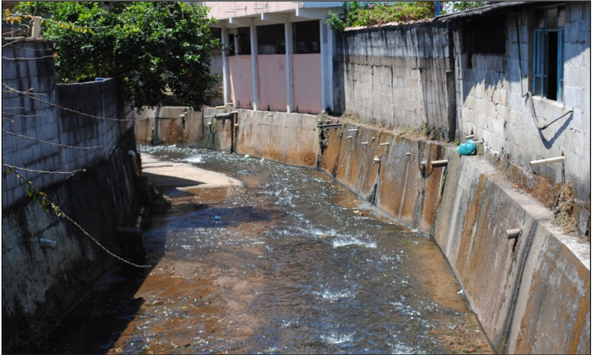
Figura 117. Canalização do Córrego Sobreiro do bairro Antônio Dias.
