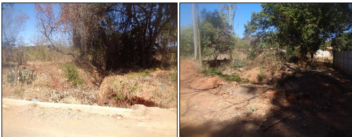
Figura 10. Drenagem do Córrego Sem Nome Fonte: LOCALMAQ Engenharia, 2017
