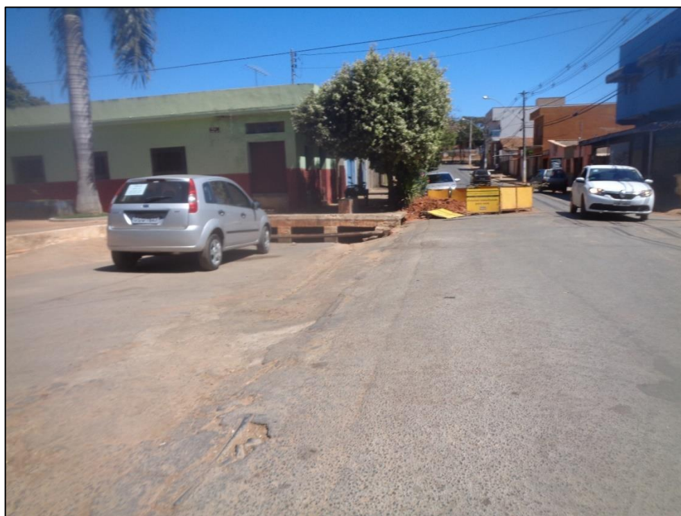
Figura 9. Córrego Pindaíba Fonte: LOCALMAQ Engenharia, 2017
