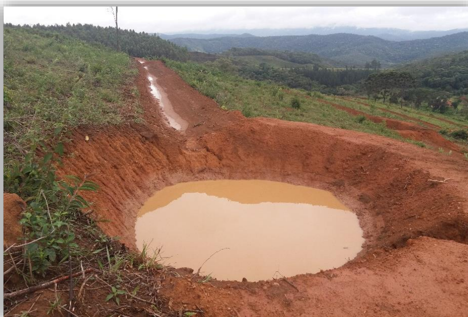
Figura 7: Foto ilustrativa de uma bacia de contenção tipo 2. Fonte: Inovesa, 2018
