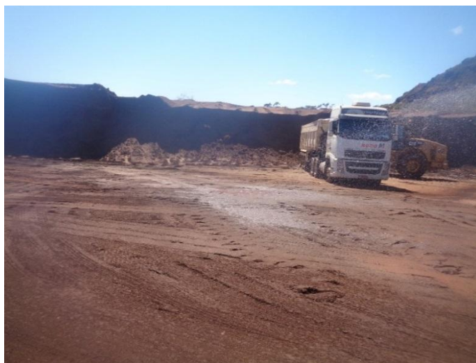
Figura 79. Remoção dos resíduos minerários / 635301,772 - 7807718,597 Fonte: LOCALMAQ (2017)
