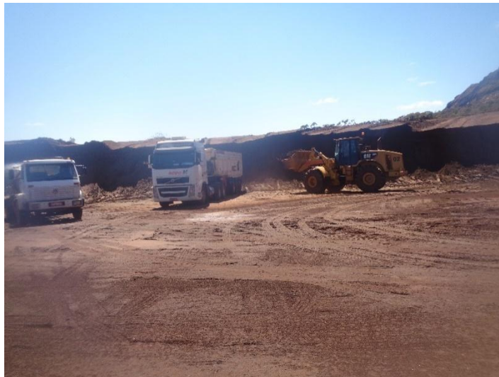
Figura 49. Remoção da pilha de rejeitos pela AVG Fonte: LOCALMAQ (2017)
