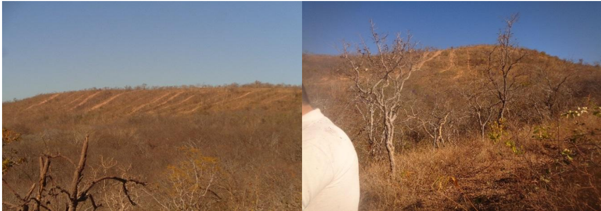
Figura 86. Erosão na microbacia do Córrego Curralinho 1 / 555327.00 - 7971204.0
