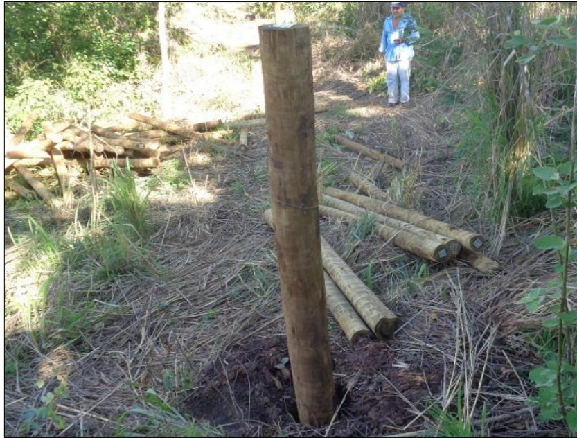
Figura 41 - Encaixe dos mourões esticadores Fonte: LOCALMAQ (2017)
