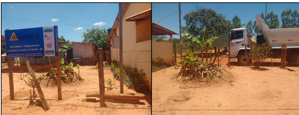
Figura 54 - Canteiro de Obras no Município de Lassance Fonte: LOCALMAQ (2017)
