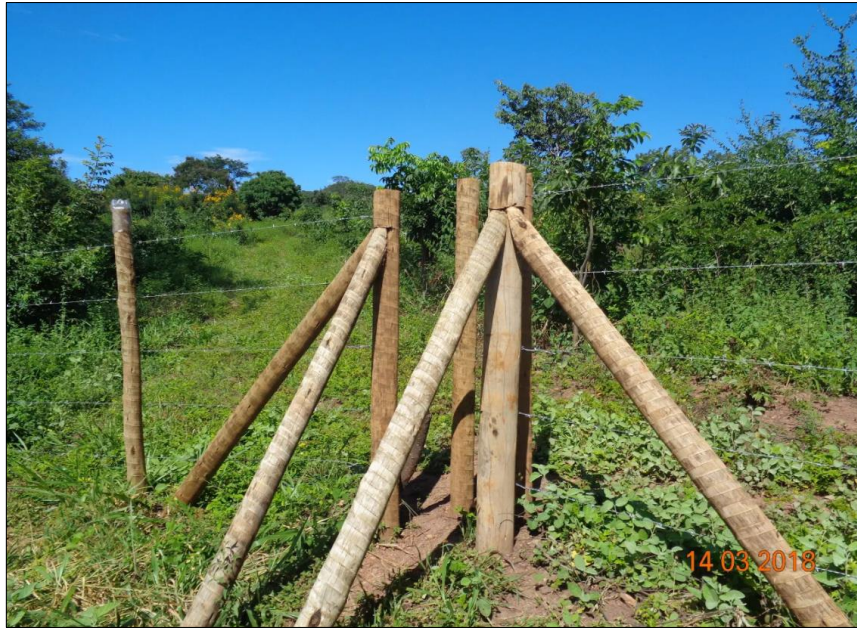
Figura 53 - Cercamento no Município de Várzea da Palma Fonte: LOCALMAQ (2017)
