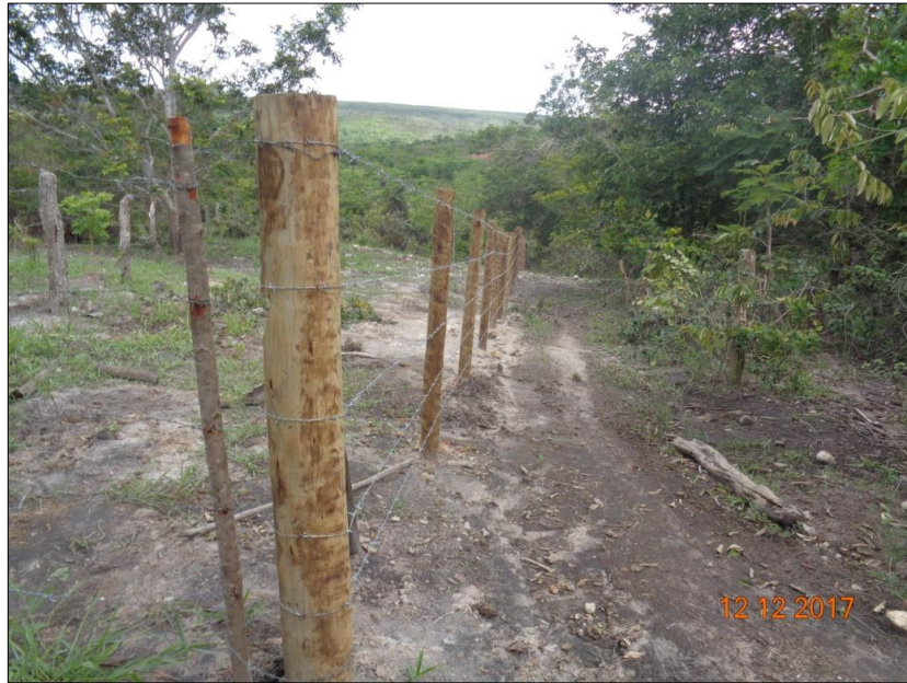
Figura 51 - Cercamento no Município de Várzea da Palma Fonte: LOCALMAQ (2017)
