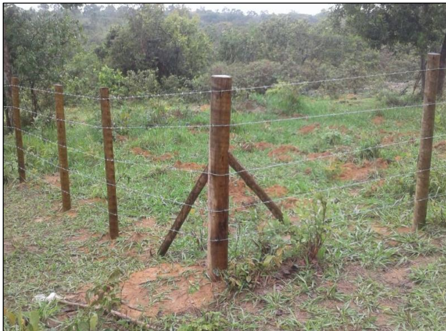
Figura 50 - Cercamento concluído Fonte: LOCALMAQ, 2017
