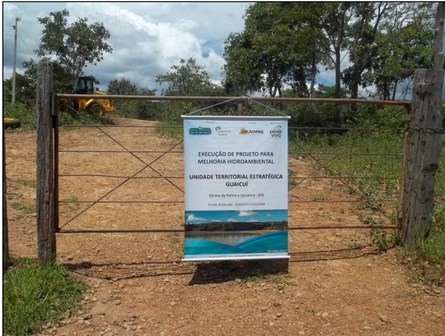
Figura 6 - Canteiro de obras da LOCALMAQ em Várzea da Palma Fonte: LOCALMAQ, 2017
