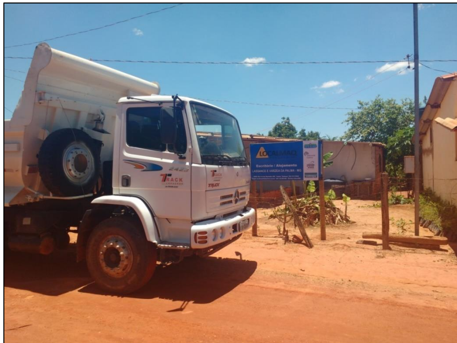
Figura 4 - Local de implantação do canteiro de obras em Lassance Fonte: LOCALMAQ, 2017
