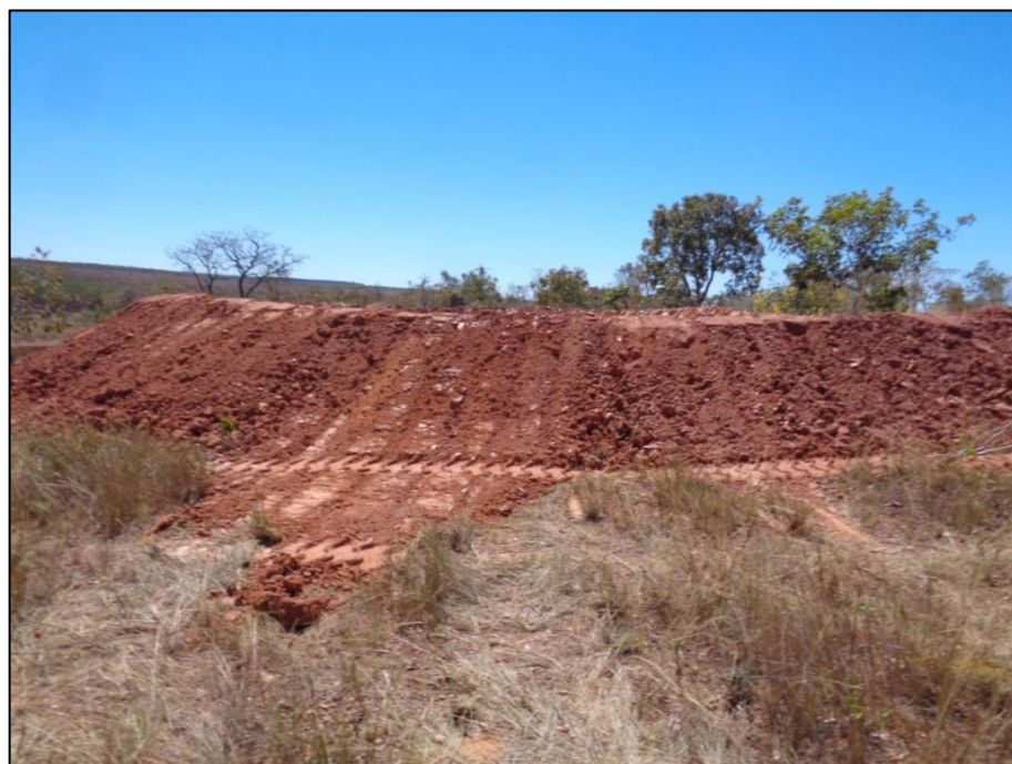
Figura 21 - Barragem concluída e aprovada pela fiscalização Fonte: LOCALMAQ, 2018
