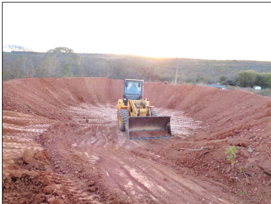
Figura 19 - Construção das sarjetas e bigodes Fonte: LOCALMAQ, 2018
