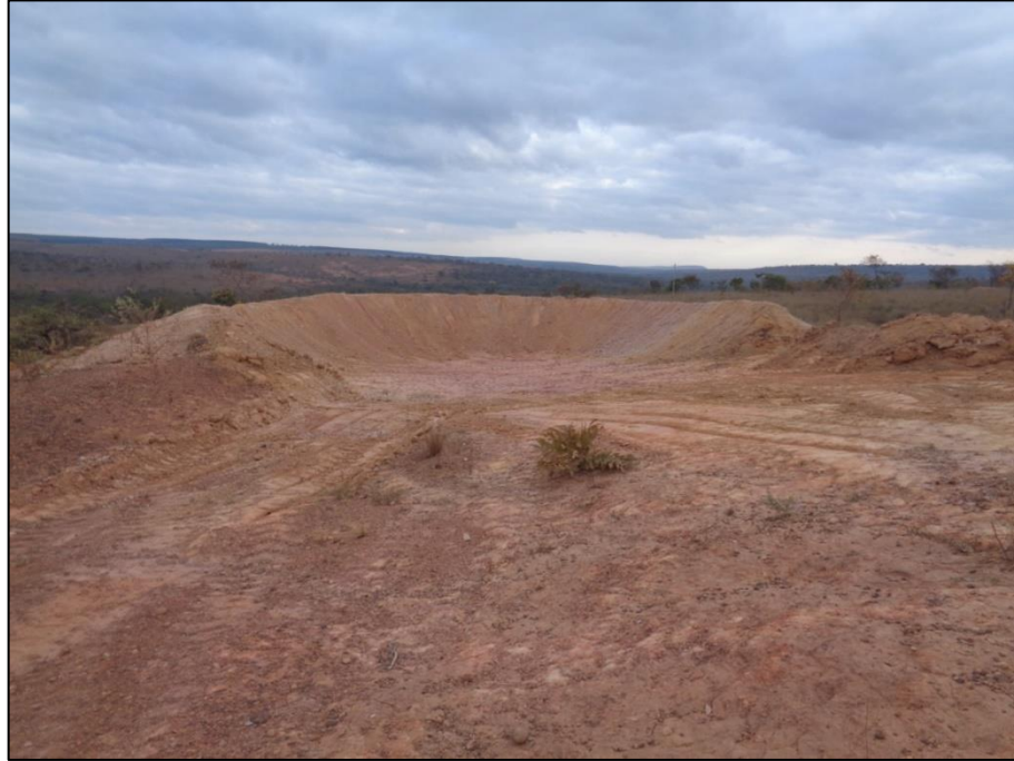
Figura 28 - Barragem concluída e aprovada pela fiscalização Fonte: LOCALMAQ, 2018
