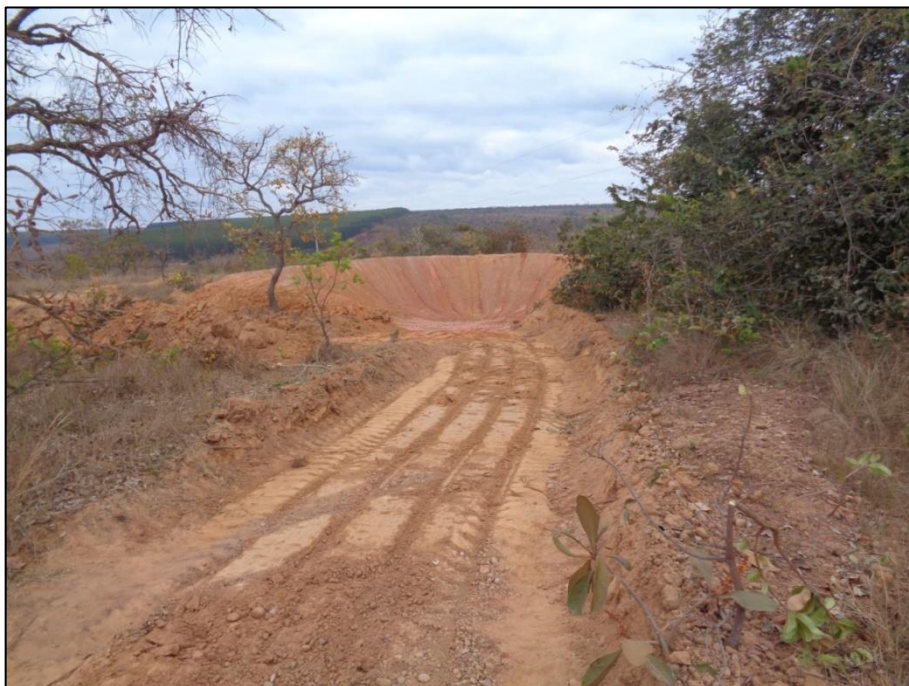
Figura 27 - Barragem concluída e aprovada pela fiscalização Fonte: LOCALMAQ, 2018
