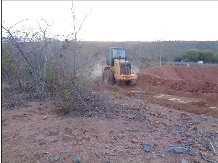
Figura 18 - Construção das sarjetas e bigodes Fonte: LOCALMAQ, 2018
