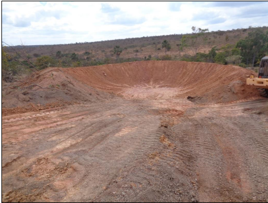
Figura 26 - Barragem concluída e aprovada pela fiscalização Fonte: LOCALMAQ, 2018
