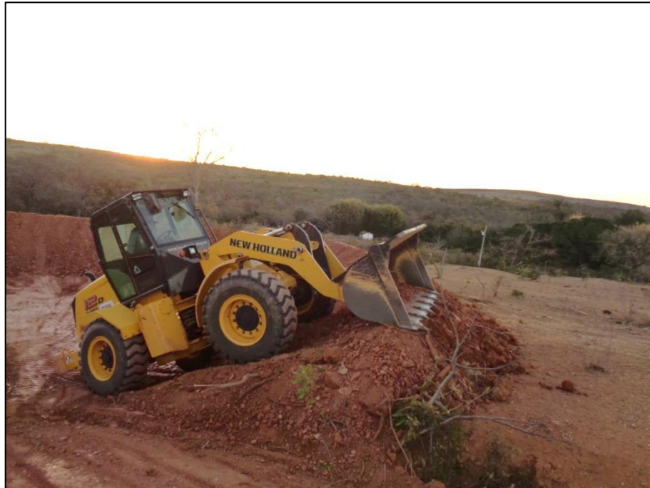
Figura 14 - Compactação do material escavado no entorno da barragem Fonte: LOCALMAQ, 2018
