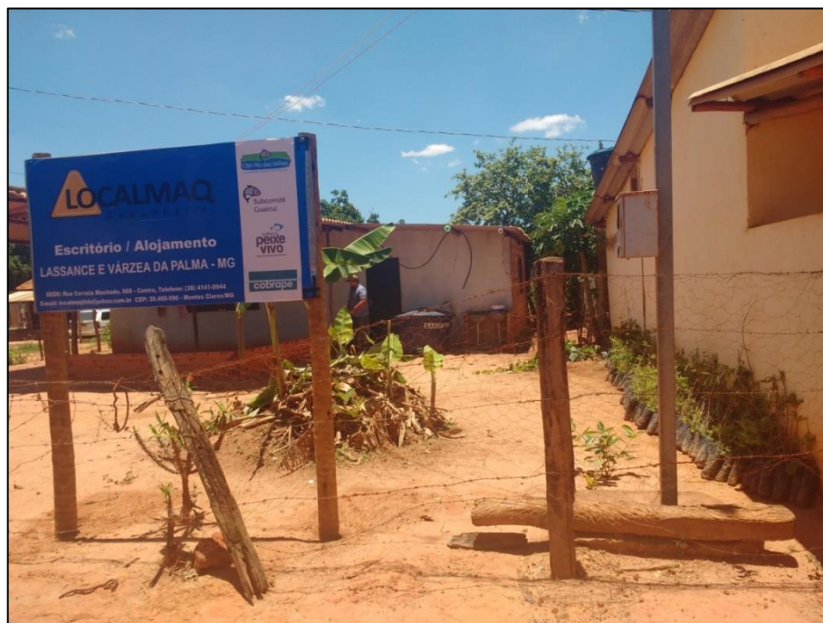
Figura 5 - Canteiro de obras da LOCALMAQ em Lassance Fonte: LOCALMAQ, 2017
