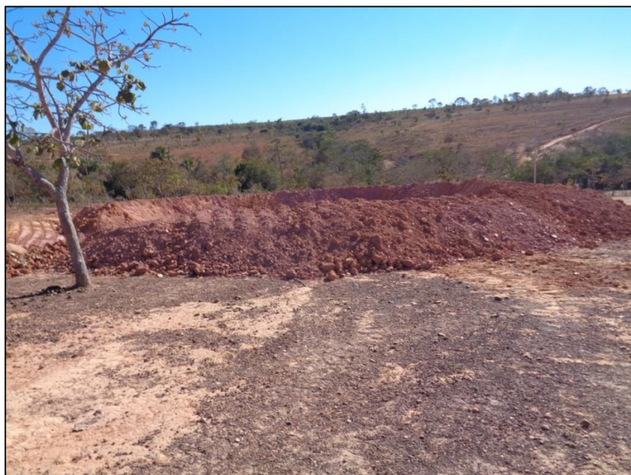
Figura 25 - Barragem concluída e aprovada pela fiscalização Fonte: LOCALMAQ, 2018
