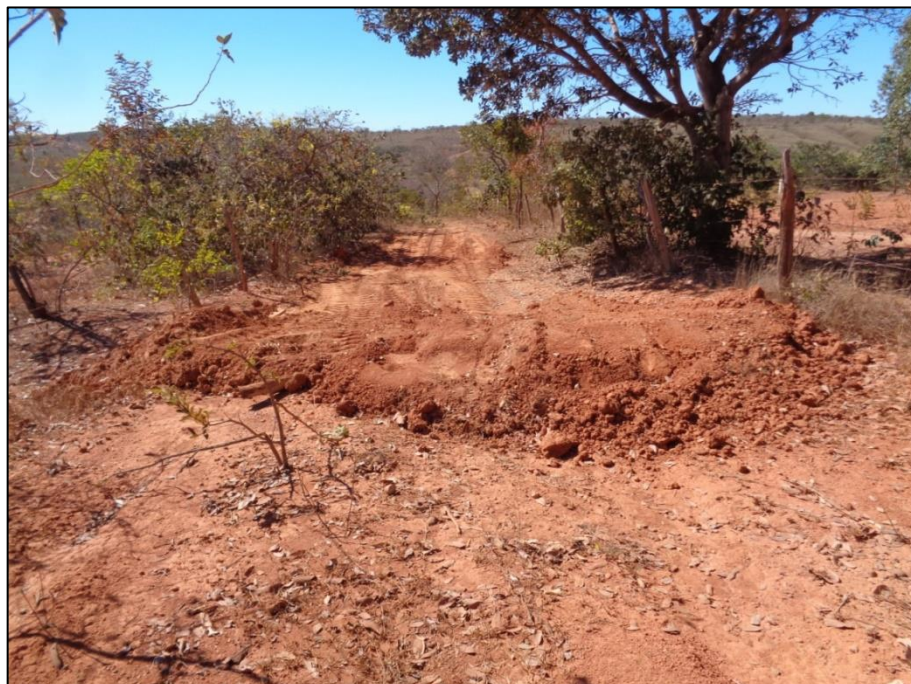
Figura 15 - Lombada em fase de execução Fonte: LOCALMAQ, 2018
