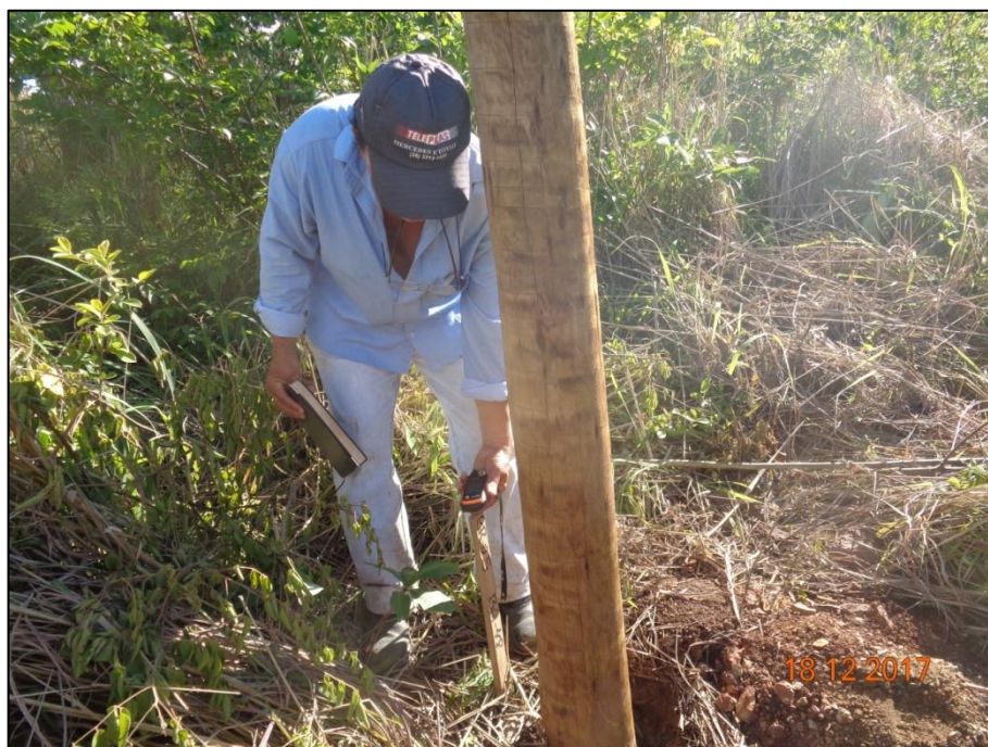
Figura 47 - Conferência dos de locação topográfica da cerca Fonte: LOCALMAQ, 2017
