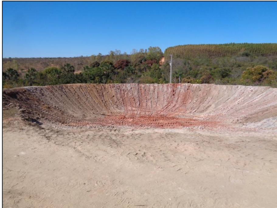
Figura 24 - Barragem concluída e aprovada pela fiscalização Fonte: LOCALMAQ, 2018
