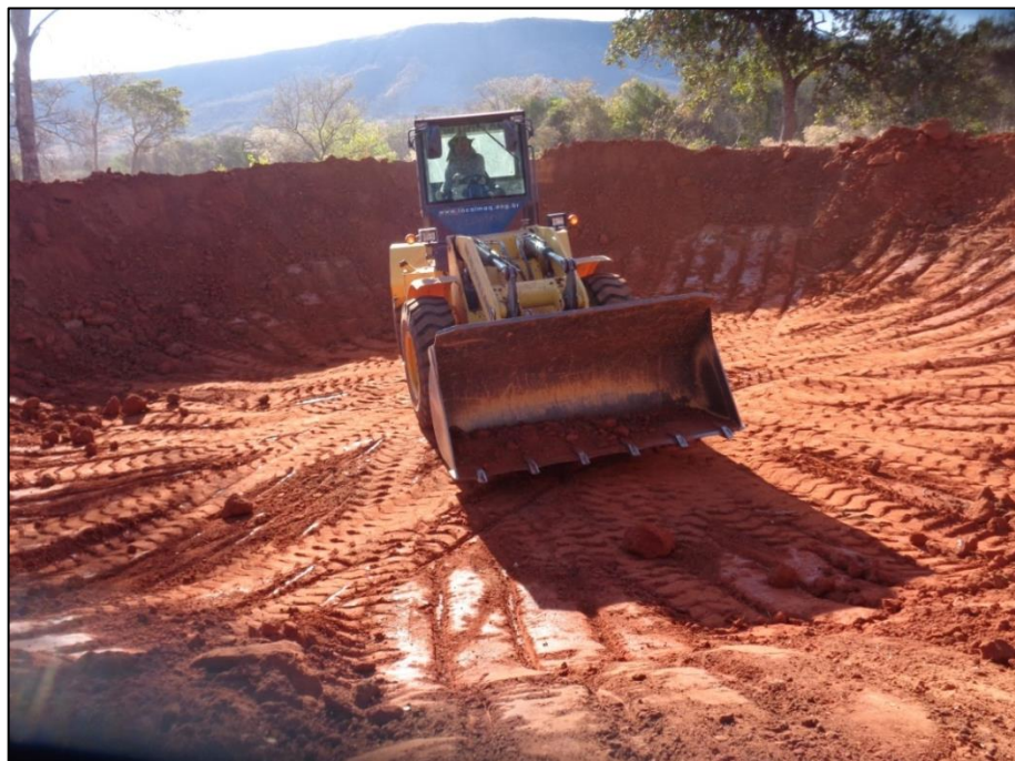
Figura 13 - Escavação das barraginhas Fonte: LOCALMAQ, 2018
