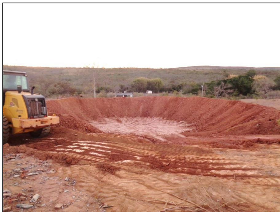
Figura 17 - Construção das sarjetas e bigodes Fonte: LOCALMAQ, 2018
