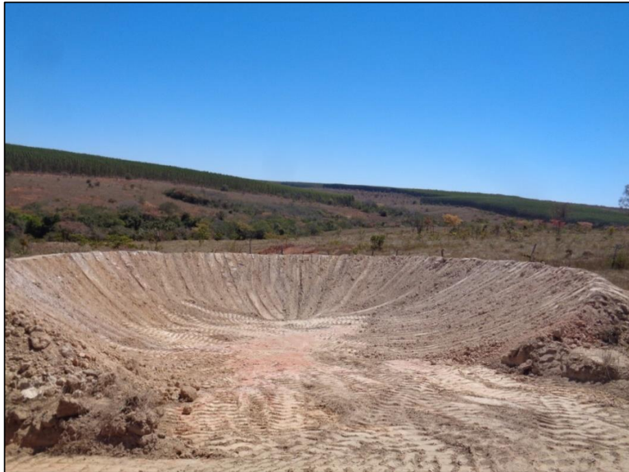
Figura 20 - Barragem concluída e aprovada pela fiscalização Fonte: LOCALMAQ, 2018
