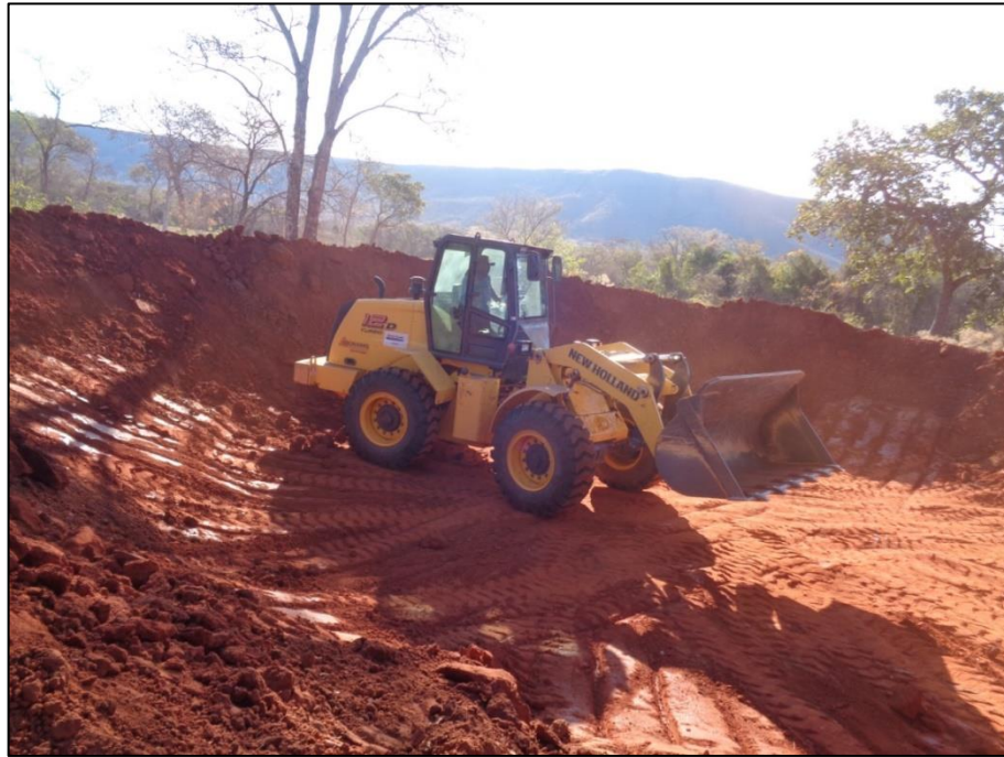
Figura 12 - Escavação das barraginhas Fonte: LOCALMAQ, 2018
