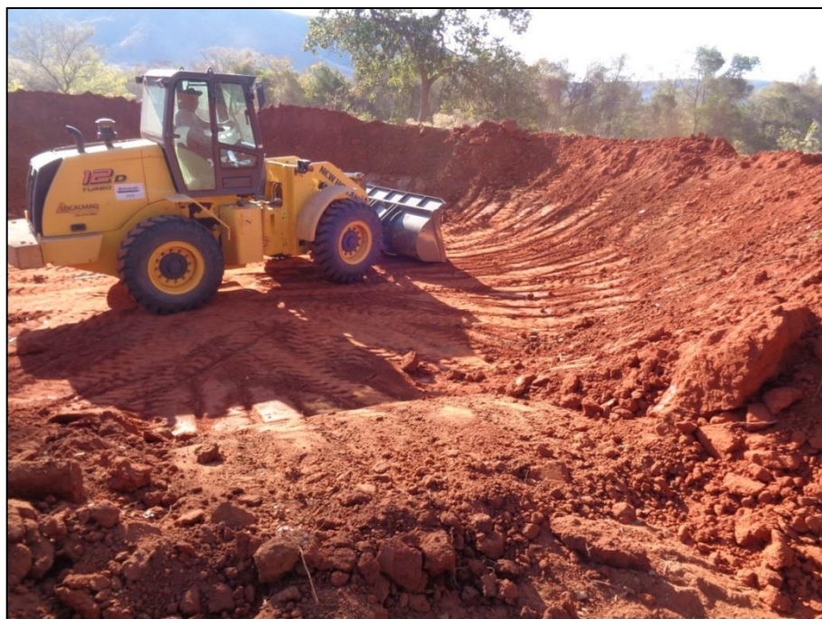
Figura 11 - Escavação das barraginhas
