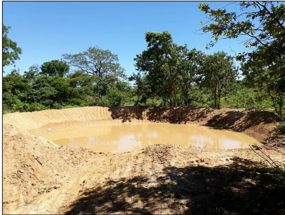
Figura 30 - Barragem em funcionamento Fonte: LOCALMAQ, 2018
