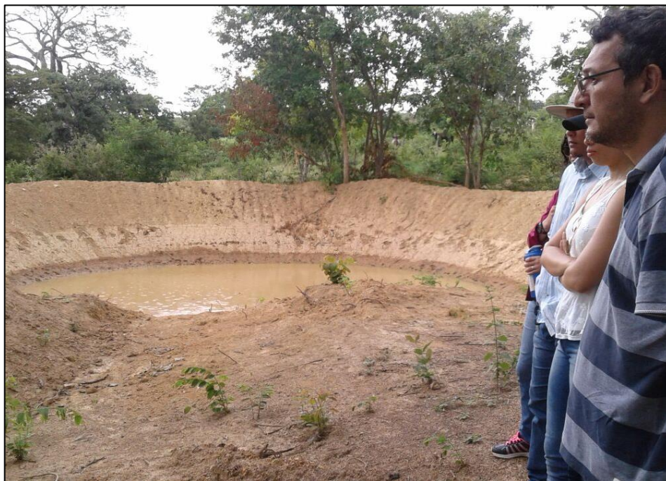
Figura 29 - Barragem em funcionamento Fonte: LOCALMAQ, 2018
