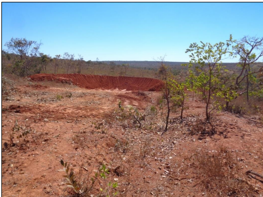
Figura 23 - Barragem concluída e aprovada pela fiscalização Fonte: LOCALMAQ, 2018
