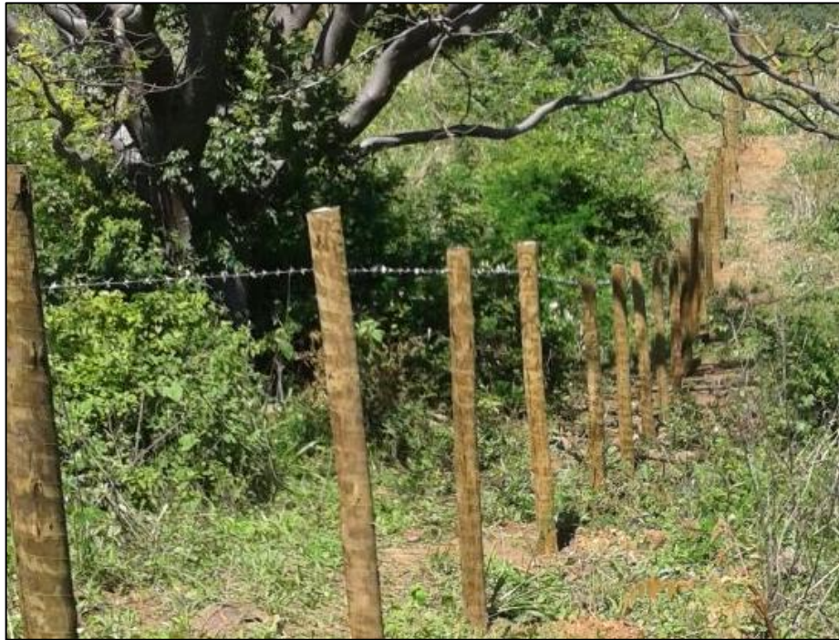
Figura 49 - Fixação do arame farpado Fonte: LOCALMAQ, 2017
