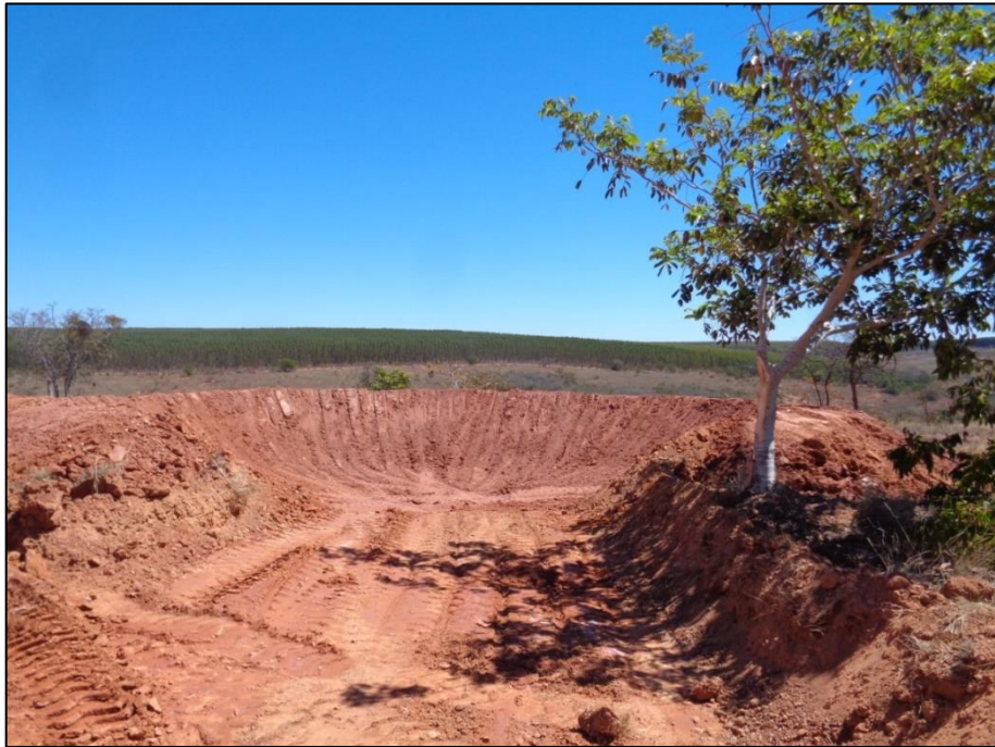
Figura 22 - Barragem concluída e aprovada pela fiscalização Fonte: LOCALMAQ, 2018
