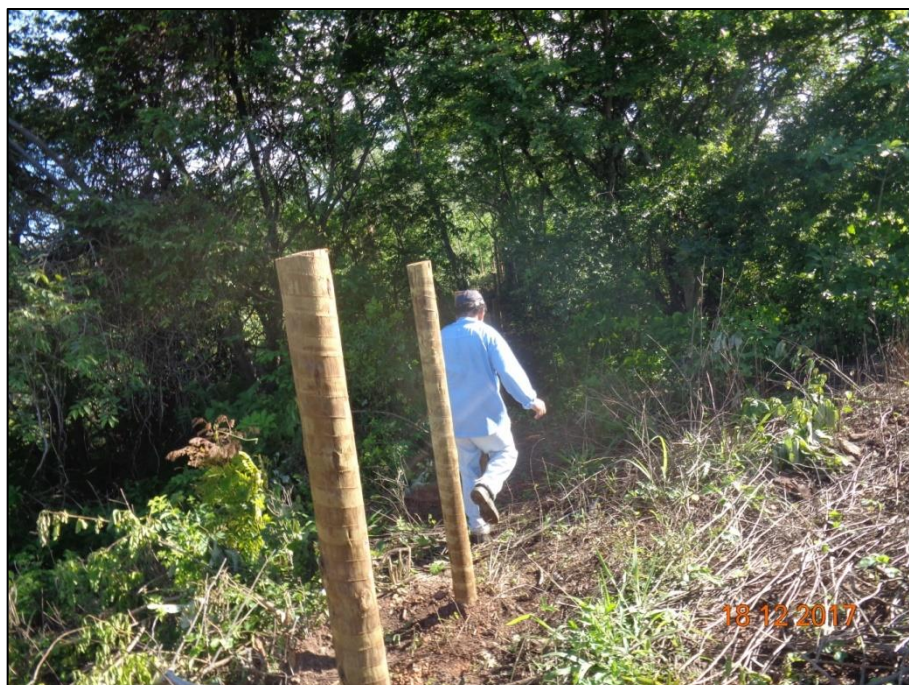
Figura 48 - Fixação dos mourões Fonte: LOCALMAQ, 2017
