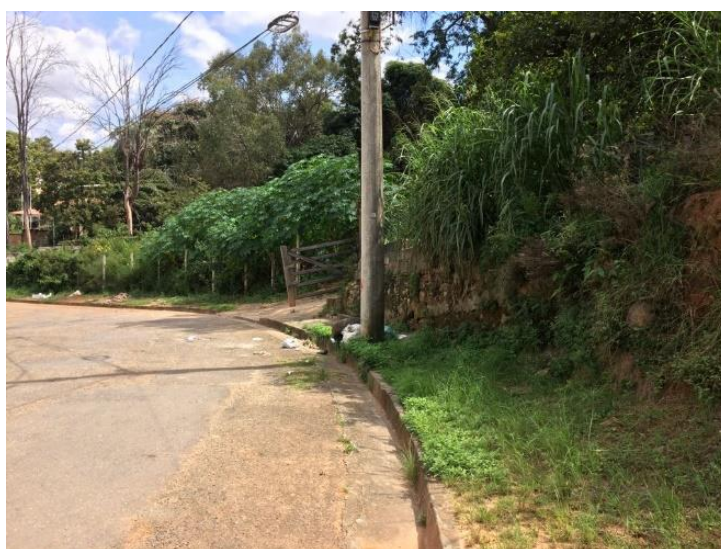
Figura 6.5 – Muro em torno da propriedade do Sr. Humberto Ferreira
