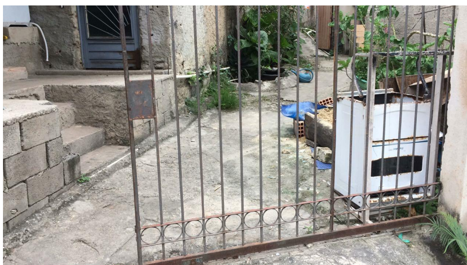
Figura 6.12 – Piso no local de acesso à nascente AR – 078
