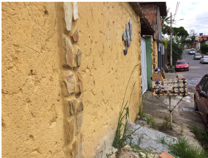
Figura 6.21 – Passeio e muro da nascente AR – 170
