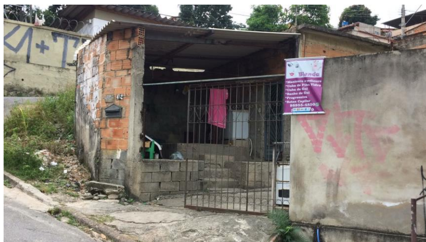
Figura 6.10 – Passeio de acesso à Nascente AR - 078
