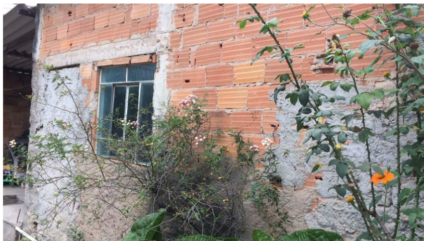
Figura 6.13 – Parede da propriedade da Nascente AR – 078
