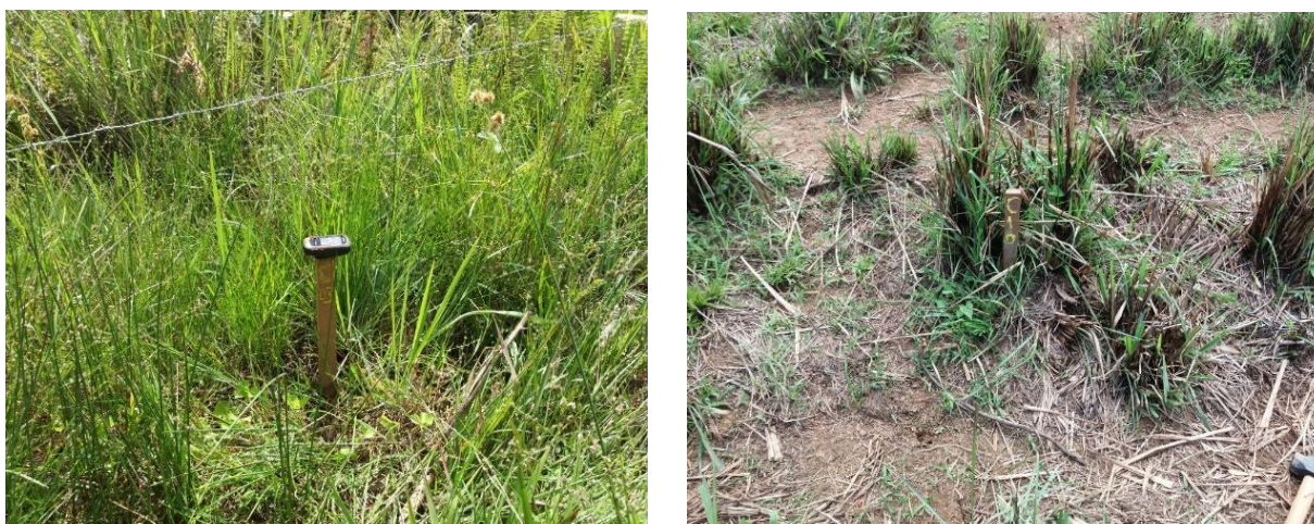
Figura 7 – Locação e estaqueamento de cercas na microbacia do Córrego Andaime
