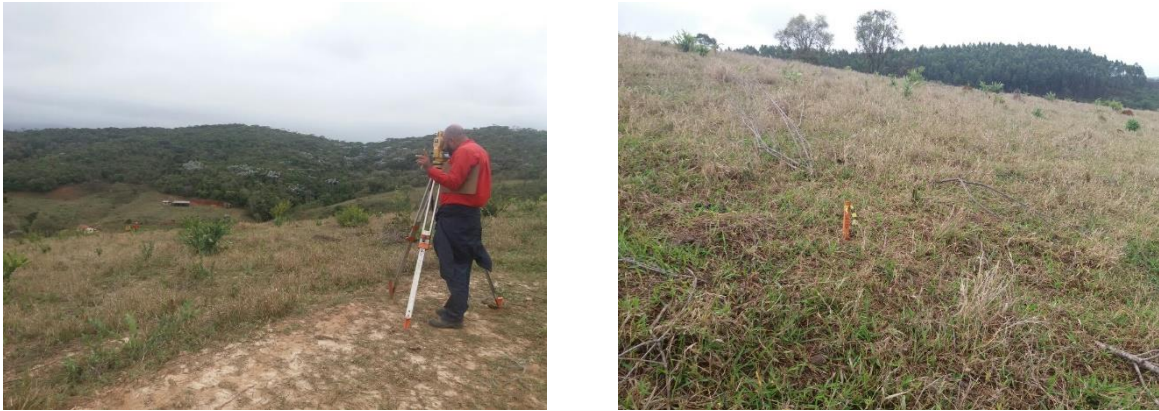
Figura 3 – Locação dos terraços em gradiente na microbacia do Córrego Jequeti
