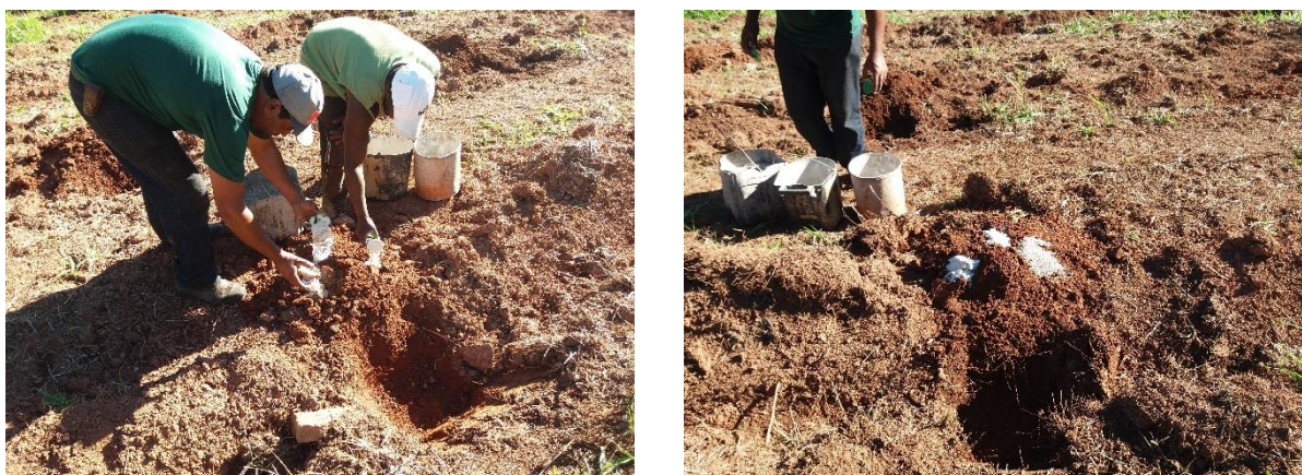
Figura 10 - Adição dos insumos ao solo escavado
