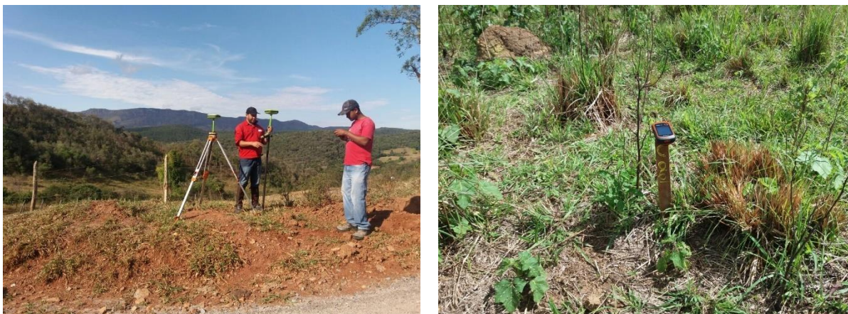
Figura 5 – Levantamento planialtimétrico e georreferenciamento para locação e estaqueamento das intervenções
