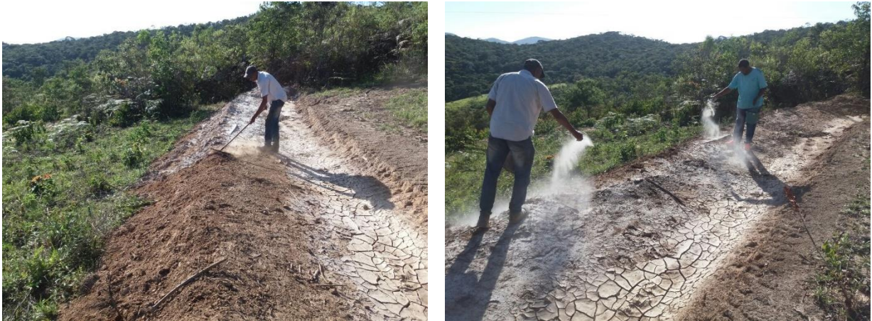
Figura 18 – Plantio de braquiária nos terraços em gradiente na microbacia do Córrego Jequeti
