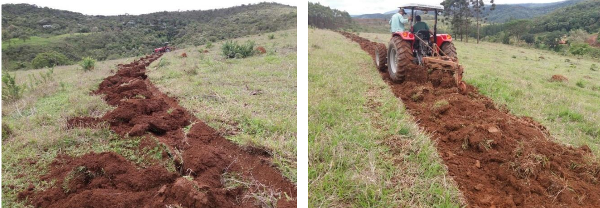
Figura 16 – Execução de terraços em gradiente na Área II – microbacia do Córrego Jequeti
