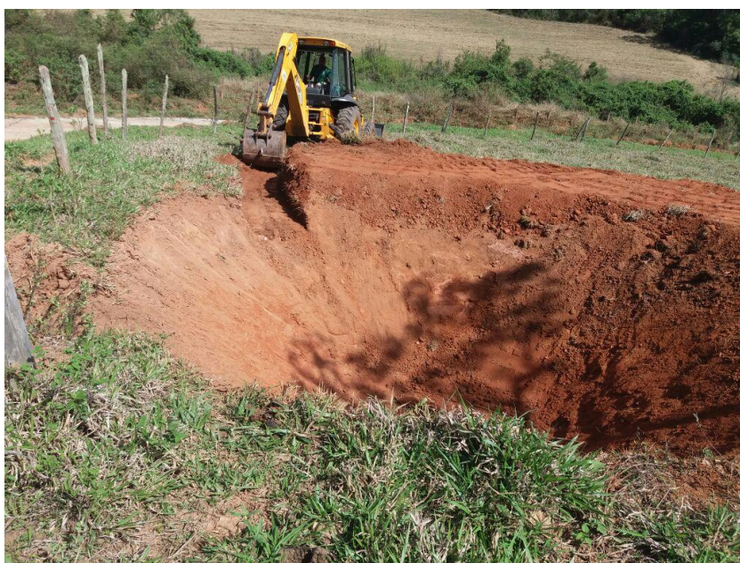
Figura 7 - Construção das bacias de contenção
