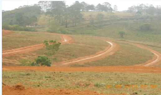
Construção de Terraço
