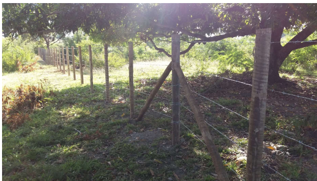
Construção de cerca
