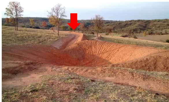
Terraceamento / Bacia de contenção
