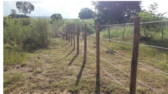
Construção de cerca
