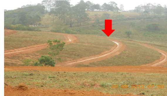
Construção de Terraço
