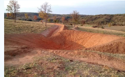
Terraceamento / Bacia de contenção
