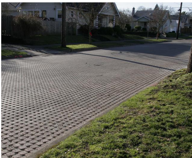
Figura 13 – Via pavimentada com blocos intertravados de concreto
