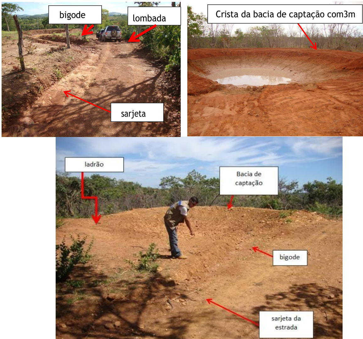
Figura 5.14 – Bacias de captação para coleta de enxurrada gerada em estrada rural
