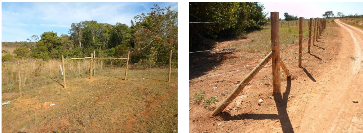
Figura 5.6 – Cercas construídas em projetos hidroambientais na bacia do Rio São Francisco
