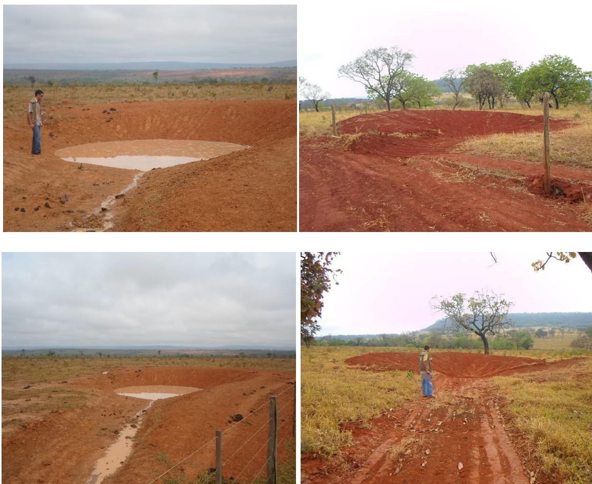
Figura 5.12 – Bacias de captação para coleta de enxurrada gerada em estrada rural
