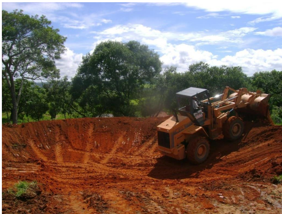
Figura 5.13 – Pá-carregadeira durante a construção de uma bacia de captação
