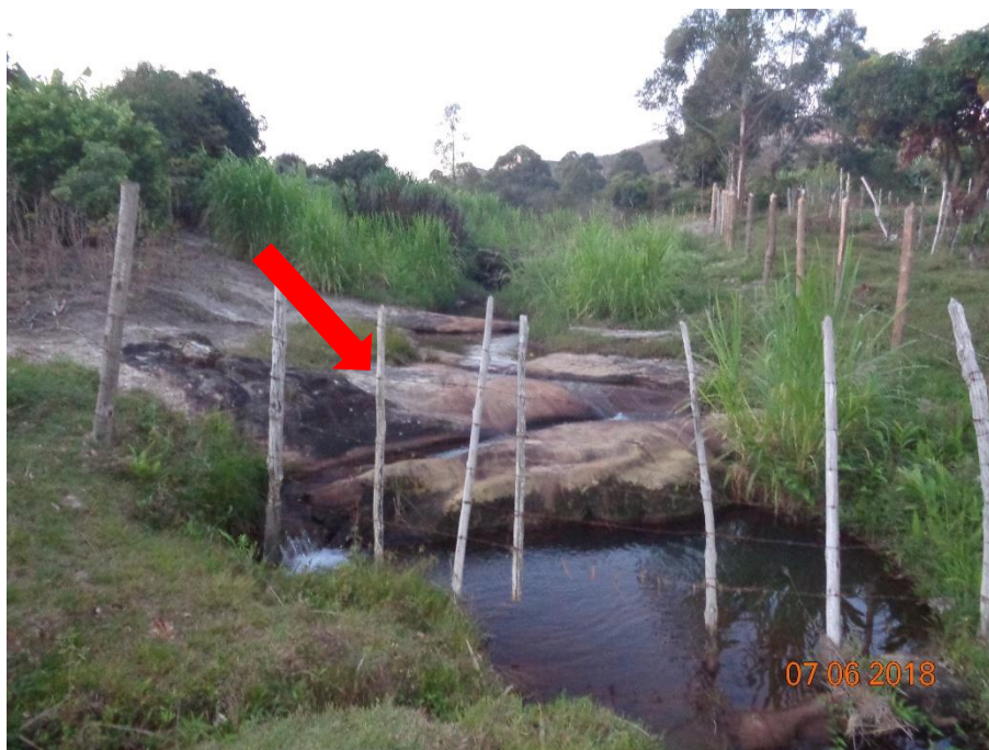
Figura 13 – Presença de afloramento rochoso nos locais de intervenção do cercamento – Área 3 Fonte: LOCALMAQ (2018)
