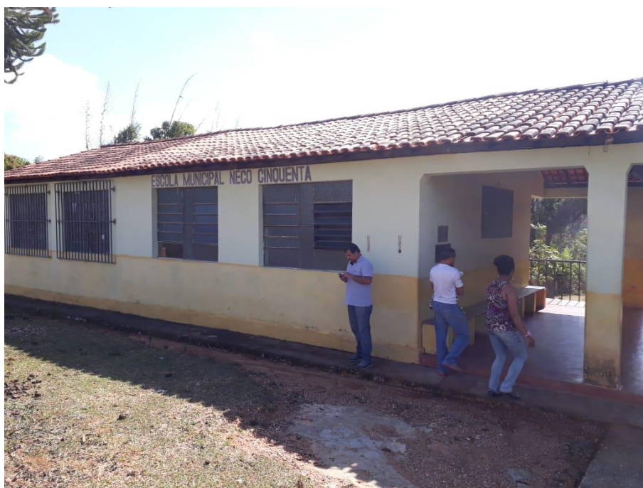
Figura 19 – Escola Municipal Neco Cinquenta, adjacente ao canteiro que será locado pela empresa LOCALMAQ Fonte: LOCALMAQ (2018)
