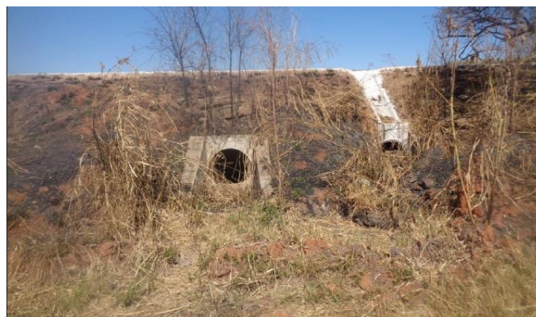
Figura 66 – Drenagem do Córrego Capão das Cinzas próxima a BR135
