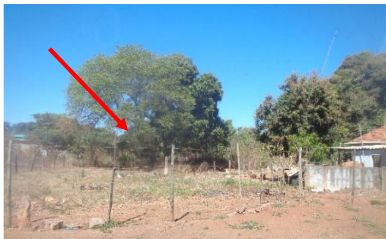
Figura 64 – Drenagem do Córrego Curralinho na área urbana do município de Corinto, Minas Gerais
