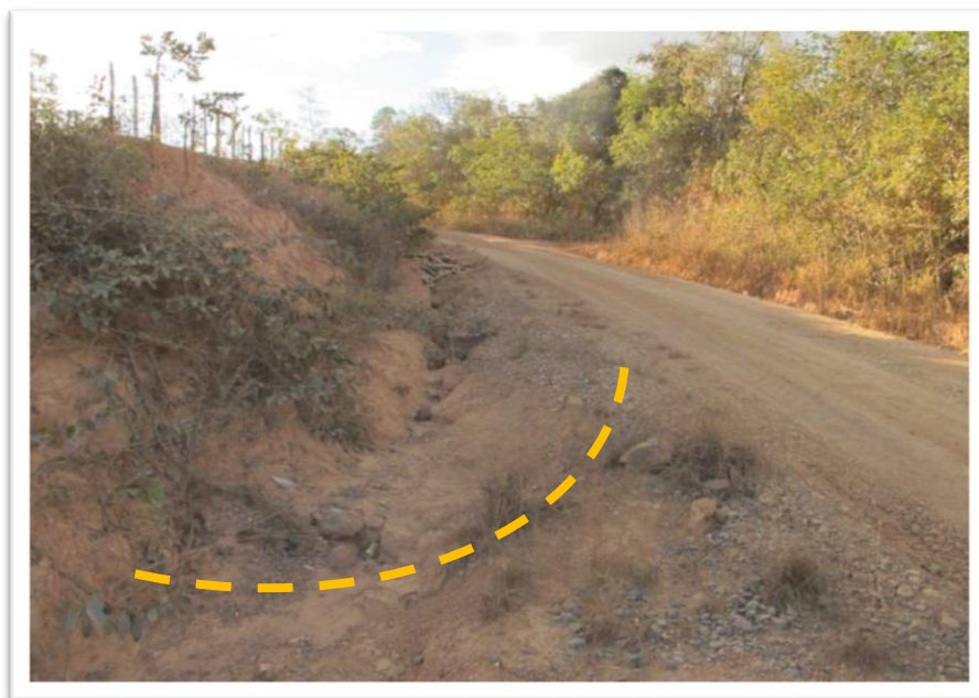
Figura 7.8 - Processo erosivo a ser disciplinado com construção de lombada, bigode e barraginha.
