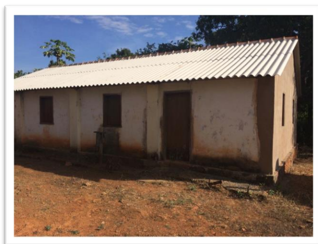
Figura 6.1 - Local onde será implantado o canteiro de obras
