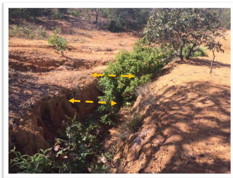
Figura 7.15 - Vista a jusante da voçoroca onde serão construídas as paliçadas.
