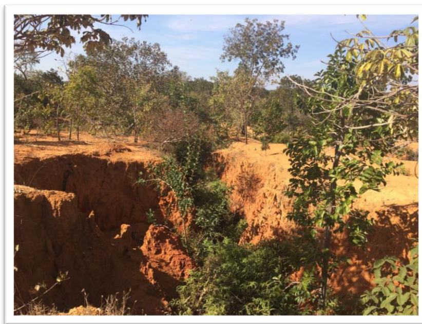
Figura 7.16 - Vista a jusante da voçoroca onde serão construídas as paliçadas.
