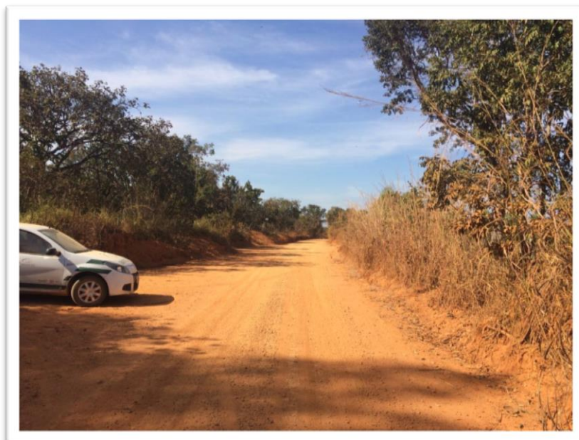
Figura 7.5 - Estrada vicinal onde serão construídos bigodes, lombadas e barraginhas
