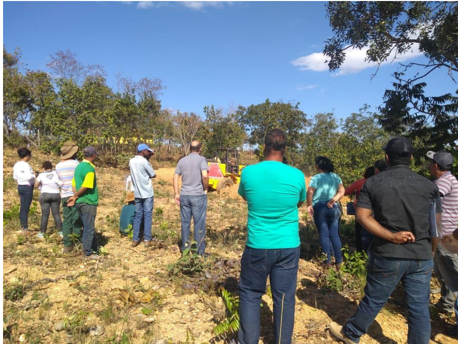
Figura 16 – Orientação na visita de campo da 1ª Oficina de Capacitação realizada pela palestrante a Sra. Poliana Valgas – construção de bacia de contenção
