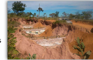
Paliçadas executadas em voçoroca Fonte: Inovesa (2017)
