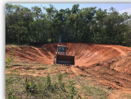
Execução de barraginhas Fonte: Inovesa (2017)
