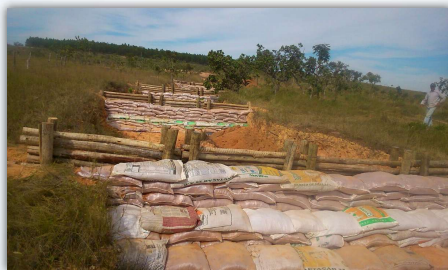
Paliçadas executadas em voçoroca Fonte: Inovesa (2017)
