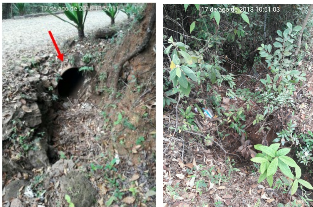
Figura 6-10 – Erosão linear em Macacos, com destaque para a manilha de drenagem de água pluvial – EROF02
