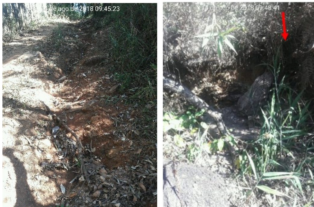
Figura 6-15 – Erosão linear no condomínio Pasárgada, com destaque para o ponto onde escoa uma nascente intermitente – EROT01
