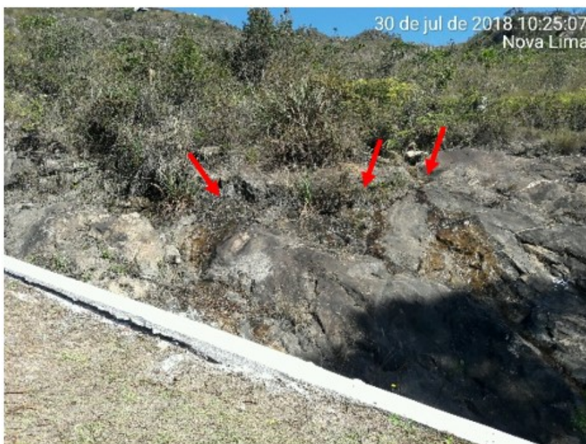
Figura 6-23 – Nascente de temporalidade perene, forma múltipla e geomorfologia afloramento rochoso – NASM01
