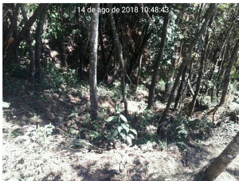
Figura 6-19 – Erosão linear no condomínio Pasárgada – EROT05
