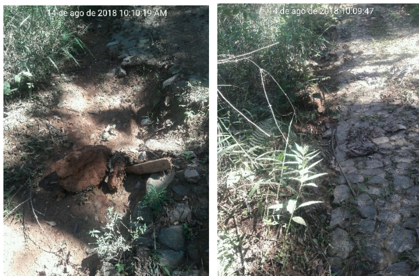
Figura 6-17 – Erosão linear no condomínio Pasárgada – EROT03
