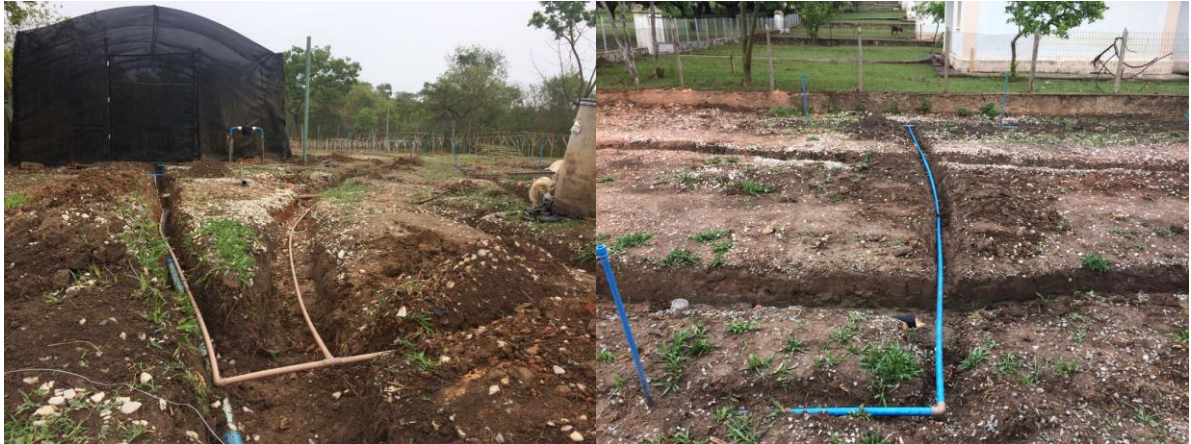
Figura 7: Distribuição subterrânea da irrigação. Fonte: GOS Florestal
