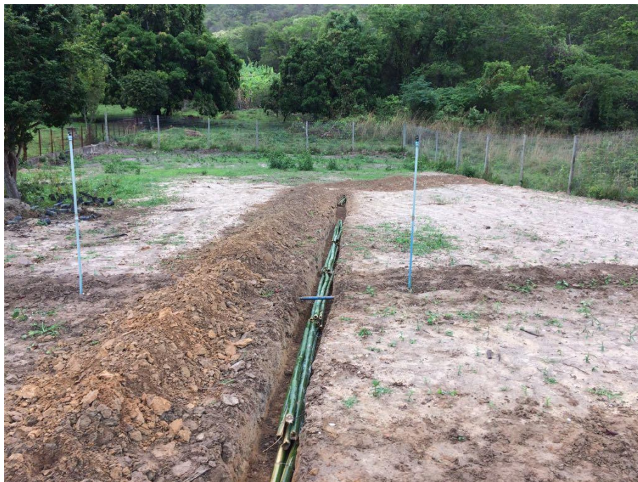
Figura 5: Implantação do sistema de drenagem. Fonte: GOS Florestal.
