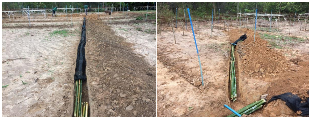
Figura 6: Utilização de técnicas de bioengenharia no sistema de drenagem. Fonte: GOS Florestal.
