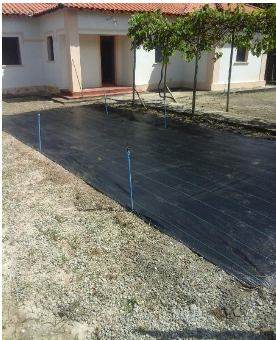
Figura 4: Rafia de solo instalada. Fonte: GOS Florestal
