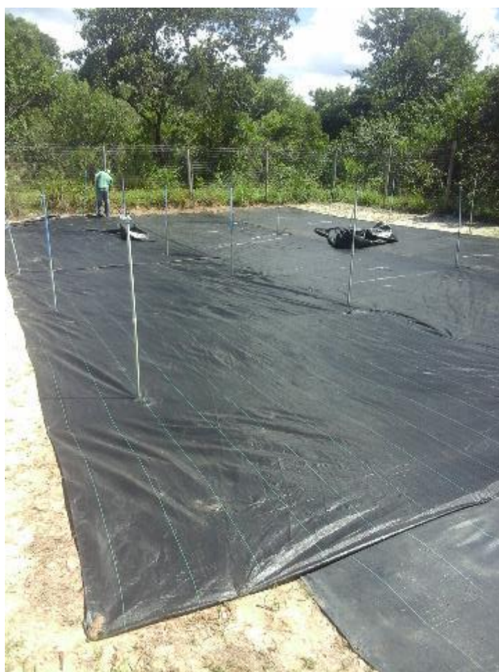
Figura 3: Instalação de rafia de solo. Fonte: GOS Florestal
