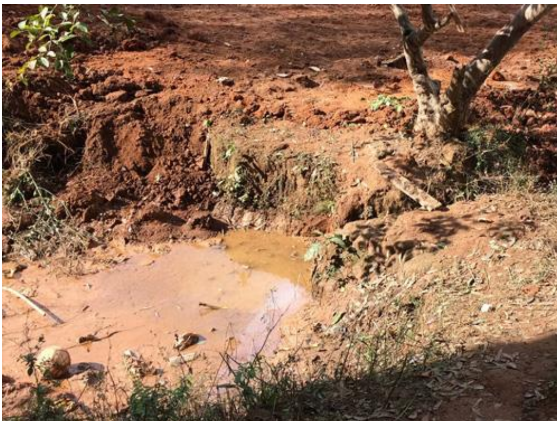
Figura 12 - Vista da área da nascente da Rua da Represa, bairro Havaí antes da intervenção
