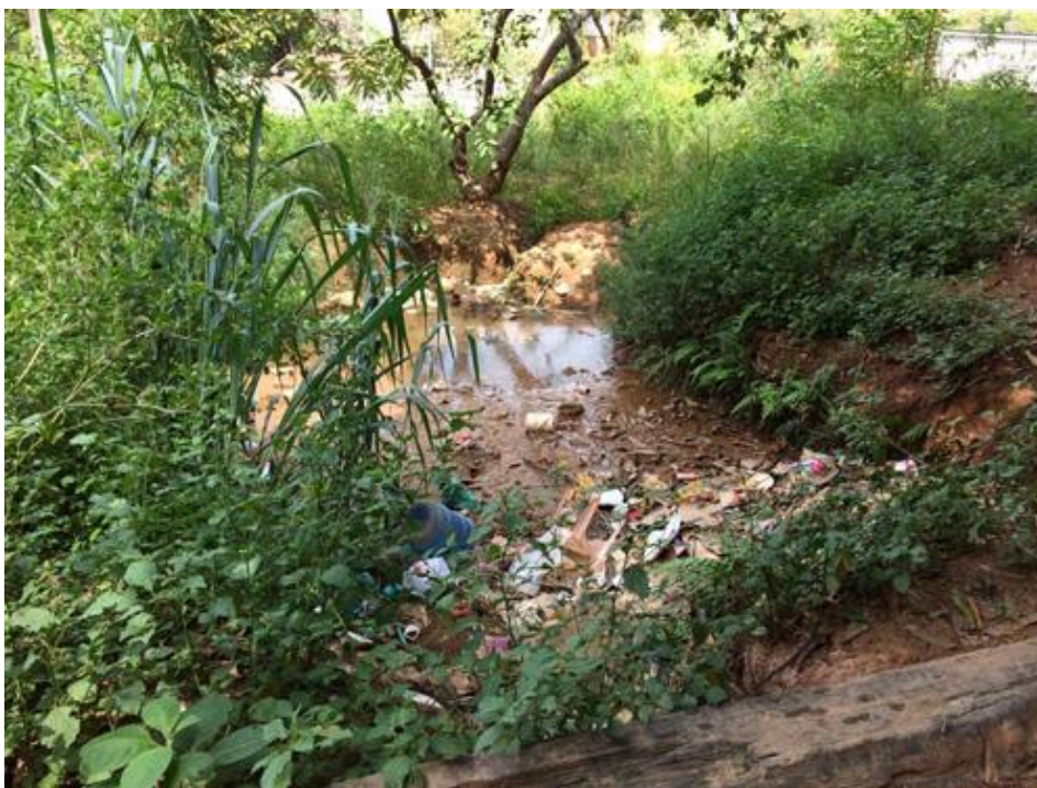
Figura 10 - Vista da área da nascente da Rua da Represa, bairro Havaí antes da intervenção
