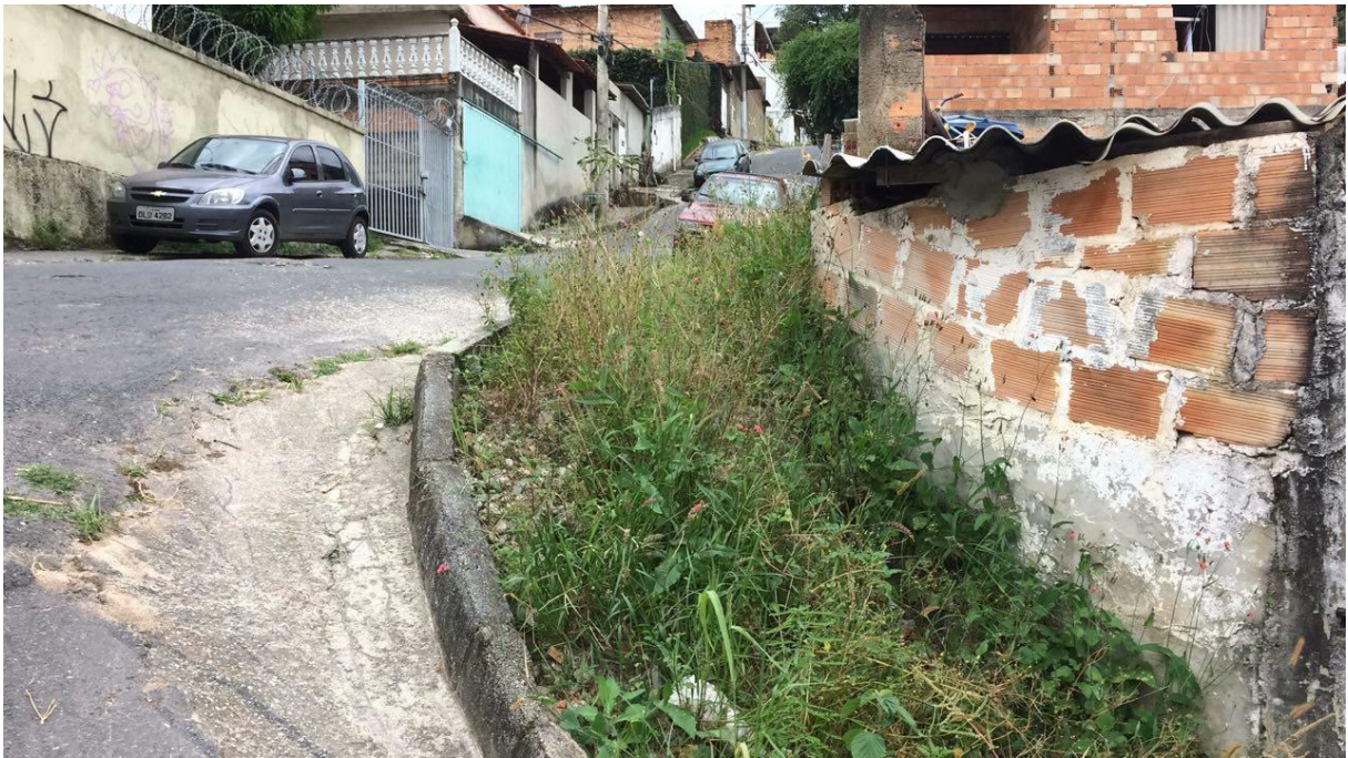
Figura 2 – Calçada na rua Minas Gerais, ao lado da nascente da família Gomes da Silva antes da intervenção
