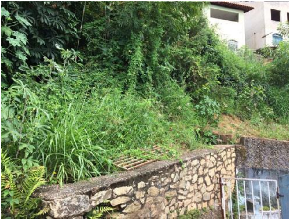
Figura 6 – Vista da área da nascente Bica da Dona Zélia, no bairro Diamante, antes da intervenção
