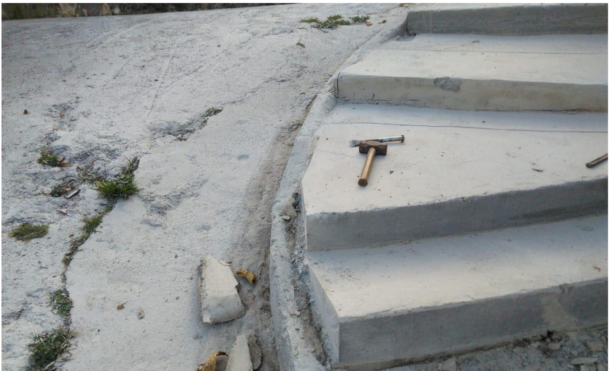
Figura 3 - Calçada na rua Minas Gerais ao lado da nascente da família Gomes da Silva depois da intervenção
