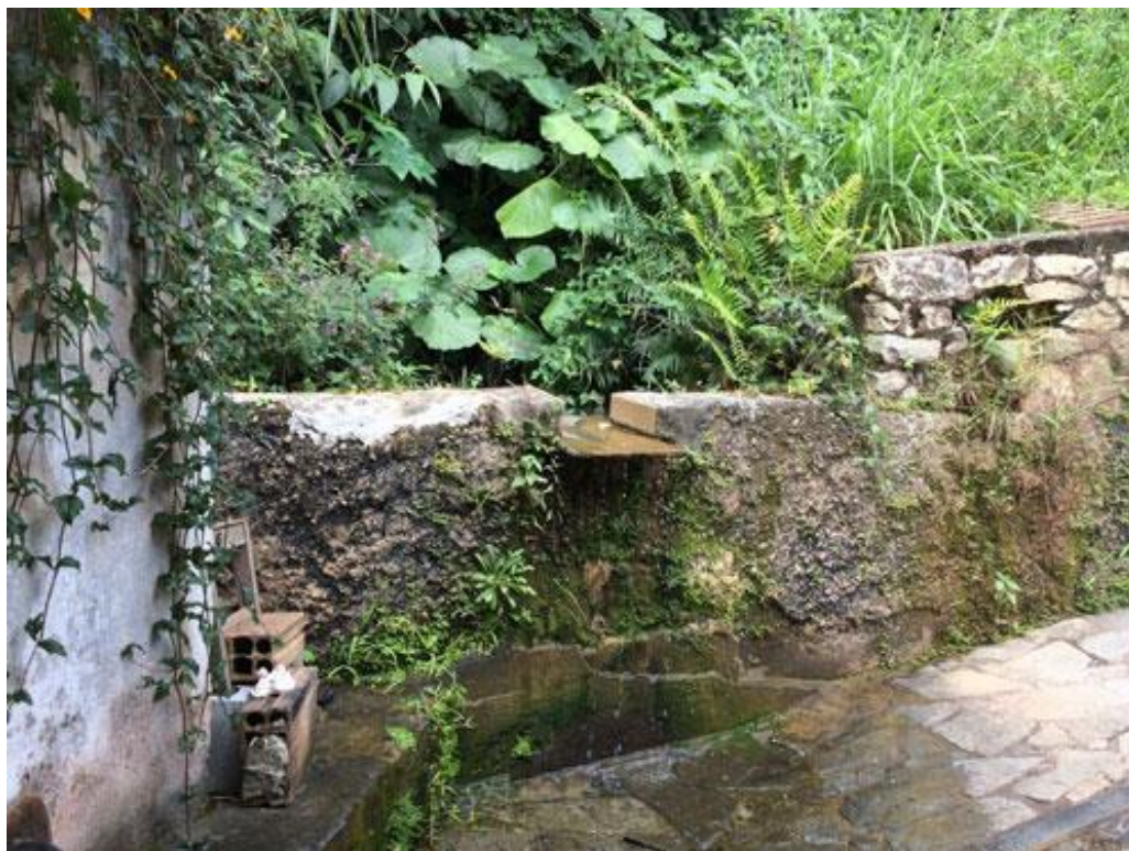
Figura 8 - Vista da área da nascente Bica da Dona Zélia, no bairro Diamante, antes da intervenção
