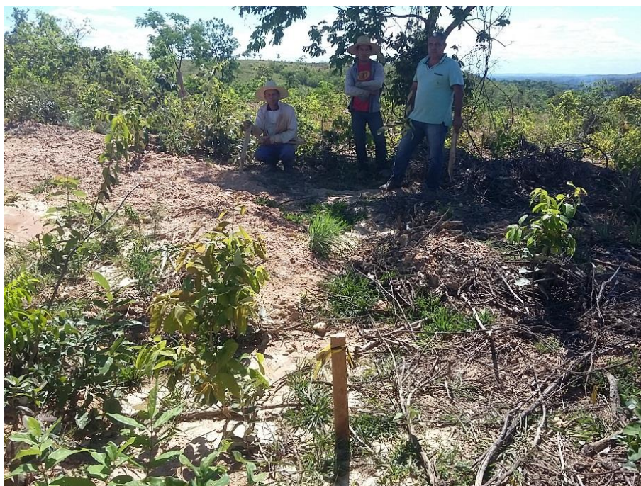
Figura 7.1 – Locação e estaqueamento das bacias de contenção
