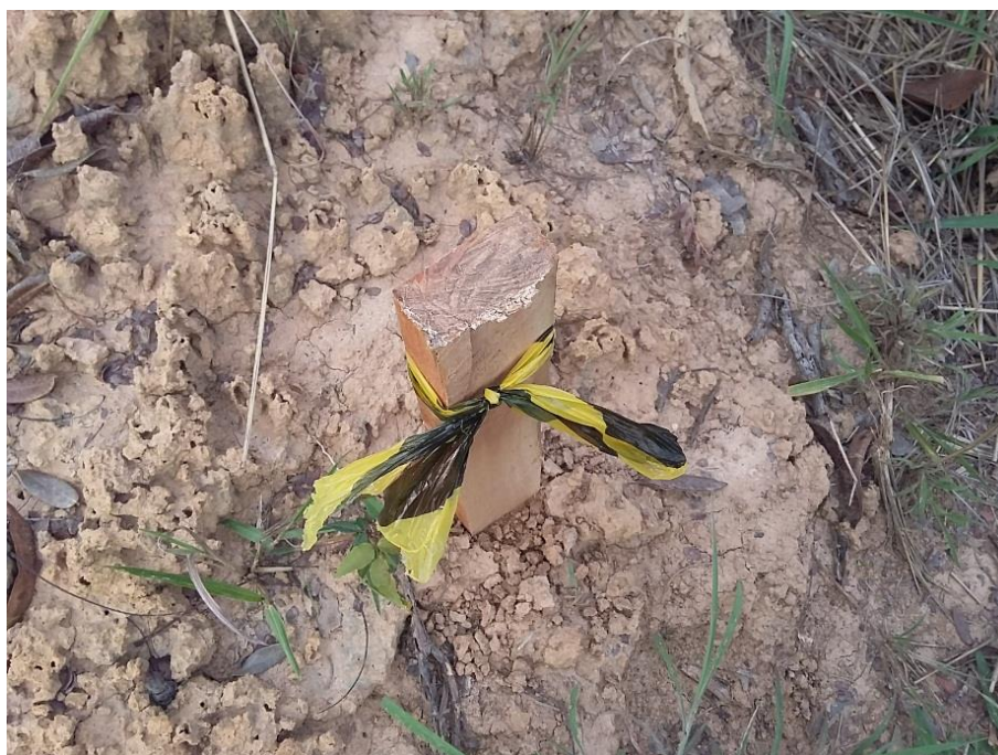
Figura 7.3 – Locação e estaqueamento das bacias de contenção
