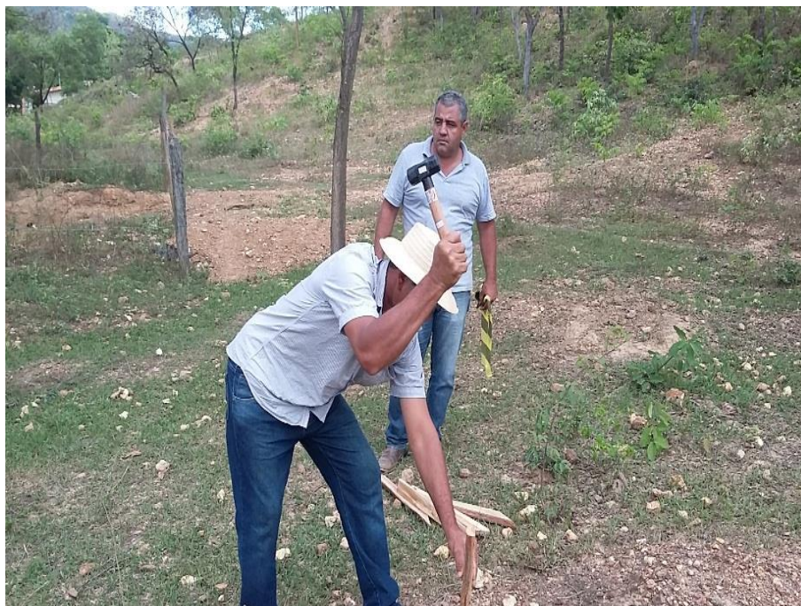
Figura 7.2 – Locação e estaqueamento das bacias de contenção
