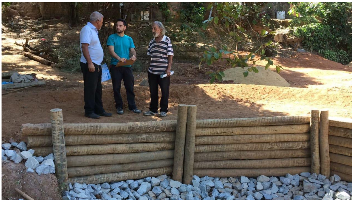
Figura 51 – Visita à nascente AR-032 e encontro com representantes locais para mobilização do projeto hidroambiental da UTE Ribeirão Arrudas
