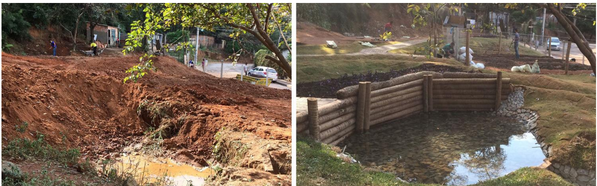
Figura 6 - Registro fotográfico do "antes e depois" na área da nascente AR-032 (Bairro Havaí, Belo Horizonte, Minas Gerais)
