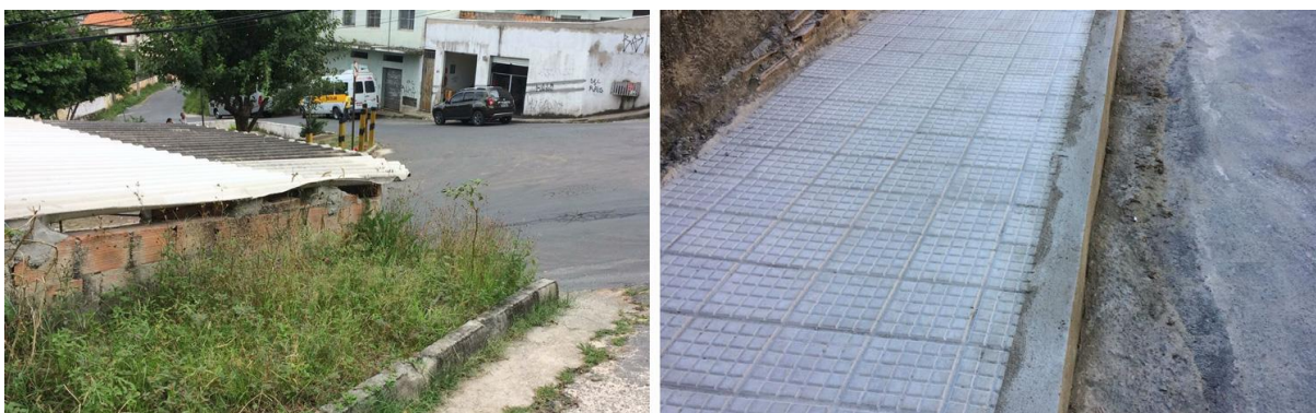
Figura 2 – Registro fotográfico do "antes e depois" da calçada que dá acesso à área da nascente AR-078 (Sabará, Minas Gerais)
