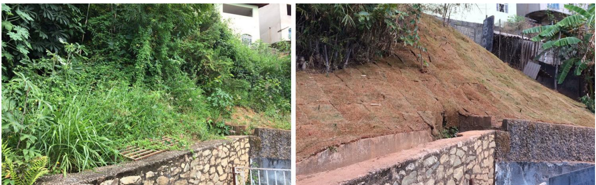
Figura 4 – Registro fotográfico do "antes e depois" do talude localizado na área da nascente AR-170 (Regional Barreiro, Belo Horizonte, Minas Gerais)
