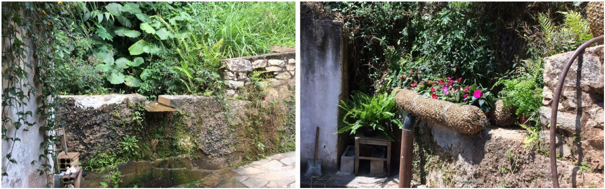
Figura 5 – Registro fotográfico do "antes e depois" do talude localizado na área da nascente AR-170 (Regional Barreiro, Belo Horizonte, Minas Gerais)
