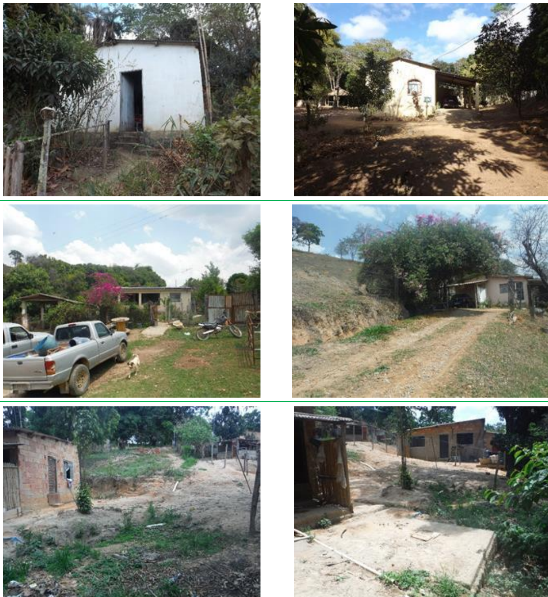
Figura 8.4 – Residências a serem beneficiadas em Ponte Alta, Ponte Alta/Pimentel e Quilombo Pimentel.
