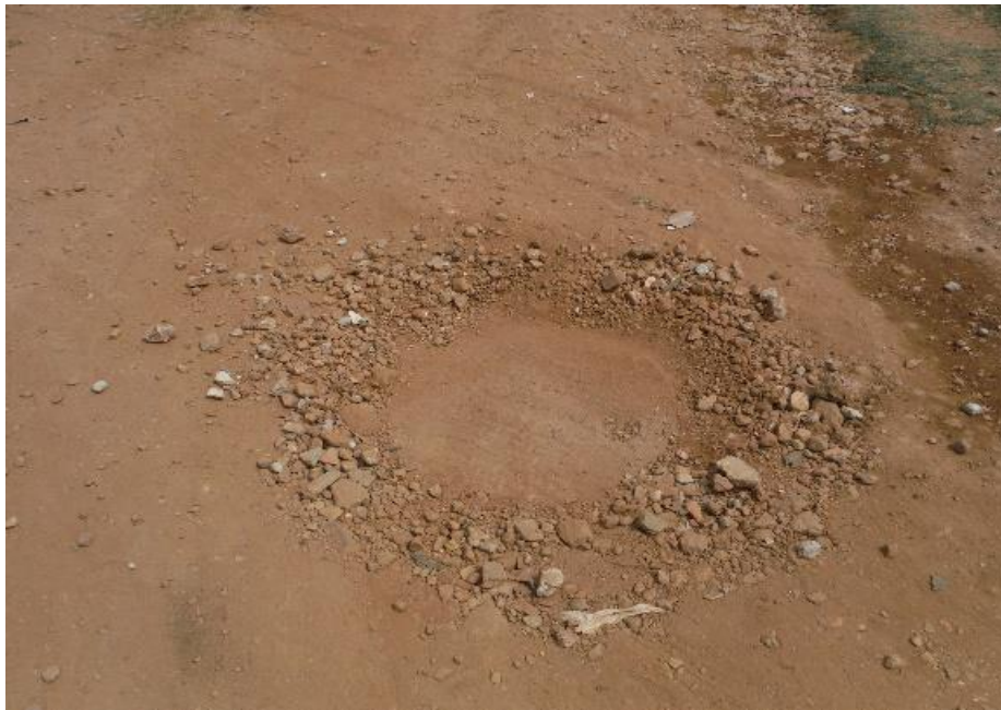
Figura 2.3 – Vista de Poço de Visita recoberto.
