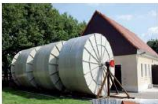
Rathewalde (Germany), 1.000 PE rehabilitation – Ø 3,9 m disks
