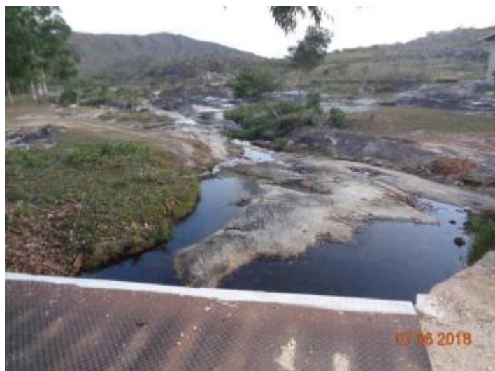
Figura 50 – Assoreamento identificado no Córrego Engenho da Bília
