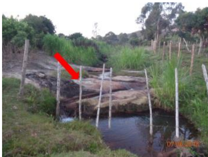
Figura 49 – Presença de afloramento rochoso nos locais de intervenção do cercamento – Área 3
