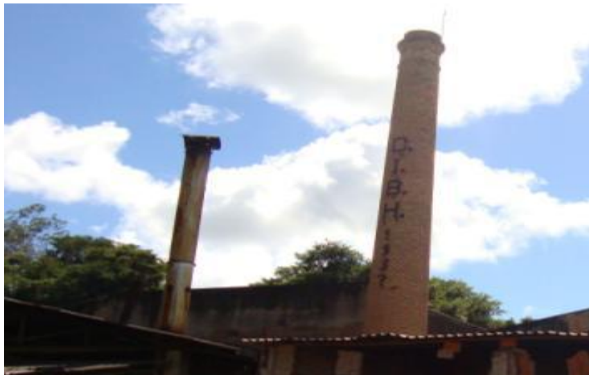
Figura 40: Chaminé da Antiga Fábrica de Tecidos
