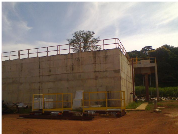
Figura 91: Construção dos reatores -ETE
