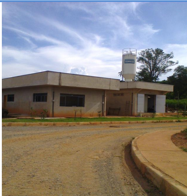
Figura 90: Entrada da ETE Pedro Leopoldo
