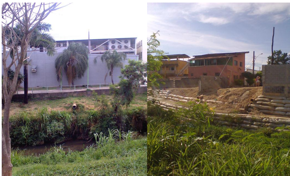
Figura 89: Lançamento de água pluvial e de esgoto diretamente nos rios
