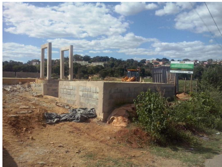
Figura 95: Construção da Elevatória de Lagoa de Santo Antônio
