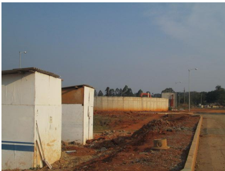
Figura 99: Obras da ETE Pedro Leopoldo
