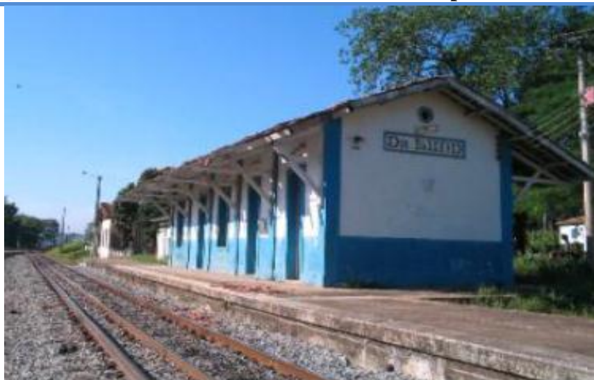
Figura 41: Estação Ferroviária do Distrito de Dr. Lund
