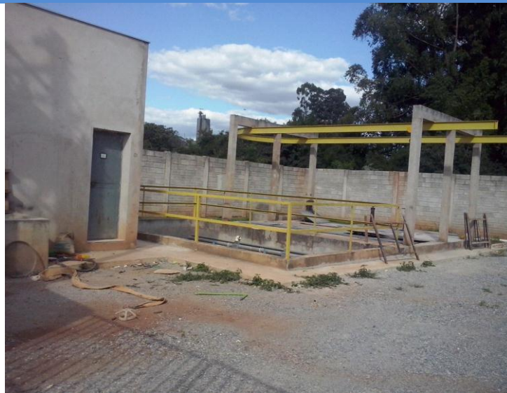
Figura 94: Construção da Elevatória da Sede
