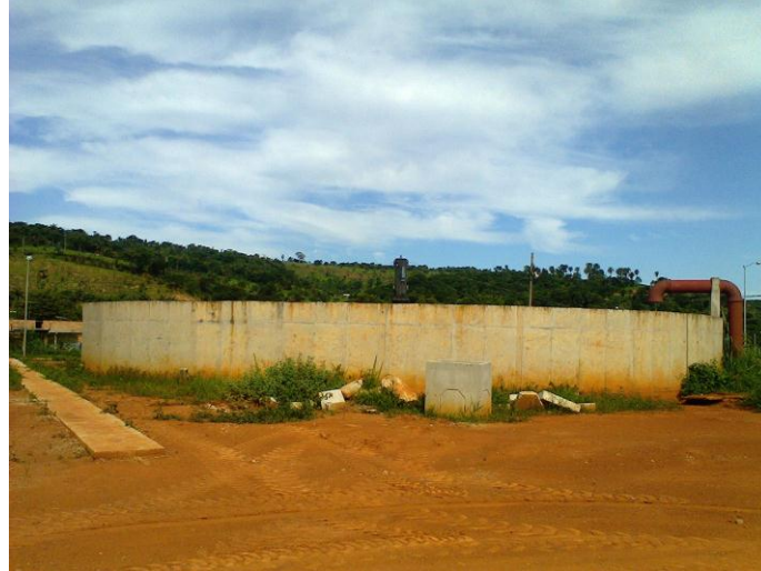
Figura 92: Construção dos aeradores - ETE
