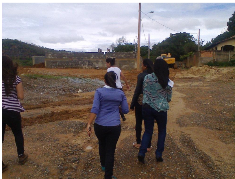
Figura 98: Estação Elevatória de Esgoto na Lagoa de Santo Antônio
