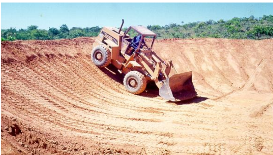
Figura 20: Construção da Barraginha
