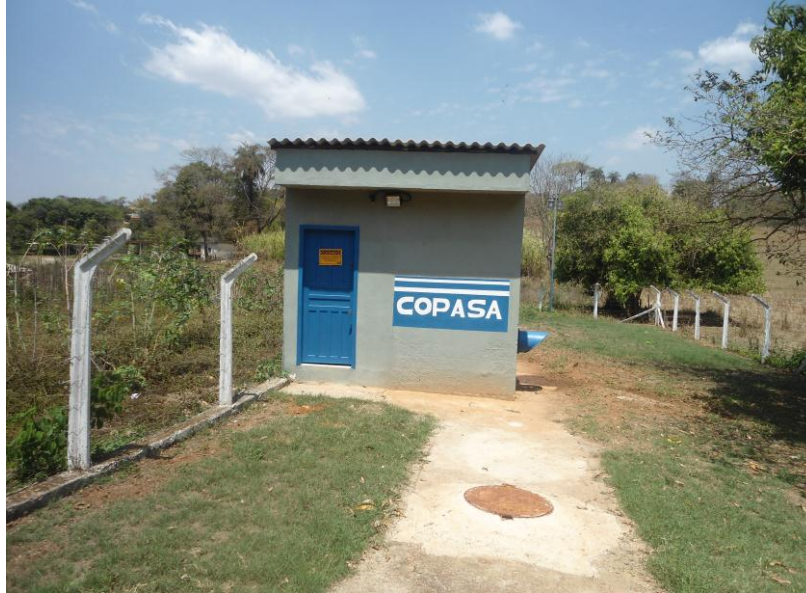
Figura 85: Casa de Química dos Poços Profundos de Fidalgo
