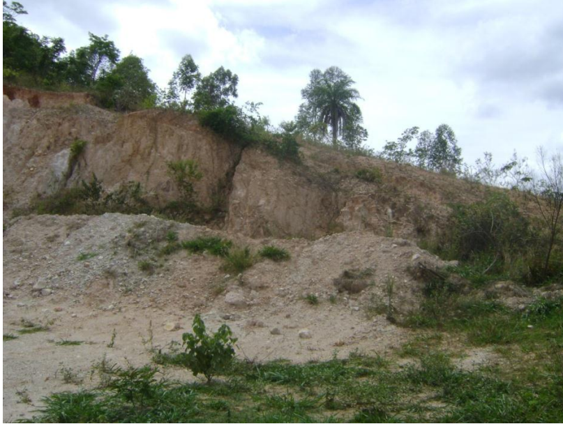
Figura 6: Área de retirada de cascalho na Região Rural de Matos
