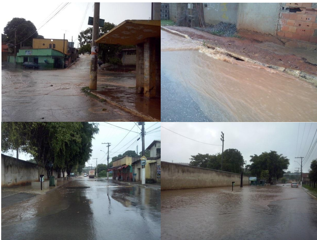
Figura 137: Pontos de alagamento em Lagoa de Santo Antônio
