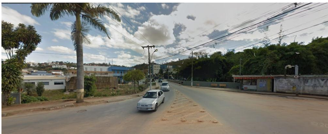
Figura 122: Ponte do canal do Ribeirão da Mata
