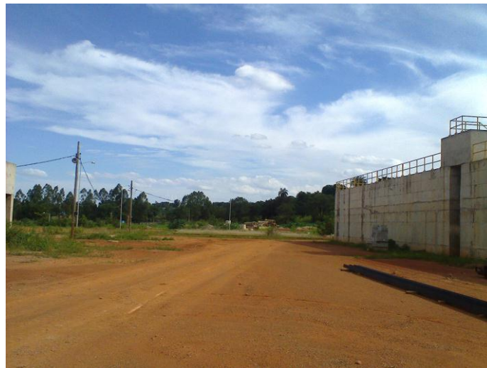
Figura 93: Local de disposição do lodo ao fundo -ETE
