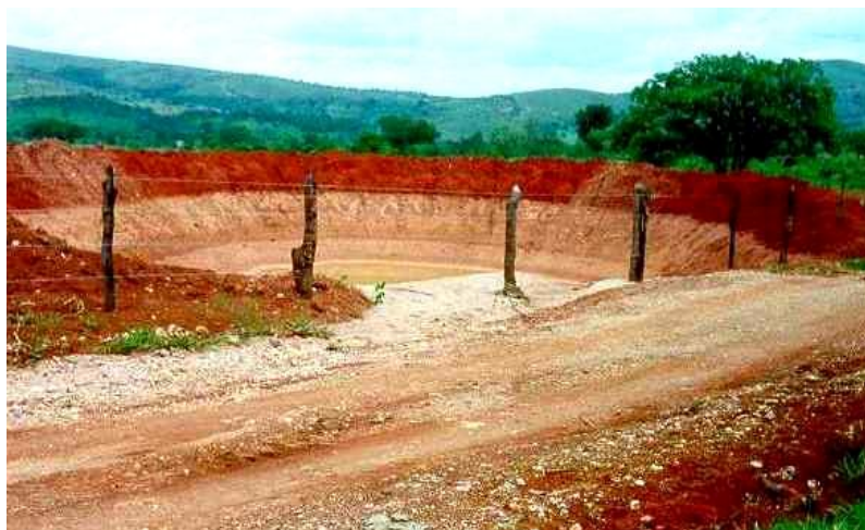
Figura 22: Infiltração e recarga do lençol
