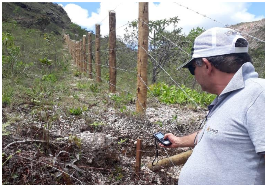
Figura 9 - Locação topográfica realizada no trecho 05 da Área 03 do projeto Fonte: LOCALMAQ, 2018
