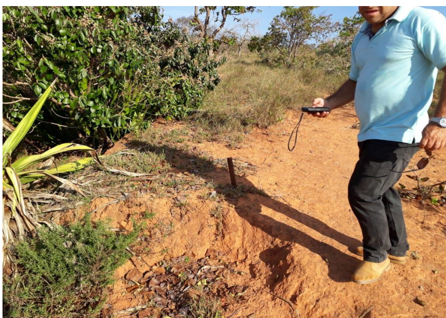
Figura 5 - Locação topográfica realizada no trecho 01 da Área 01 do projeto Fonte: LOCALMAQ, 2018
