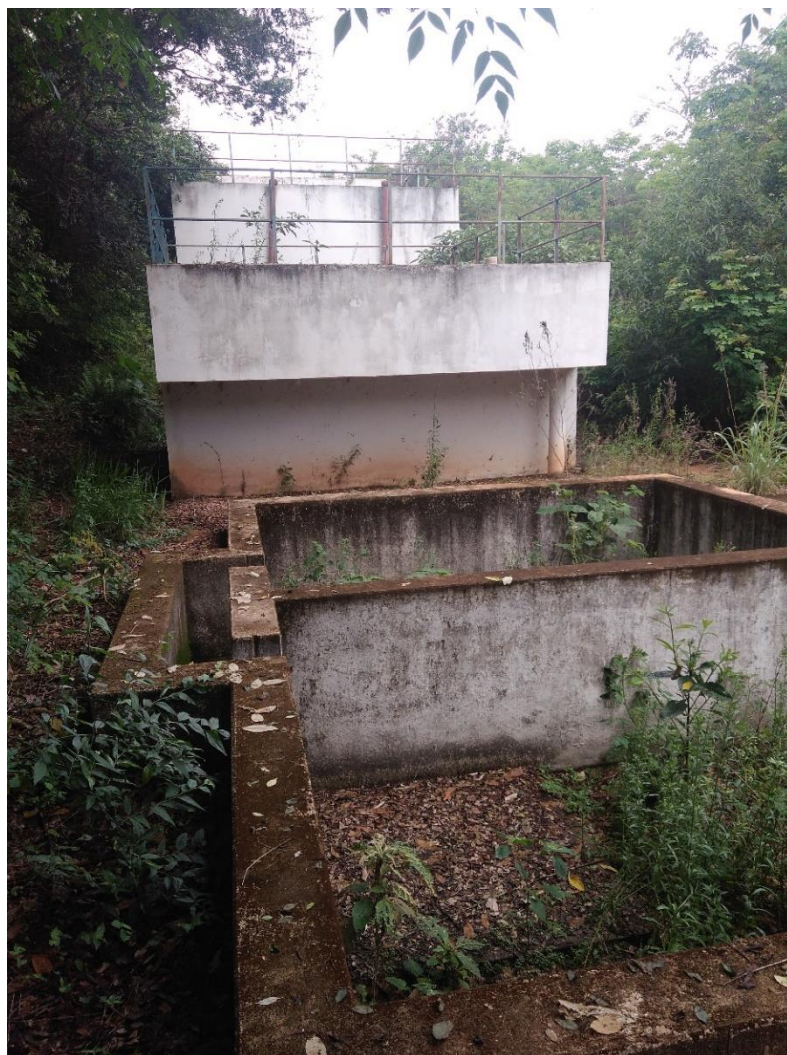
Figura 6.4 - Estação de Tratamento de Esgoto (não está em operação)
