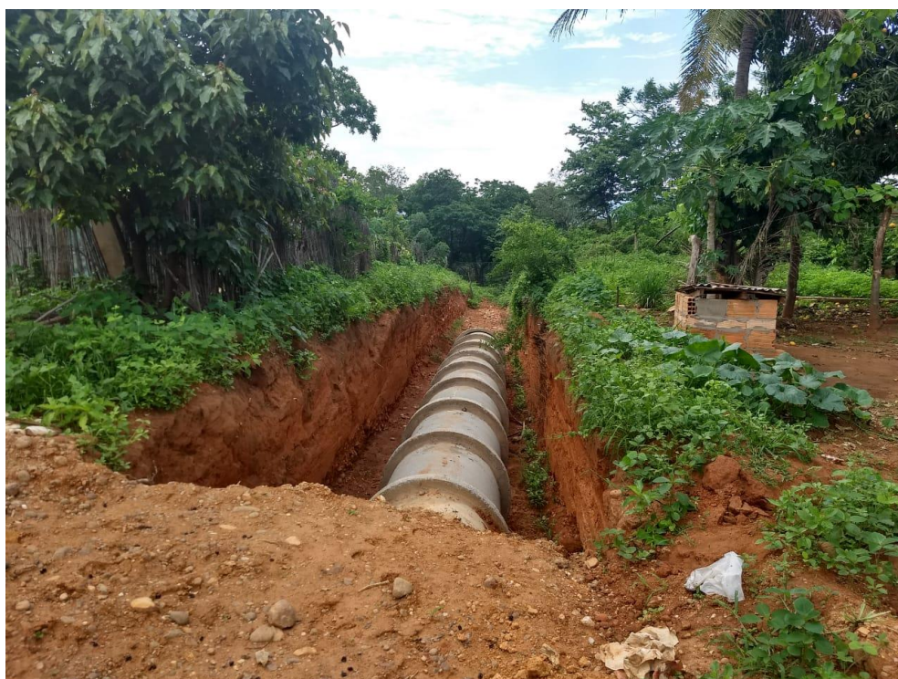
Figura 6.5 - Obra do sistema de drenagem
