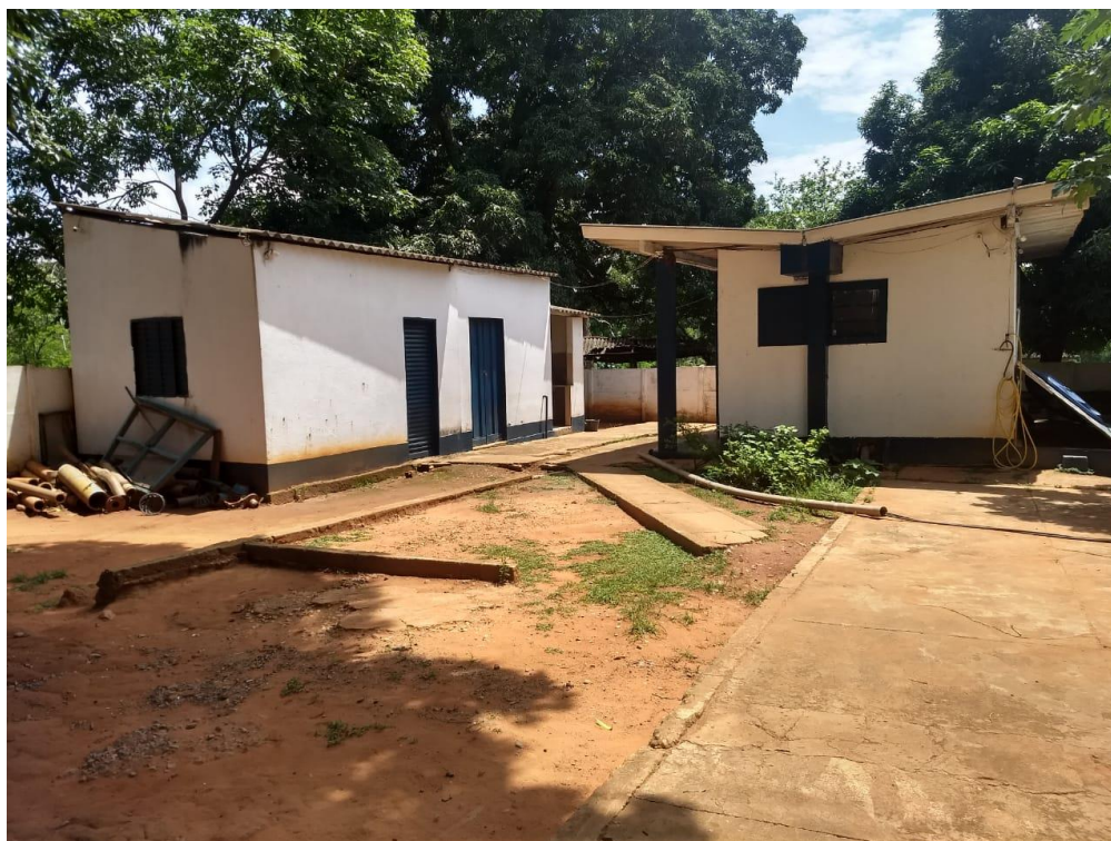
Figura 6.3 - Estação de Tratamento de Água
