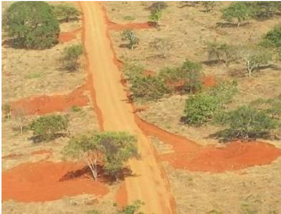
Figura 5.6 - Exemplos bacias de contenção tipo 1 – lombada, bigode e bacia
