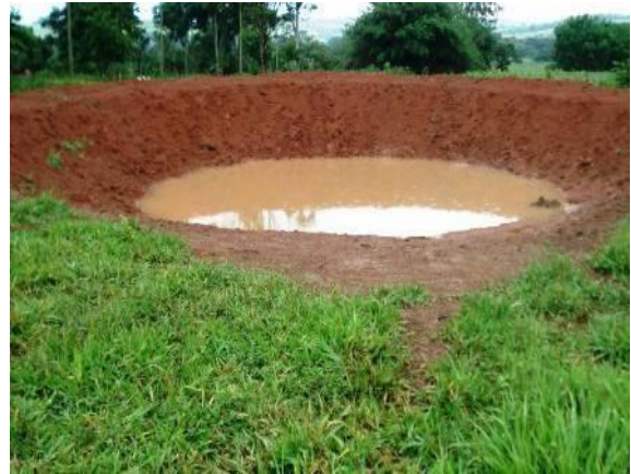
Figura 5.6 - Exemplos bacias de contenção tipo 1 – lombada, bigode e bacia
