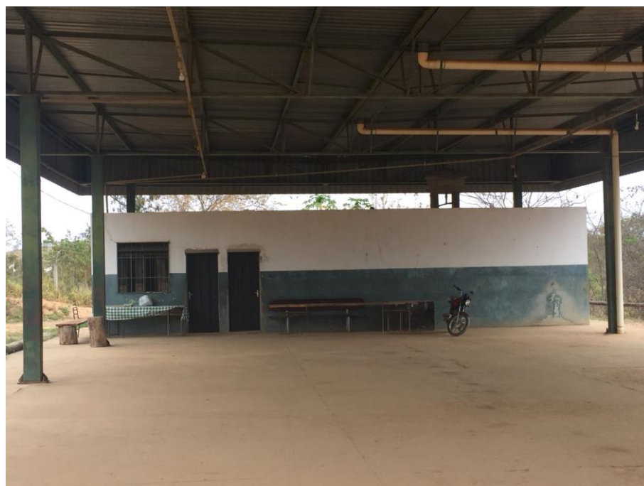
Figura 5.16 - Galpão para estacionar máquinas e apoio a funcionários na comunidade Abelhas
