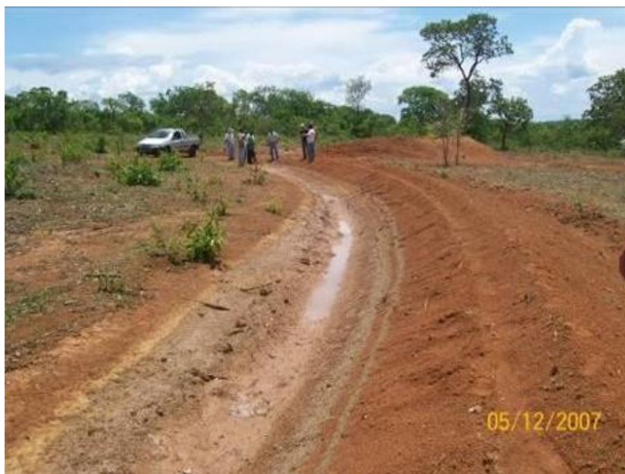
Figura 5.9 - Exemplo de terraço executado
