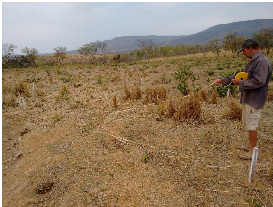
Figura 7.2 – Locação e estaqueamento das bacias de captação com auxílio da trena para alcançar os 14 metros de diâmetro
