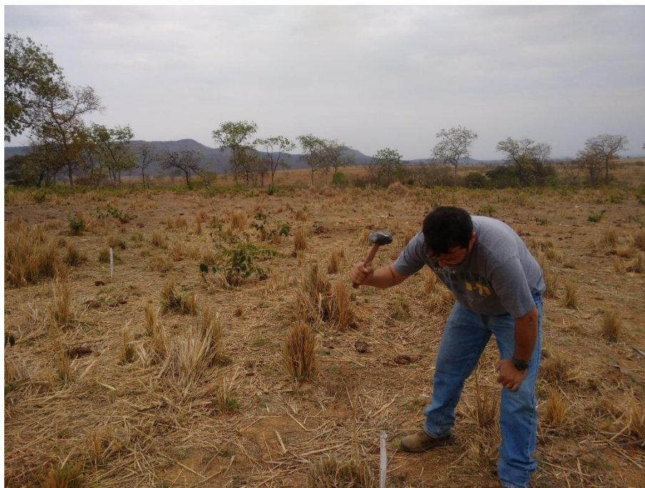
Figura 7.1 – Locação e estaqueamento das bacias de captação
