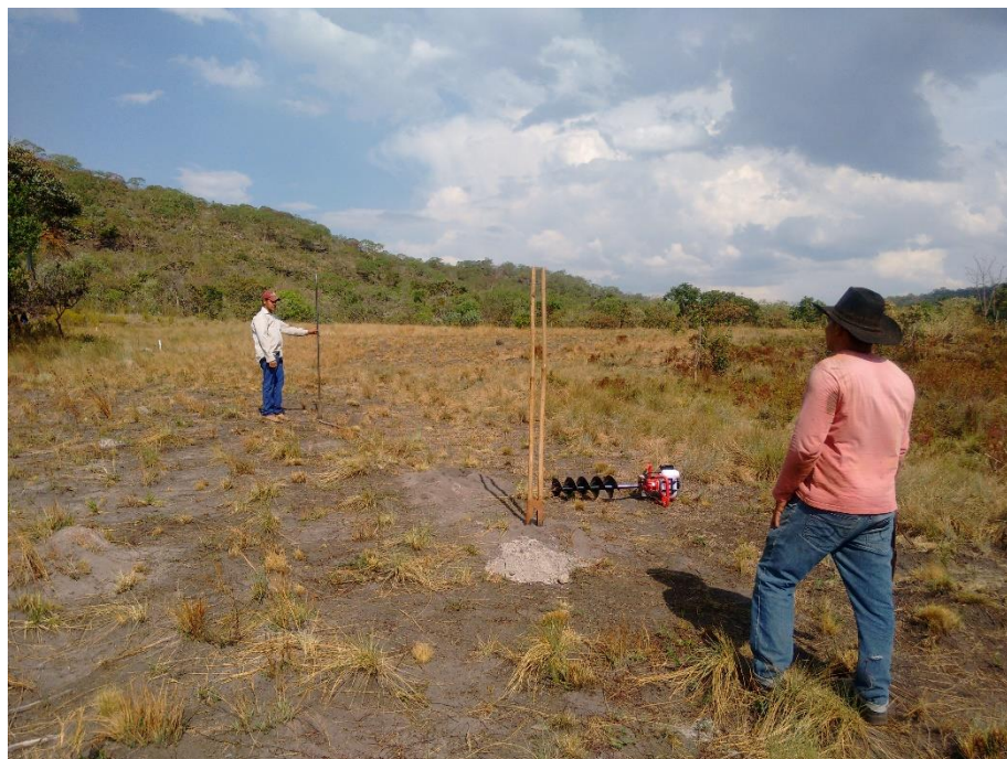
Figura 7.3 – Locação, balizamento e estaqueamento da cerca
