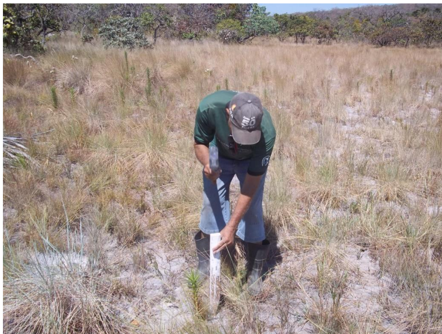
Figura 7.1 – Locação e estaqueamento das bacias de captação na sub-bacia hidrográfica do Ribeirão Bananal
