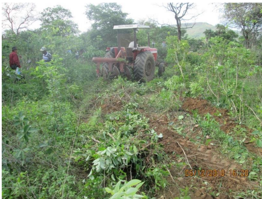
Figura 5.53 – Trator com arado construindo um terraço em gradiente associado à barraginha – 2ª Palestra e atividade prática do projeto hidroambiental – UTE Guaicuí
